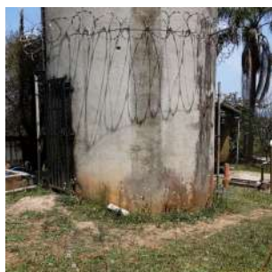
Foto 7 - Vista geral da base do reservatório.
