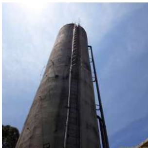
Foto 9 - Escada de acesso ao topo do reservatório.
