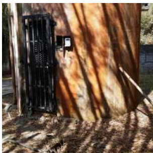
Foto 8 - Portão de acesso ao interior do reservatório.
