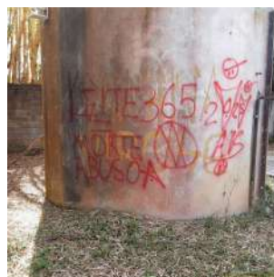
Foto 9 - Detalhe da base do reservatório.
