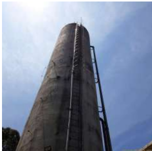
Foto 9 - Escada de acesso ao topo do reservatório.
