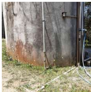
Foto 8 - Vista geral da base do reservatório.
