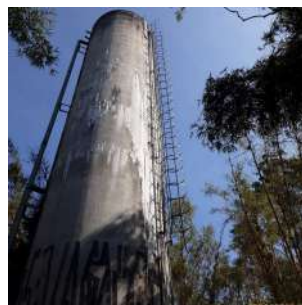
Foto 7 - Escada de acesso ao topo do reservatório.
