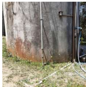
Foto 8 - Vista geral da base do reservatório.
