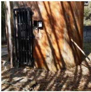
Foto 8 - Portão de acesso ao interior do reservatório.
