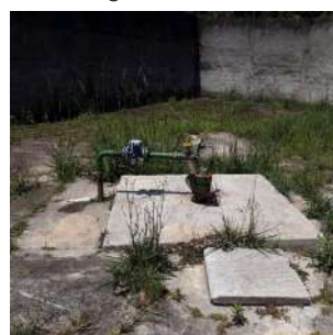
Foto 3 - Detalhe da laje de proteção.
