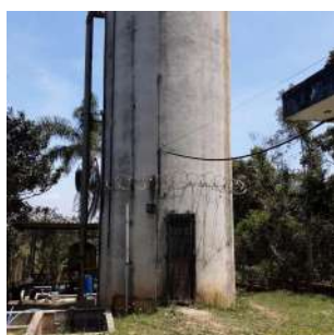
Foto 5 - Vista geral do reservatório.
