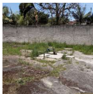
Foto 2 - Vista geral da estrutura do poço.
