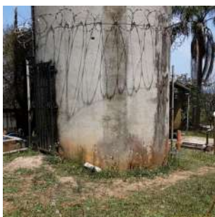
Foto 7 - Vista geral da base do reservatório.
