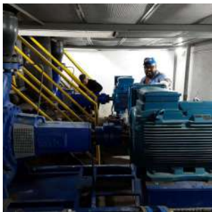
Foto 4 - Vista geral do interior da estrutura de proteção acústica.
