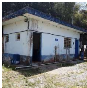
Foto 4 - Edificação de apoio que abriga os equipamentos de cloração e fluoretação da água que vem dos Poços Boa Vista I e II.
