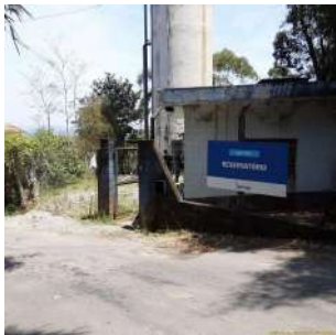
Foto 2 - Vista de geral do cercamento e portão de acesso à área.
