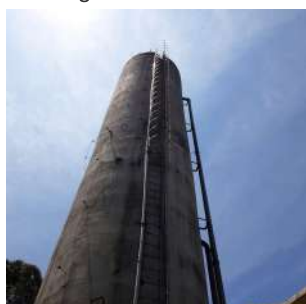
Foto 9 - Escada de acesso ao topo do reservatório.
