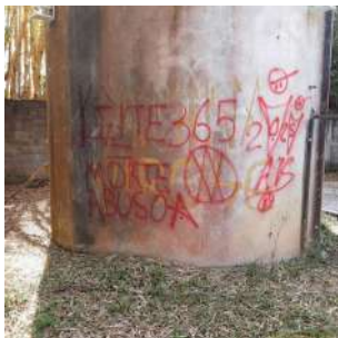
Foto 9 - Detalhe da base do reservatório.
