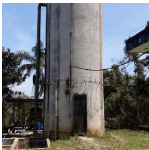
Foto 5 - Vista geral do reservatório.
