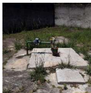
Foto 3 - Detalhe da laje de proteção.
