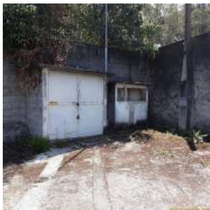
Foto 6 - Abrigo do painel elétrico do poço.
