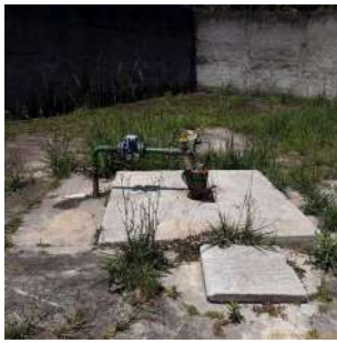
Foto 3 - Detalhe da laje de proteção.
