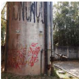
Foto 1 - Detalhe do fio do para raios partido.
