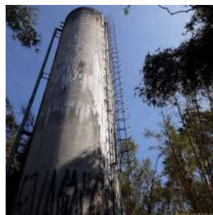
Foto 7 - Escada de acesso ao topo do reservatório.
