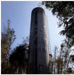
Foto 3 - Vista geral do reservatório.
