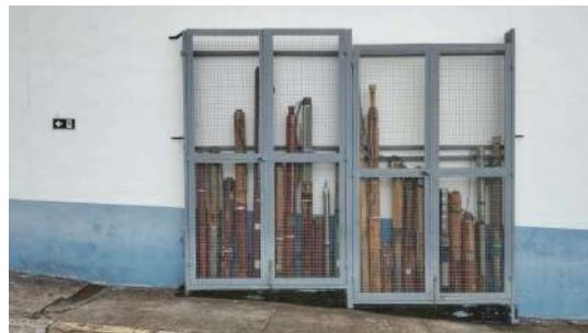
Foto 10 - Bombas reserva dos poços.
