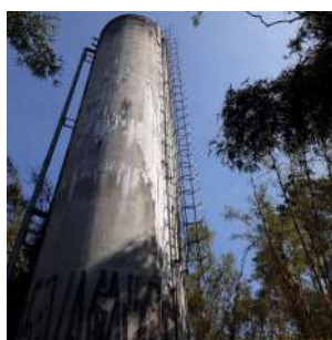
Foto 7 - Escada de acesso ao topo do reservatório.
