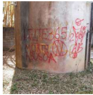
Foto 9 - Detalhe da base do reservatório.
