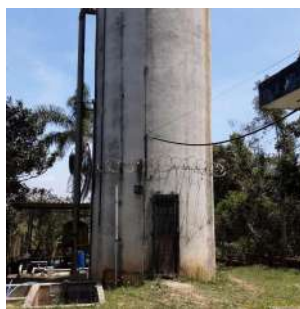
Foto 5 - Vista geral do reservatório.
