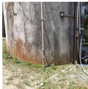
Foto 8 - Vista geral da base do reservatório.
