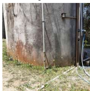
Foto 8 - Vista geral da base do reservatório.
