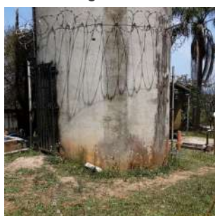
Foto 7 - Vista geral da base do reservatório.
