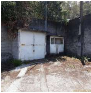
Foto 6 - Abrigo do painel elétrico do poço.
