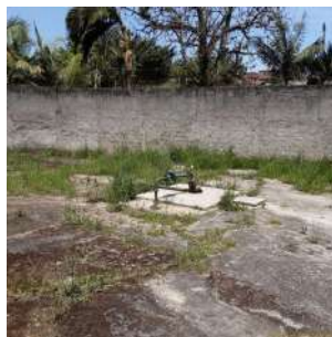
Foto 2 - Vista geral da estrutura do poço.
