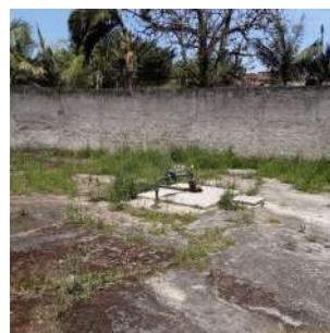
Foto 2 - Vista geral da estrutura do poço.
