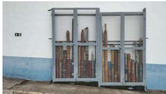
Foto 10 - Bombas reserva dos poços.
