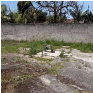
Foto 2 - Vista geral da estrutura do poço.
