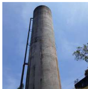
Foto 6 - Vista geral do reservatório.
