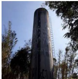
Foto 3 - Vista geral do reservatório.
