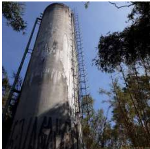
Foto 7 - Escada de acesso ao topo do reservatório.
