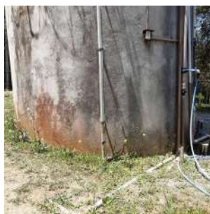
Foto 8 - Vista geral da base do reservatório.
