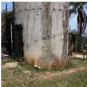
Foto 7 - Vista geral da base do reservatório.
