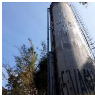
Foto 6 - Detalhe da tubulação de entrada da água do reservatório. Ao lado está o tubo extravasor.
