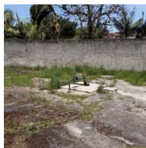
Foto 2 - Vista geral da estrutura do poço.
