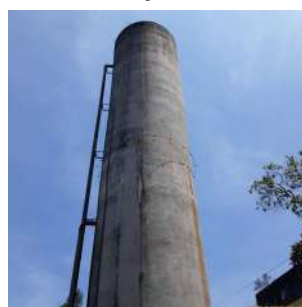
Foto 6 - Vista geral do reservatório.
