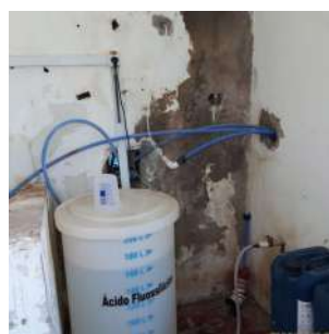
Foto 17 - Tanque de Ácido Fluossilícico.
