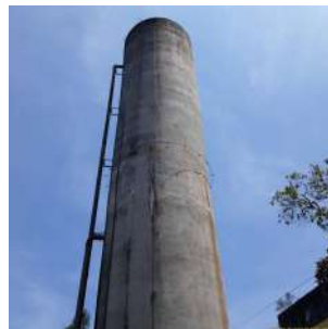
Foto 6 - Vista geral do reservatório.
