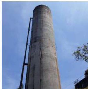
Foto 6 - Vista geral do reservatório.
