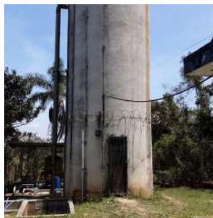
Foto 5 - Vista geral do reservatório.
