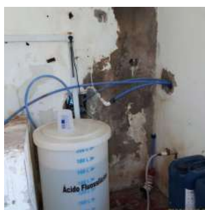
Foto 17 - Tanque de Ácido Fluossilícico.
