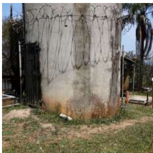
Foto 7 - Vista geral da base do reservatório.
