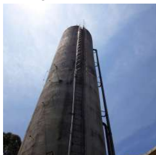
Foto 9 - Escada de acesso ao topo do reservatório.
