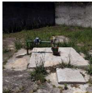
Foto 3 - Detalhe da laje de proteção.
