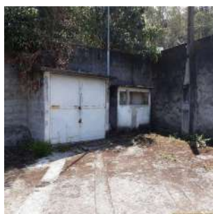
Foto 6 - Abrigo do painel elétrico do poço.
