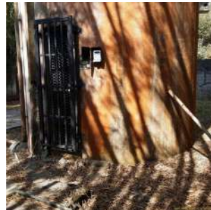
Foto 8 - Portão de acesso ao interior do reservatório.
