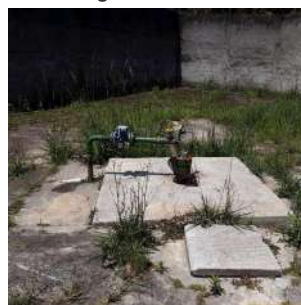
Foto 3 - Detalhe da laje de proteção.
