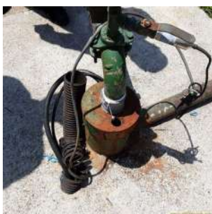
Foto 1 - Detalhe do cavalete do poço sem tubo de medição de nível.
