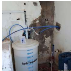
Foto 17 - Tanque de Ácido Fluossilícico.
