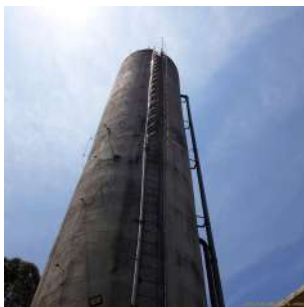
Foto 9 - Escada de acesso ao topo do reservatório.
