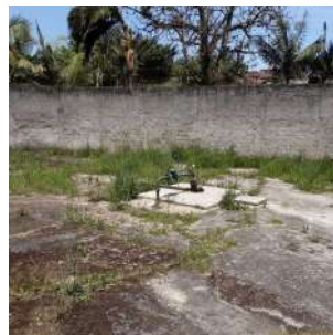
Foto 2 - Vista geral da estrutura do poço.
