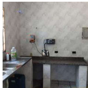
Foto 18 - Bomba dosadora de Ácido Fluossilícico.
