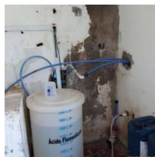
Foto 17 - Tanque de Ácido Fluossilícico.
