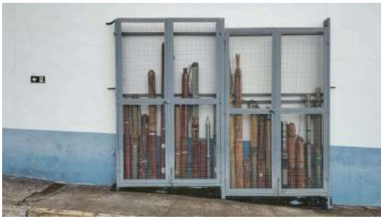
Foto 10 - Bombas reserva dos poços.
