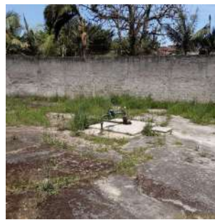
Foto 2 - Vista geral da estrutura do poço.
