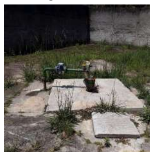
Foto 3 - Detalhe da laje de proteção.
