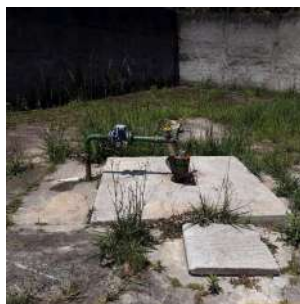
Foto 3 - Detalhe da laje de proteção.
