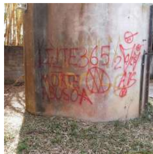
Foto 9 - Detalhe da base do reservatório.
