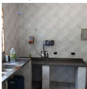
Foto 18 - Bomba dosadora de Ácido Fluossilícico.
