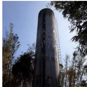
Foto 3 - Vista geral do reservatório.
