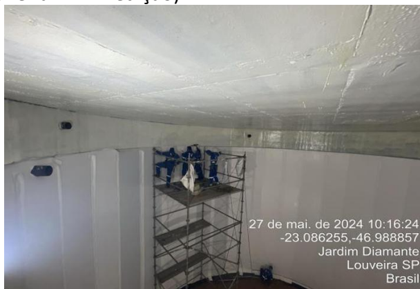
Figura TEC 5 – Impermeabilização dos Reservatórios Popular IV e Jardim Juliana (relatório fotográfico da SAE Louveira – 4ª medição).
