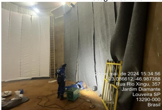
Figura TEC 5 – Impermeabilização dos Reservatórios Popular IV e Jardim Juliana (relatório fotográfico da SAE Louveira – 4ª medição).
