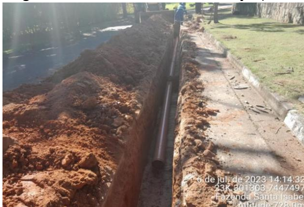
Figura TEC 3 – Rede coletora de esgoto no loteamento Residencial Primavera (relatório fotográfico da SAE Louveira – 7ª medição).
