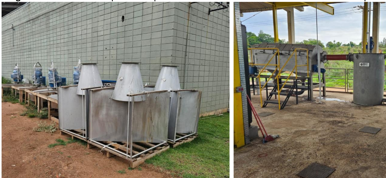
Figura TEC 6 - Aeradores para ETE Ypê e Martinho Prado e tratamento de lodo da ETE Ypê.
