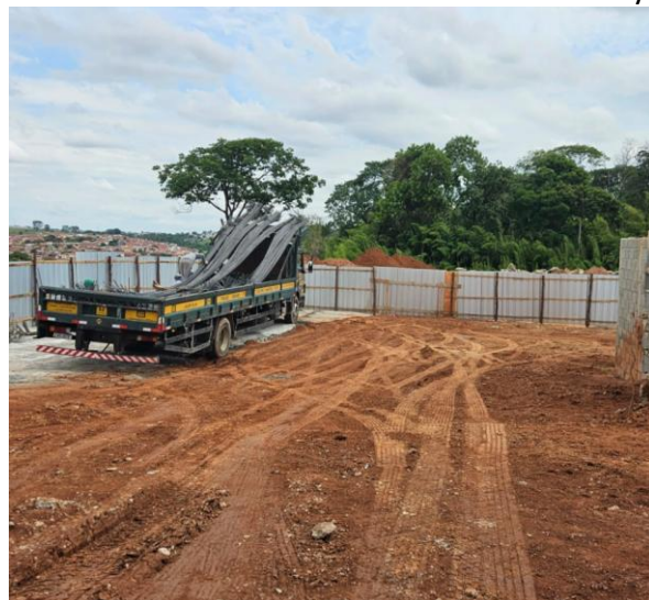
Figura TEC 8 - Serviço de aterro no terreno onde será executado o novo Reservatório Itacolomy.
