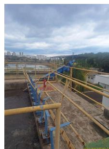
Foto 2 - Rosca transportadora não operante
