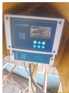
Foto 9 - Conversor do macromedidor e leitura de vazão no momento
