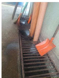
Foto 12 - Clarificado da desidratação do lodo
