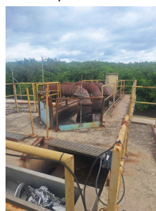
Foto 6 - Tratamento Preliminar - seção sem gradeamento
