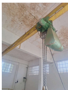
Foto 5 - Talha para içamento dos conjuntos motobomba
