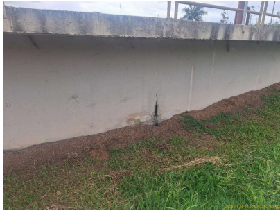
Foto 1 - Ponto de infiltração no Decantador 2 Foto 2 - Ponto de infiltração no Decantador 3
