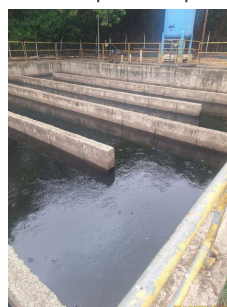
Foto 22 - Chicanas - dosagem de hipoclorito
