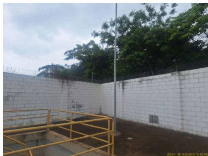
Foto 8 - Cercamento da área e guarda-corpos
