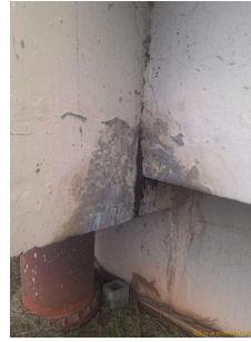
Foto 1 - Ponto de infiltração no Decantador 2 Foto 2 - Ponto de infiltração no Decantador 3
