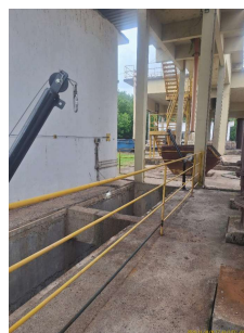
Foto 2 - Acesso ao tratamento preliminar e caçamba de coleta dos resíduos do tratamento preliminar
