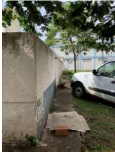
Foto 9 - Vista perímetro do reservatório.
