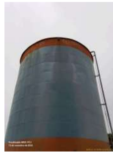
Foto 4 - Abertura do extravasor, localizado próximo à borda superior do reservatório.
