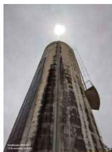
Foto 8 - Tubos de alimentação e do extravasor.
