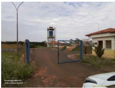
Foto 1 - Vista da entrada da unidade, evidenciando fechamento com portão.
