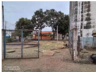
Foto 2 - Vista da entrada da área onde se localiza o reservatório, evidenciando fechamento com portão.
