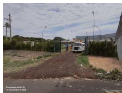
Foto 2 - Vista do acesso à EEE a partir da via pública, evidenciando cercamento da área.
