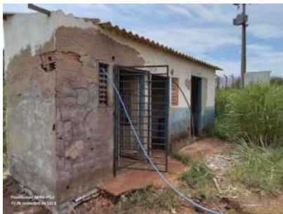
Foto 1 - Vista externa do abrigo para os produtos químicos.
