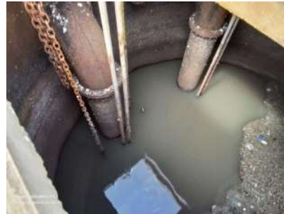
Foto 6 - Poço da elevatória.
