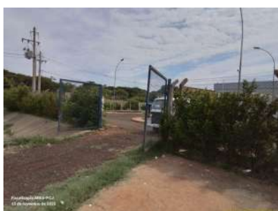
Foto 1 - Vista do acesso à EEE a partir do passeio público, evidenciando portão de acesso.
