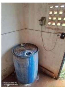
Foto 9 - Bombona e dosadora de reagente utilizado no tratamento da água.
