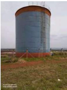
Foto 1 - Vista geral do reservatório.
