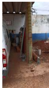
Foto 15 - Bomba reserva mantida no almoxarifado do prestador.
