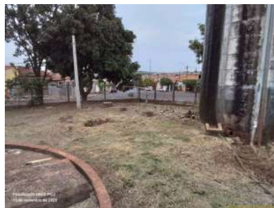
Foto 6 - Vista da área interna da unidade, evidenciando cercamento.
