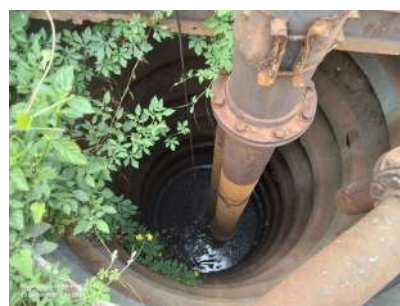
Foto 6 - Poço de sucção da EEE.
