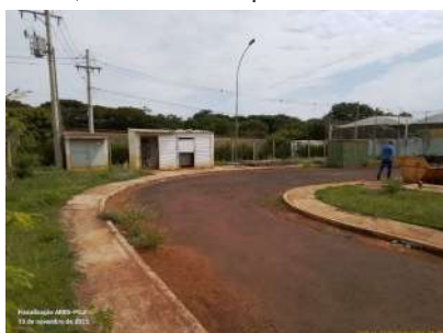
Foto 3 - Vista da área interna da unidade, evidenciando cercamento da área.
