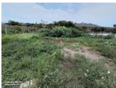
Foto 3 - Mato alto encobre a área onde está o gradeamento na entrada do esgoto na EEE,.
