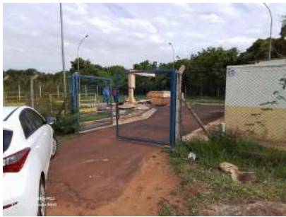
Foto 1 - Vista da entrada da unidade, evidenciando fechamento com portão.
