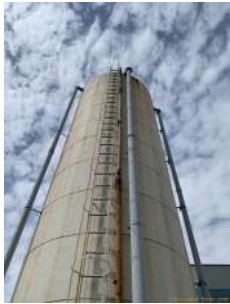
Foto 5 - Vista geral do reservatório.
