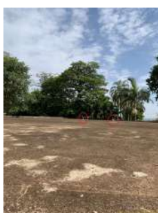
Foto 7 - Tubos de ventilação na parte superior do reservatório não possuem tela de proteção.
