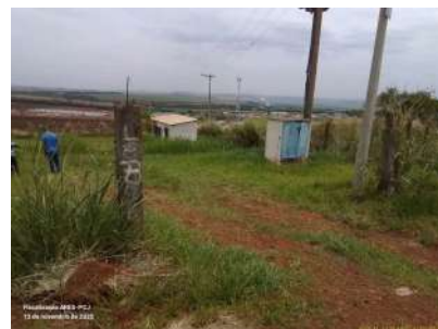
Foto 2 - Ausência de portão na entrada da área.
