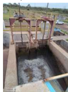
Foto 9 - Comportas instaladas previamente aos desarenadores.
