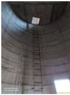
Foto 9 - Escada e guarda corpo no interior da base do reservatório.
