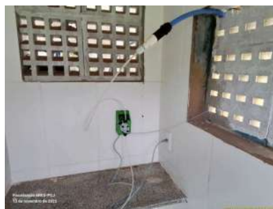
Foto 8 - Bomba dosadora de reagente ácido hexafluorosilícico.
