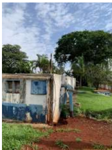
Foto 5 - Vista perímetro do reservatório.
