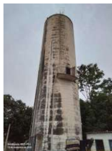
Foto 4 - Vista geral do reservatório, evidenciando escada e guarda corpo.
