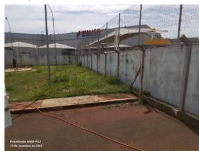
Foto 4 - Vista da área interna da unidade, evidenciando cercamento da área.
