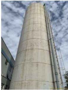
Foto 4 - Escadas e guarda corpos instalados na estrutura.
