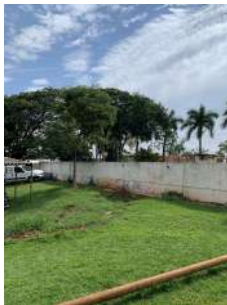
Foto 3 - Vista perímetro do reservatório.
