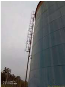
Foto 2 - Vista geral do reservatório evidenciando escada e guarda corpo.
