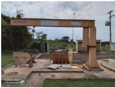
Foto 3 - Estrutura metálica com talha para auxílio nas atividades de manutenção da unidade.
