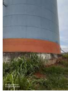
Foto 6 - Vista geral perímetro do reservatório.
