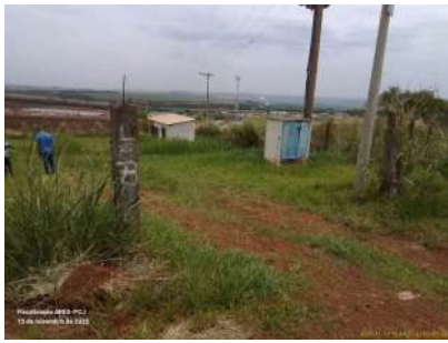
Foto 2 - Ausência de portão na entrada da área.
