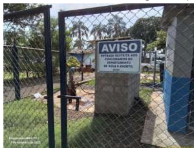
Foto 11 - Aviso de segurança no cercado ao redor da captação.
