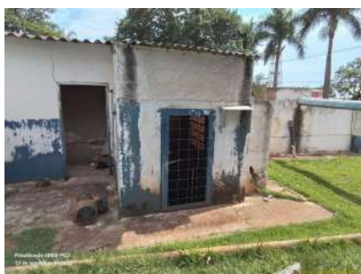
Foto 1 - Vista externa da EEA.
