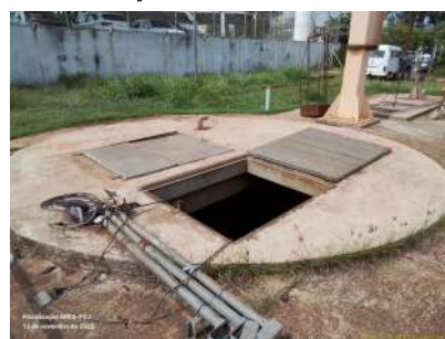
Foto 14 - Vista externa do poço da EEE.
