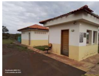
Foto 4 - Edificações na entrada da unidade.
