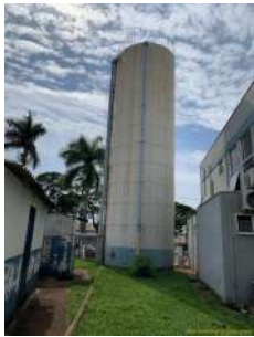
Foto 1 - Vista geral do reservatório. A tubulação à frente alimenta o reservatório com água bombeada do reservatório semi enterrado, localizado ao lado.
