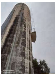
Foto 7 - Vista evidenciando condutor do SPDA.
