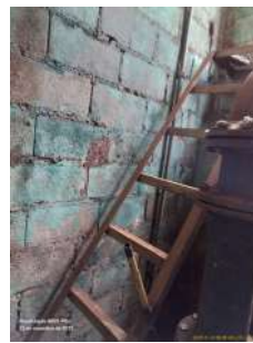
Foto 4 - Escada instalada na EEA.
