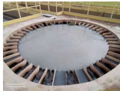
Foto 14 - Distribuidor tipo tulipa na entrada de um dos reatores UASB.
