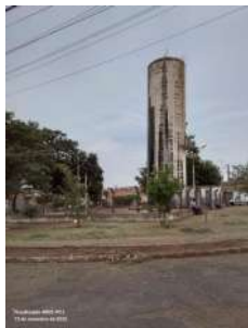
Foto 1 - Vista geral do reservatório a partir da via pública.
