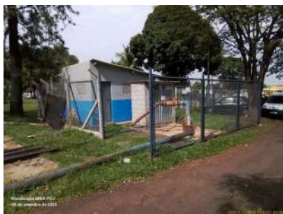
Foto 1 - Vista geral da captação.
