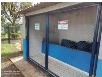
Foto 9 - Abrigo com reservatórios dos reagentes químicos empregados no tratamento.
