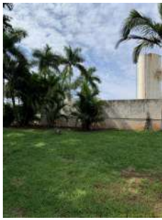
Foto 7 - Vista perímetro do reservatório.
