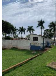
Foto 2 - Vista geral do reservatório, evidenciando a edificação adjacente abriga uma EEA que bombeia água do reservatório subterrâneo para um reservatório elevado ao lado.
