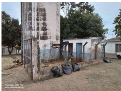
Foto 3 - Vista da área a partir do passeio público, evidenciando cercamento com alambrado.
