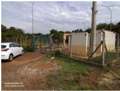
Foto 2 - Vista da parte externa da unidade, evidenciando cercamento da área com alambrado.
