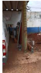
Foto 14 - Bomba reserva mantida no almoxarifado do prestador.
