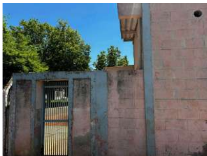
Foto 1 - Entrada da ETA sem identificação.
