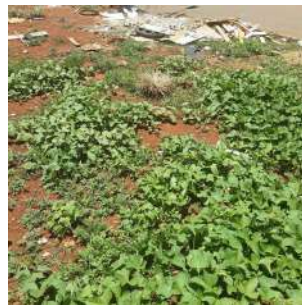
Foto 7 - Acúmulo de sujeira e vegetação excessiva na área do reservatório.
