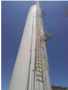
Foto 1 - Vista geral do reservatório 1.
