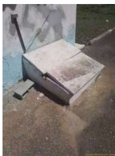
Foto 3 - Tampa de inspeção.
