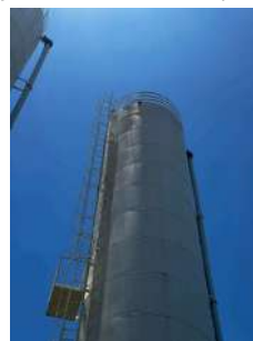
Foto 6 - Topo de um dos reservatórios, com destaque para tubo extravasor, escada de acesso e guarda-corpo.
