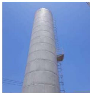
Foto 7 - Vista geral de um dos reservatórios.
