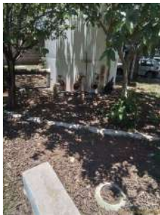
Foto 2 - Vista da base do reservatório situado dentro da ETA.
