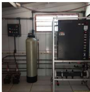
Foto 21 - Produção de hipoclorito de sódio via eletrólise.
