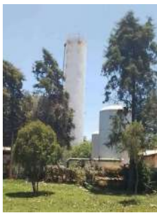
Foto 3 - Vista geral do reservatório situado dentro da ETA.
