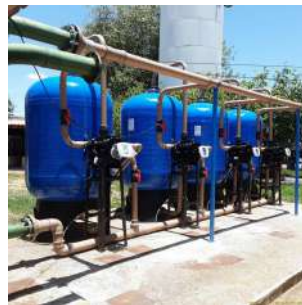
Foto 10 - Filtros (recém adquiridos) constituídos de zeólita. Ideais para remoção de ferro e manganês.
