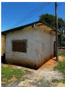
Foto 5 - Vista geral da casa de motobombas.
