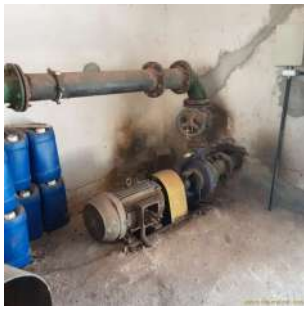
Foto 3 - Moto bomba em operação.
