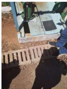
Foto 1 - Tampa de madeira com aberturas e sinais de desgaste, permitindo a entrada de impurezas e comprometendo a segurança.
