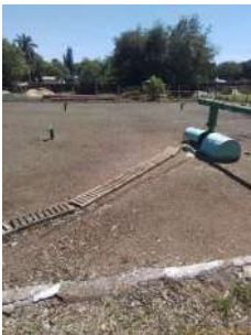
Foto 1 - Vista da parte de cima do reservatório.
