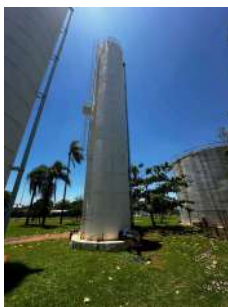
Foto 5 - Vista geral de um dos reservatórios.
