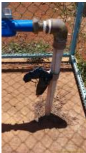
Foto 2 - Torneira para coleta de água para análise.
