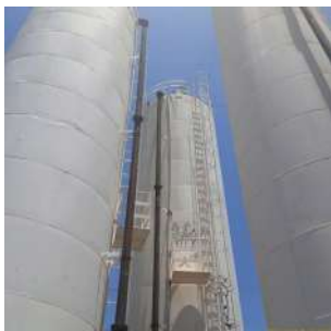
Foto 5 - Vista detalhada dos três reservatórios.
