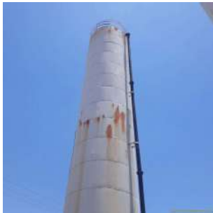
Foto 5 - Vista geral de um dos reservatórios.
