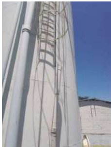
Foto 3 - Escada de acesso ao topo.
