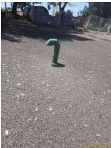
Foto 2 - Tubulação de ventilação.
