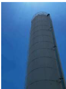
Foto 7 - Topo de outro reservatório, com destaque para tubo extravasor, escada de acesso e guarda-corpo.
