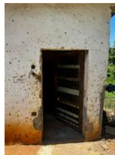
Foto 4 - Porta de entrada para a casa de motobombas.
