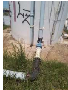
Foto 2 - Entrada de água
