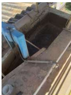
Foto 20 - Entrada da água após a adição de PAC e aluminato de sódio.
