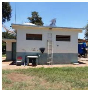
Foto 25 - Vista geral da ETA.
