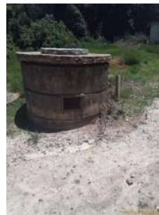
Foto 2 - Ponto mais elevado, onde está posicionada a bomba submersa.
