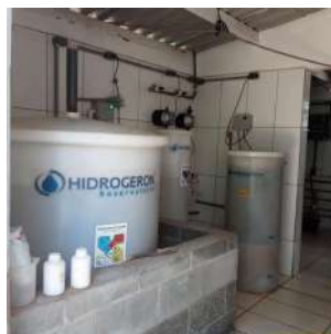
Foto 19 - Produção de flúor a partir do sal fluorsilicato de sódio.
