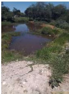
Foto 1 - Ponto de captação.
