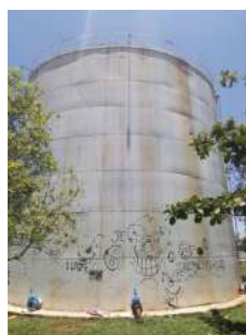
Foto 2 - Tubulações de entrada/saída de água.
