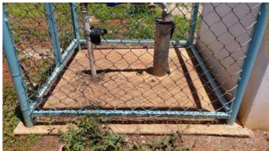
Foto 5 - Laje de proteção do poço.
