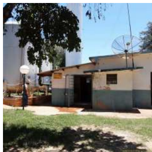
Foto 24 - Vista geral da ETA.
