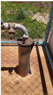
Foto 1 - Tubo para medição de nível.
