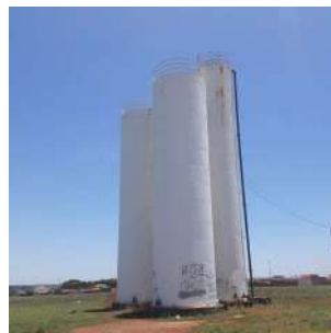
Foto 6 - Vista geral dos três reservatórios.
