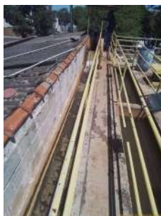
Foto 22 - Passagem da água para as câmaras de floculação.
