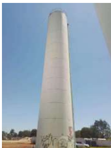
Foto 5 - Vista geral do reservatório 2.
