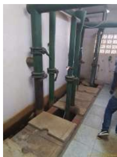
Foto 28 - Sala de passagem da água, momento em que ocorre a dosagem dos produtos (cloro e flúor).
