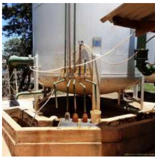
Foto 7 - Torneiras para coleta de amostra e acompanhamento da operação.
