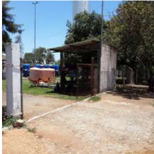
Foto 28 - Portão de entrada da ETA.
