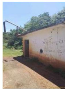
Foto 10 - Vista geral da casa de motobombas.
