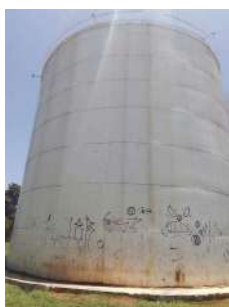
Foto 1 - Vista geral do reservatório.
