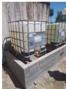
Foto 13 - Tanque de ácido fluossilícico.
