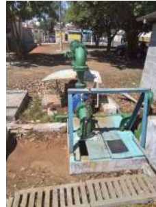
Foto 3 - Tubulação e tampa de proteção. A tampa possui uma pequena abertura coberta por uma peça (quadrado preto na imagem), utilizada para permitir a abertura e o fechamento durante a coleta de água.
