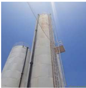
Foto 2 - Topo de dois reservatórios. Todos com escada de acesso e guarda corpo.
