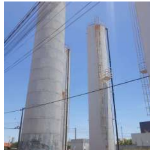
Foto 8 - Vista geral da área dos reservatórios.
