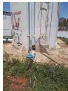
Foto 6 - Base do reservatório 2.
