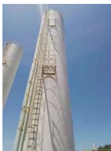
Foto 7 - Escada de acesso e topo do reservatório 2.
