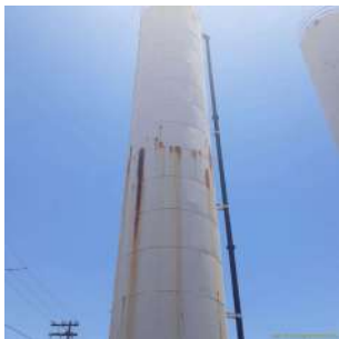
Foto 1 - Vista geral de um dos reservatórios.
