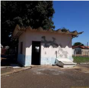
Foto 1 - Vista da porta de entrada da casa de motobombas.
