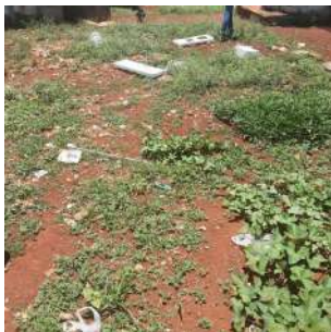
Foto 6 - Acúmulo de sujeira na área do reservatório.
