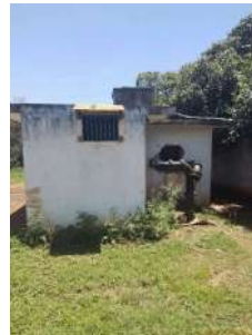
Foto 11 - Vista traseira da casa de motobombas.
