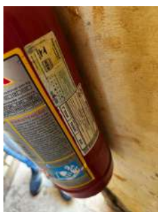
Foto 1 - Extintor de incêndio com prazo de validade expirado desde 2022, conforme etiqueta de identificação.
