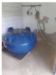
Foto 8 - Tanque de armazenamento de produto químico. A cloração e a fluoretação são realizadas no ponto de entrada do reservatório.
