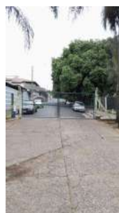
Foto 9 - Portão de acesso ao reservatório.
