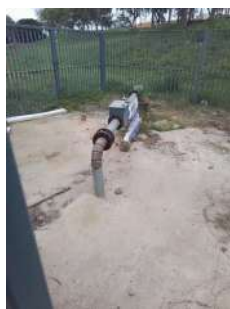
Foto 2 - Vista geral do poço.
