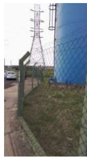
Foto 7 - Cercamento da área do reservatório.
