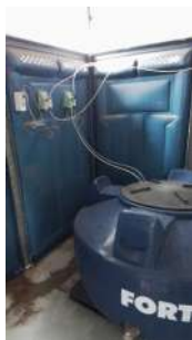
Foto 7 - Tanque de armazenamento de produto químico. A cloração e a fluoretação são realizadas no ponto de entrada do reservatório.
