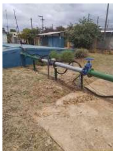
Foto 5 - Tubulação de conexão com o reservatório.
