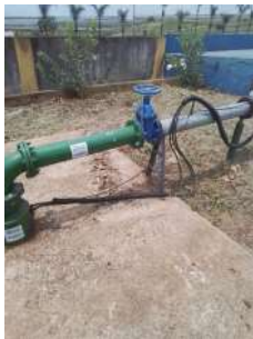
Foto 1 - Vista geral do poço.
