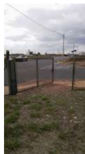
Foto 2 - Portão de acesso.
