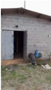
Foto 1 - Porta de acesso para a estação elevatória.
