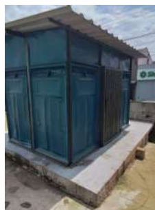
Foto 13 - Casa de armazenamento dos produtos químicos.
