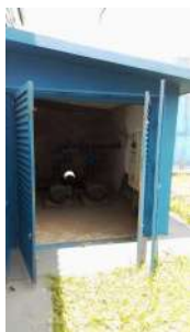
Foto 5 - Porta de entrada da estação elevatória.
