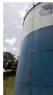
Foto 6 - Medidor de nível.
