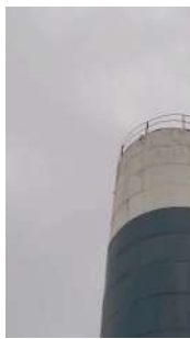
Foto 6 - Topo do reservatório.
