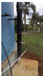
Foto 10 - Ponto de cloração e fluoretação.
