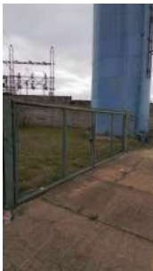
Foto 2 - Portão de acesso ao reservatório.
