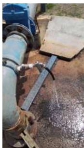
Foto 3 - Torneira para coleta de amostra.
