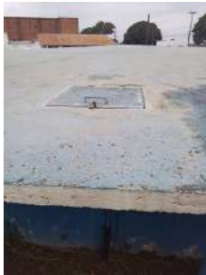
Foto 2 - Tampa de inspeção.
