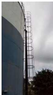
Foto 5 - Escada de acesso para o topo do reservatório.
