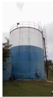
Foto 4 - Para-raios e guarda corpo no topo do reservatório.
