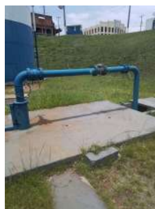
Foto 2 - Vista geral do poço.
