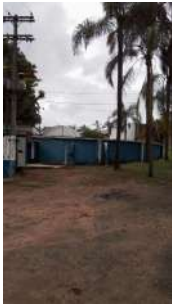
Foto 1 - Vista geral do reservatório.
