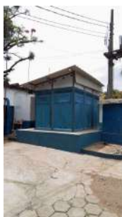
Foto 5 - Casa de armazenamento dos produtos químicos.
