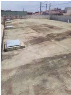
Foto 2 - Vista da parte superior do reservatório.
