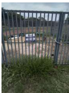
Foto 1 - Cercamento da área do poço e placa de identificação.
