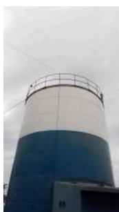
Foto 8 - Topo do reservatório.
