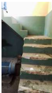
Foto 1 - Escada de acesso à sala de motobombas.
