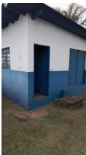
Foto 1 - Vista geral da estação elevatória.
