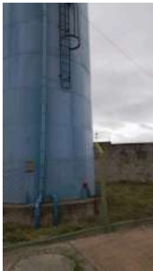
Foto 4 - Base do reservatório.
