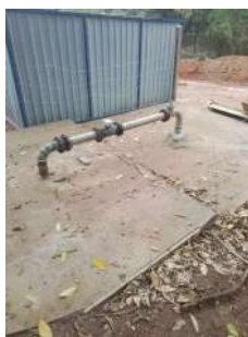
Foto 1 - Vista geral do poço.
