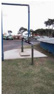
Foto 1 - Vista geral do poço.
