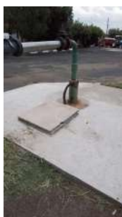
Foto 5 - Laje de proteção do poço.
