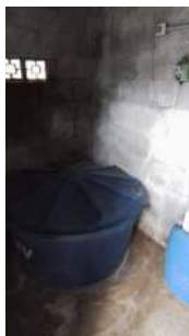
Foto 1 - Tanque contendo produto químico, sem dique ou estrutura de contenção.
