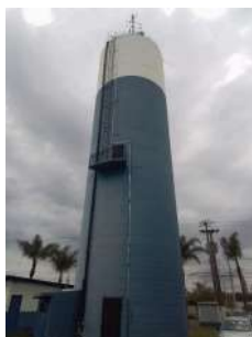
Foto 1 - Vista geral do reservatório.
