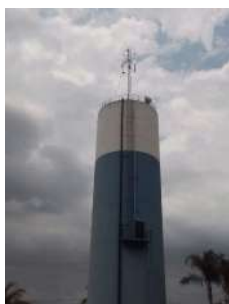
Foto 3 - Vista do topo do reservatório.
