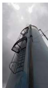
Foto 6 - Escada de acesso ao topo.
