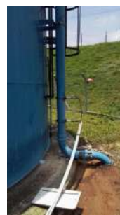
Foto 7 - Pontos de cloração e fluoretação na tubulação de entrada da água.
