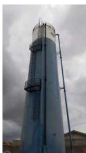
Foto 3 - Vista geral do reservatório.
