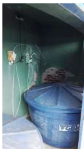
Foto 11 - Tanque de armazenamento de produto químico.
