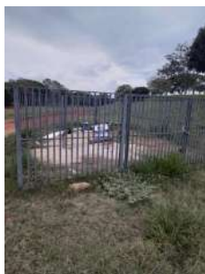
Foto 4 - Vista geral do poço.
