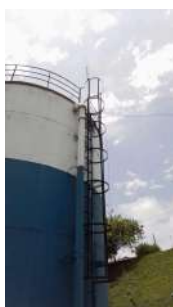
Foto 8 - Escada de acesso ao topo do reservatório e ao sistema de para-raios.
