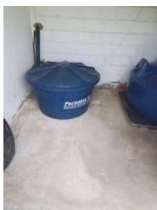
Foto 7 - Tanque de armazenamento de produto químico. A cloração e a fluoretação são realizadas no ponto de entrada do reservatório.
