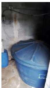
Foto 5 - Tanque de armazenamento de produto químico.
