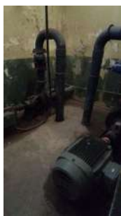
Foto 3 - Conjunto de motobombas da estação elevatória. Sendo uma em funcionamento e outra em reserva.
