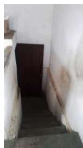
Foto 7 - Escada de acesso para a estação elevatória.
