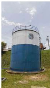
Foto 3 - Vista geral do reservatório.
