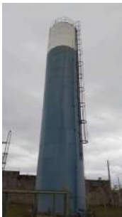
Foto 1 - Vista geral do reservatório.
