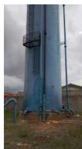
Foto 4 - Medidor de nível.
