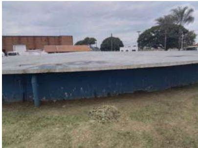
Foto 1 - Vista geral do reservatório.
