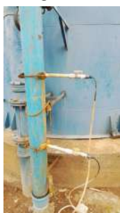
Foto 5 - Ponto de cloração e fluoretação na entrada de água.
