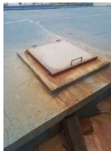
Foto 2 - Tampa de inspeção.
