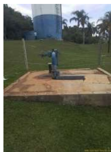
Foto 4 - Vista traseira do poço.
