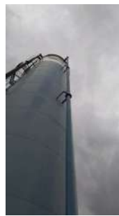
Foto 9 - Topo do reservatório.
