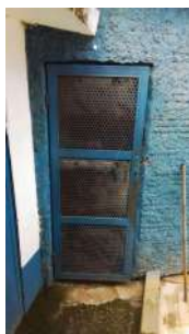
Foto 9 - Porta de acesso ao reservatório.
