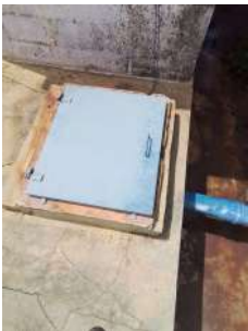
Foto 1 - Tampa de inspeção.
