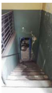
Foto 10 - Escada de acesso para a elevatória.
