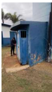
Foto 7 - Casa dos tanques de hipoclorito de sódio e ácido fluossilicato.
