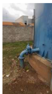
Foto 7 - Tubulação de saída de água.
