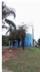
Foto 2 - Vista geral do reservatório.
