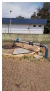
Foto 4 - Vista geral do poço.
