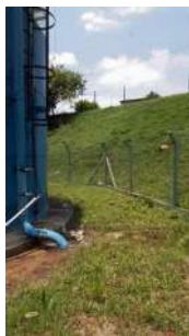
Foto 10 - Cercamento da área do reservatório.
