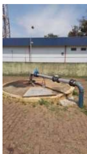
Foto 5 - Laje de proteção.
