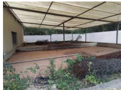
Foto 2 - Tanque de lodo sem utilização
