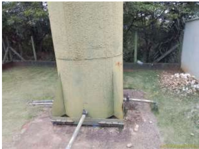
Foto 4 - Destaque para a base do reservatório
