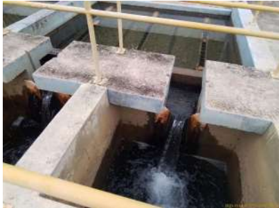
Foto 11 - Vista dos filtros
