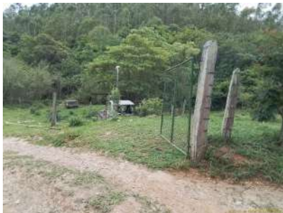
Foto 1 - Entrada para a área da captação sem identificação
