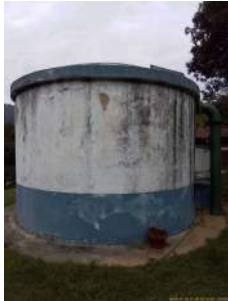
Foto 5 - Vista geral do reservatório
