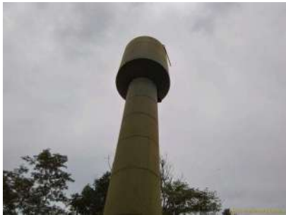
Foto 3 - Vista geral do reservatório
