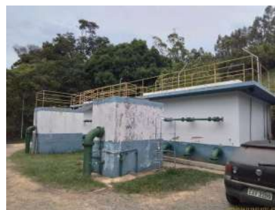
Foto 8 - Visão geral da Estação de Tratamento de Água
