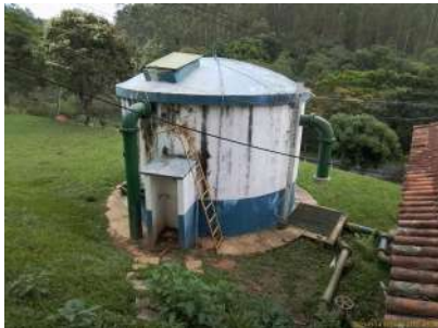
Foto 1 - Utilização de uma escada solta e sem guarda-corpo
