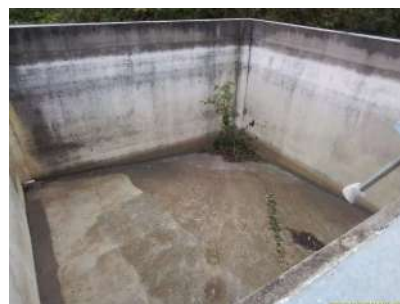
Foto 7 - tanque sem utilização
