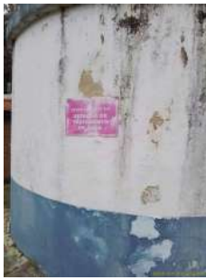
Foto 3 - Placa de identificação do reservatório
