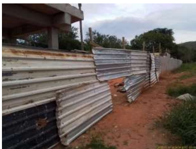
Foto 1 - A área está em obras e atualmente cercada parte por muro recém construído e parte por chapas de metal
