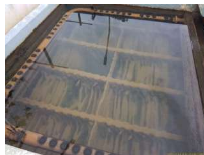
Foto 4 - Membrana em mas condições
