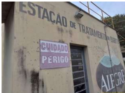
Foto 1 - Identificação da Estação de Tratamento
