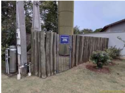
Foto 1 - Placa de identificação do reservatório
