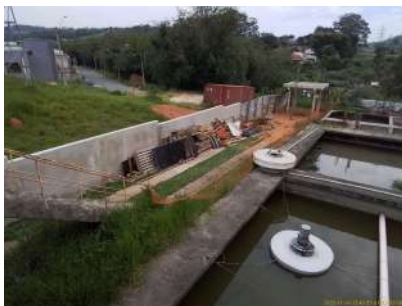
Foto 1 - Material de obra nas dependências da ETE (a obra não aparenta estar em andamento)
