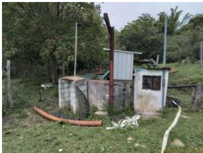
Foto 2 - Vista geral do sistema de captação
