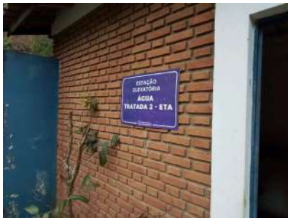
Foto 1 - Placa de identificação da Elevatória de Água
