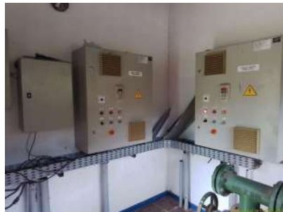
Foto 3 - Painéis elétricos
