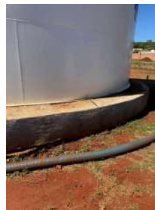
Foto 4 - Condutor de aterramento da estrutura.
