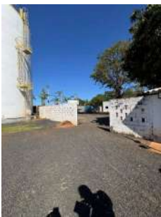
Foto 2 - Vista geral da área da unidade, evidenciando cercamento.
