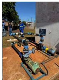
Foto 5 - Vista geral da elevatória.
