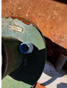
Foto 1 - Tubo de medição de nível com extremidade superior aberta.
