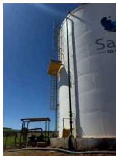
Foto 3 - Escadas e guarda corpos instalados.
