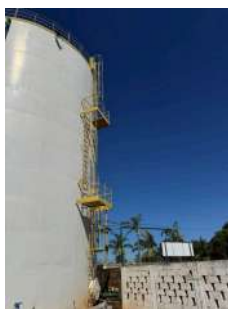
Foto 3 - Escadas e guarda corpos instalados.
