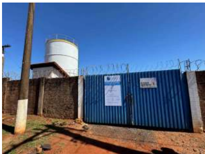
Foto 1 - Vista geral da parte externa, indicando cercamento da área.
