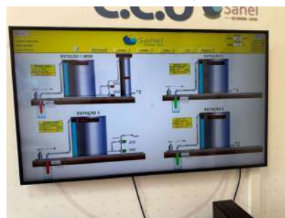
Foto 10 - Painel do CCO do Prestador, exibindo nível dos reservatórios em tempo real.
