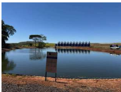
Foto 1 - Vista geral da lagoa aeróbica de estabilização. Ao fundo, reatores tipo UASB, modulares. Placa de identificação à frente.
