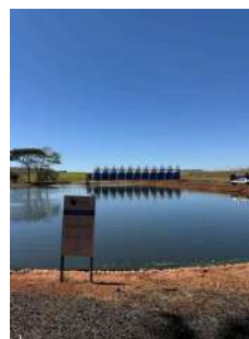
Foto 2 - Vista geral da lagoa aeróbica de estabilização. Ao fundo, reatores tipo UASB, modulares.
