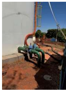
Foto 4 - Condutor de aterramento da estrutura, à esquerda das tubulações de saída do reservatório.
