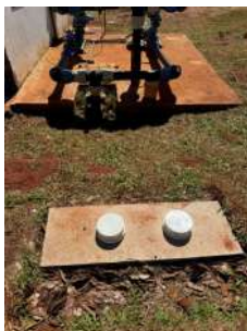
Foto 4 - Acesso a registros de manobra na saída da elevatória.
