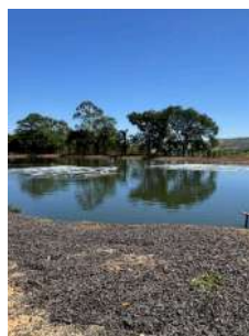
Foto 15 - Vista geral da lagoa de estabilização, aeróbica, no momento da fiscalização dois aeradores em operação.
