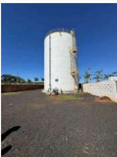
Foto 1 - Vista geral do reservatório, evidenciando escada e guarda corpos instalados.
