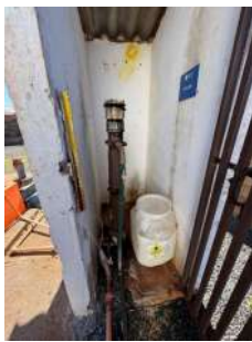
Foto 4 - Dosadora de reagente químico empregado no tratamento da água;
