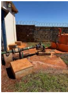
Foto 7 - Vista da captação localizada na mesma área do reservatório.
