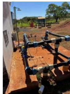
Foto 3 - Vista geral da elevatória.
