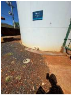
Foto 6 - Placa com identificação da unidade, afixada no corpo do reservatório.
