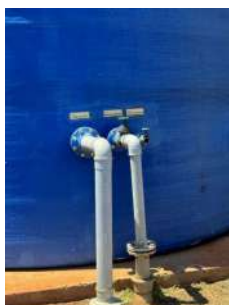
Foto 14 - Tubulações de entrada de esgoto no UASB e coleta de amostras do lodo, para análise.
