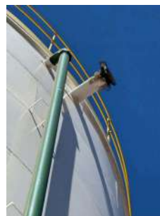
Foto 8 - Tubo extravasor no topo do reservatório.
