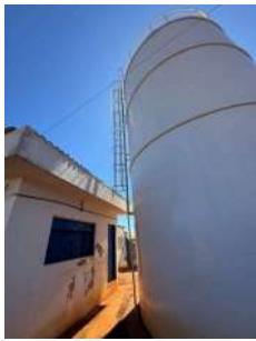
Foto 5 - Escada e guarda corpos instalados no reservatório.
