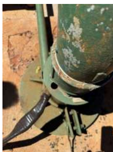
Foto 8 - Orifício para tubo de medição de nível do poço.
