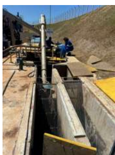
Foto 6 - Gradeamento primário.
