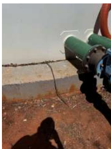
Foto 6 - Condutor de aterramento da estrutura, à esquerda das tubulações de saída do reservatório.
