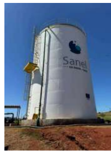
Foto 2 - Vista geral do reservatório, evidenciando escada e guarda corpos à esquerda, tubo de alimentação à frente e saída de extravasor no topo, ao lado da tubulação de alimentação.
