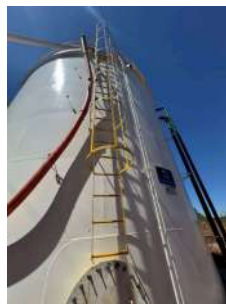
Foto 10 - Escada e guarda corpos instalados no reservatório.
