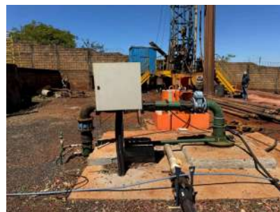
Foto 4 - Vista geral da captação. Ao fundo um novo poço está sendo perfurado, o qual substituirá o atual poço presente na unidade.
