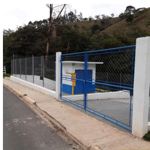
Foto 11 - Vista geral do portão acesso à elevatória e cercamento da área.
