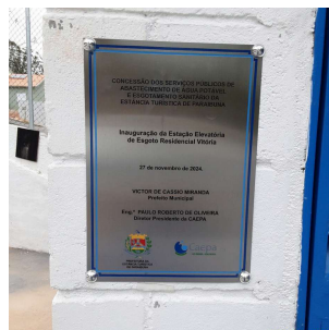
Foto 10 - Placa de inauguração da elevatória.
