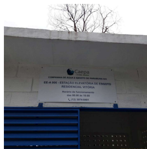
Foto 9 - Placa de identificação da elevatória.
