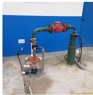
Foto 2 - Vista geral da estrutura do poço.
