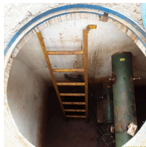
Foto 8 - Escada de acesso ao interior da elevatória.
