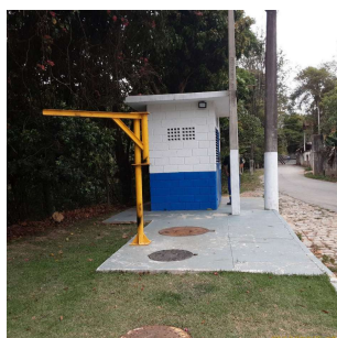
Foto 1 - Vista geral da elevatória.
