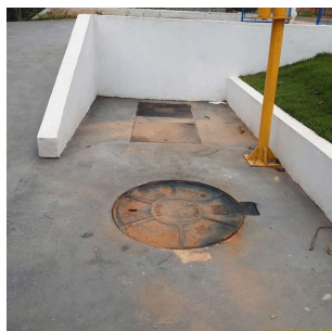
Foto 3 - Detalhe da tampa do poço de bombeamento.
