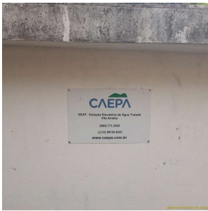
Foto 2 - Placa de identificação afixada na fachada da edificação.
