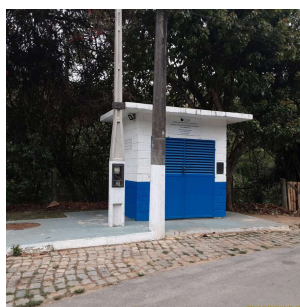
Foto 2 - Vista geral da edificação que abriga o gerador e os painéis elétricos.
