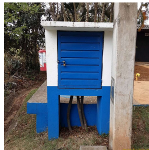
Foto 5 - Vista geral da pequena edificação que abriga o painel elétrico.
