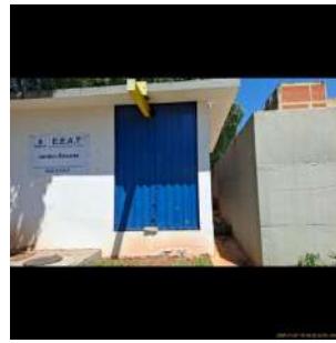
Foto 10 - Interligação dos reservatórios com a EEAT Jardim Rosana.
