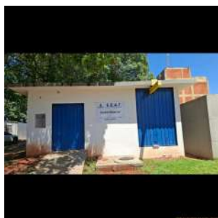
Foto 1 - Fachada da EEAT.
