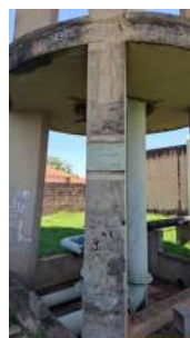
Foto 4 - Base do reservatório.
