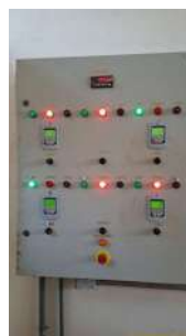
Foto 31 - Painel de controle de dosagem do hidróxido de cálcio.
