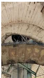
Foto 1 - Acesso à água tratada sem fechamento.
