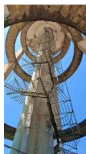
Foto 2 - Escada e seu guarda-corpo.
