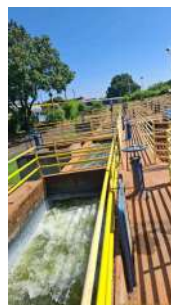
Foto 6 - Calha de água bruta.
