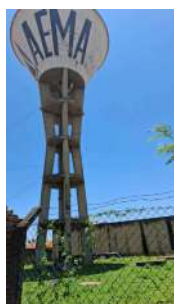
Foto 9 - Vista da área onde encontram-se os reservatórios.
