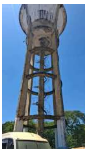
Foto 1 - Vista da escada.
