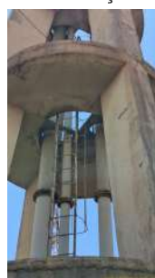
Foto 10 - Escada do reservatório.
