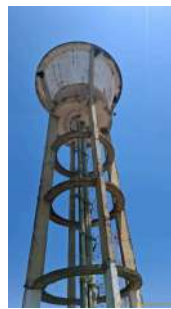
Foto 4 - Vista da lateral do reservatório.
