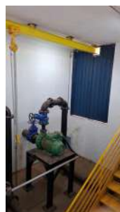
Foto 9 - Portão de acesso e trilho com talha.
