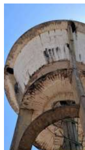
Foto 2 - Vazamentos.
