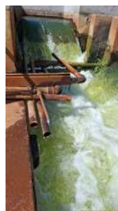
Foto 7 - Dosagem de produtos químicos na água bruta.
