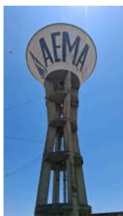
Foto 3 - Vista frontal do reservatório.
