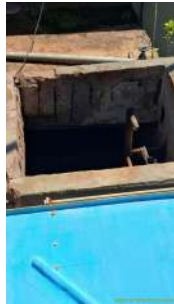
Foto 11 - Caixa de inspeção do extravasor aberta.
