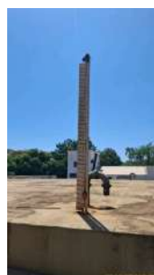
Foto 2 - Régua de medição de nível.
