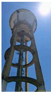
Foto 3 - Vista da base e da escada.
