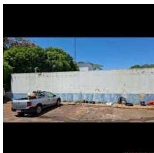
Foto 7 - Lateral do reservatório R03
