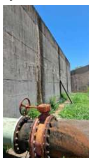
Foto 7 - Parte traseira do reservatório.
