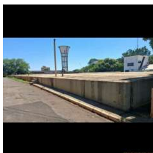
Foto 1 - Vista do reservatório R01.
