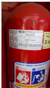
Foto 3 - Validade do Extintor.
