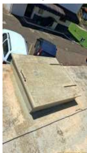
Foto 5 - Tampa de inspeção.
