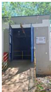
Foto 4 - Fachada da EEAT.
