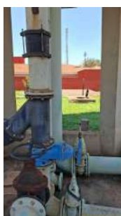
Foto 9 - Registros nas tubulações do reservatório.
