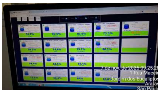
Foto 12 - CCO com o nível do reservatório.
