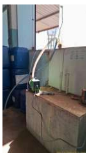
Foto 38 - Bomba dosadora de ácido fluorsilícico e de ortopolifosfato de sódio.
