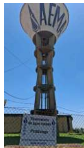
Foto 2 - Placa do reservatório apoiado Piratininga Cuba.
