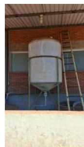
Foto 49 - Tanque de ácido Fluorsilícico.
