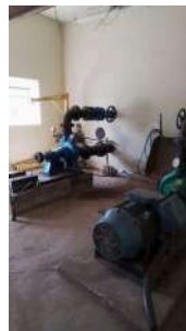
Foto 4 - Visão da elevatória
