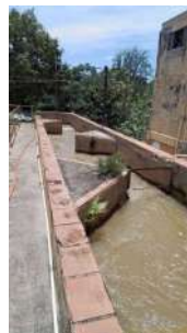
Foto 18 - Chegada água bruta nos decantadores antigos
