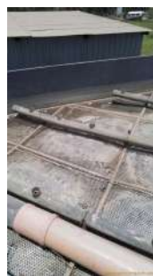
Foto 32 - Local em manutenção
