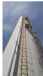
Foto 6 - Escada para acessar a cobertura
