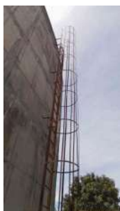
Foto 1 - Escada com proteção
