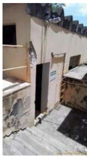
Foto 1 - Entrada da elevatória
