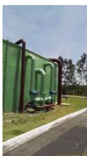
Foto 17 - Entrada do efluente no reator
