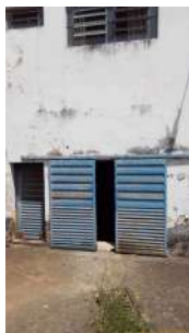
Foto 5 - Acesso à elevatória
