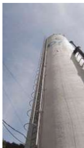
Foto 1 - Escada com proteção.
