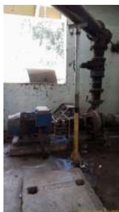
Foto 5 - Bomba do recalque para Santo Rizzo
