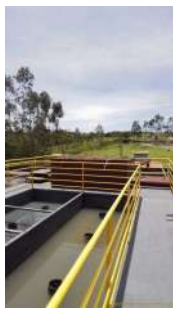
Foto 21 - Caixa de entrada do efluente no reator
