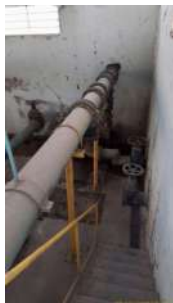
Foto 3 - Acesso à casa de bombas.
