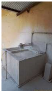
Foto 13 - Preparo de Cal Hidratada
