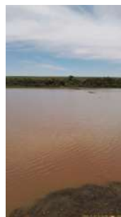
Foto 2 - Represa Pirapitingui, que abastece a ETA. Visualiza-se também tubulação que transportar água do Rio Jaguari e complementa o abastecimento da ETA.
