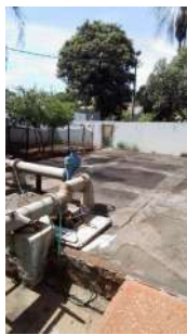
Foto 5 - Visão do reservatório
