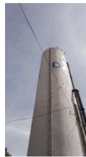
Foto 2 - Escada para acessar a cobertura
