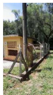
Foto 2 - Cercamento no perímetro.
