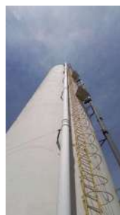
Foto 2 - Descida do extravasor
