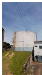
Foto 4 - Visão geral do reservatório
