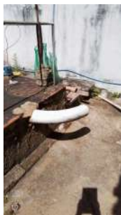
Foto 1 - Extravasor do reservatório
