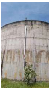
Foto 1 - Medidor de nível por contrapeso
