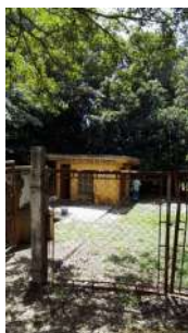
Foto 1 - Elevatória Bela Vista 4
