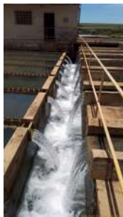
Foto 5 - Água após decantação
