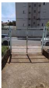
Foto 1 - Portão de acesso.
