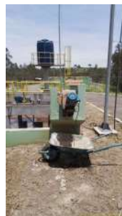
Foto 11 - Remoção de sólidos
