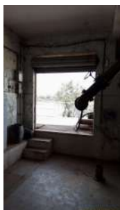
Foto 1 - Acesso à casa de bombas.
