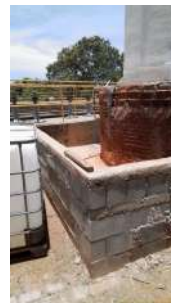
Foto 4 - dique de contenção
