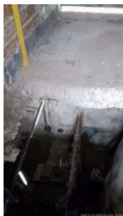
Foto 5 - Abertura realizada na laje para içamento de bombas.
