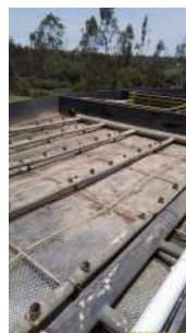
Foto 33 - Local em manutenção
