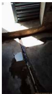
Foto 2 - Canaleta para escoar a água drenada.
