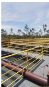
Foto 1 - Guarda-corpos em bom estado de conservação.
