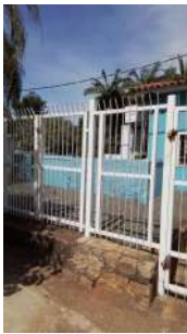
Foto 1 - Cercamento do local
