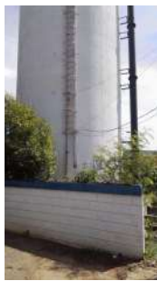
Foto 1 - Visão geral do reservatório.
