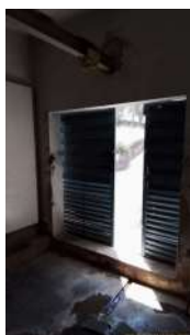
Foto 1 - Acesso à elevatória
