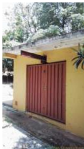
Foto 1 - Portão para acessar a elevatória
