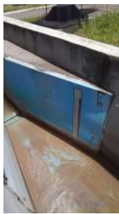
Foto 1 - Calha parshall após o tratamento preliminar
