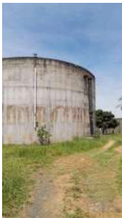
Foto 2 - Visão geral do reservatório
