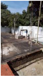
Foto 3 - Reservatório semi enterrado
