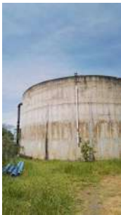
Foto 1 - Visão geral do reservatório
