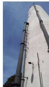
Foto 8 - Tubulação de saída do reservatório, atualmente desativado.
