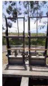
Foto 10 - Grades mecanizadas
