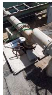
Foto 2 - É necessário vedar esta abertura com tela ou outro dispositivo
