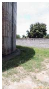
Foto 2 - Muro em parte do perímetro
