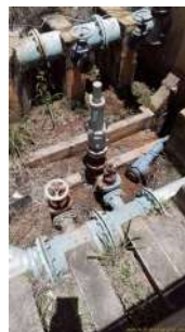
Foto 2 - Vazamentos
