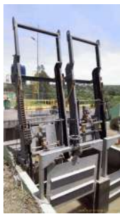
Foto 3 - Gradeamento mecanizado
