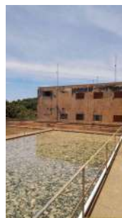
Foto 8 - Visão geral da ETA.
