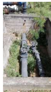
Foto 6 - Tubulação de entrada de reservatório.
