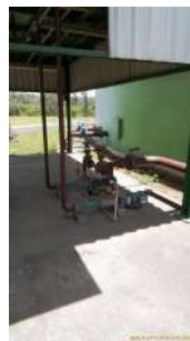
Foto 2 - Bombeamento de lodo
