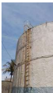
Foto 1 - Escada com proteção
