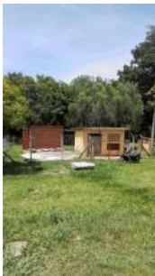
Foto 1 - Visão geral da elevatória de esgoto Bela Vista 3
