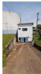
Foto 6 - Acesso à elevatória
