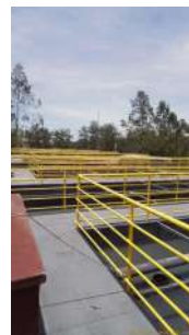
Foto 2 - Guarda-corpos em bom estado de conservação.
