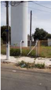
Foto 2 - Cercamento e portão
