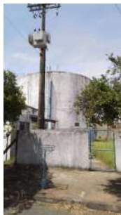
Foto 1 - Visão geral do reservatório Santo Rizzo I
