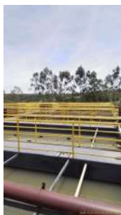
Foto 19 - Reator UASB
