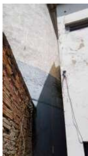
Foto 1 - Medidor de nível por contrapeso
