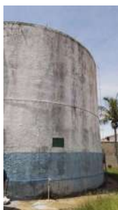
Foto 3 - Reservatório Santo Rizzo I
