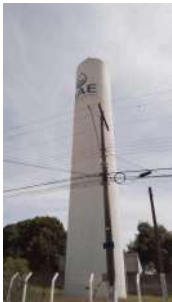
Foto 1 - Visão geral do reservatório
