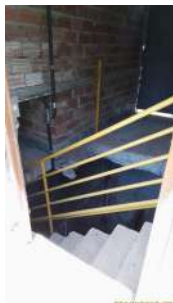
Foto 3 - Escada para acessar a casa de bombas.
