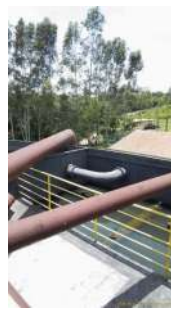
Foto 22 - Entrada do efluente no tanque
