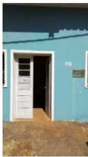
Foto 1 - Entrada da casa de bombas
