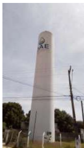
Foto 11 - Visão geral do reservatório
