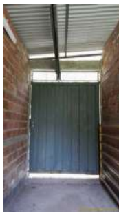
Foto 1 - Portão para acessar a ponte rolante.
