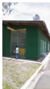
Foto 35 - Edificação que abriga os sopradores e o tratamento UV
