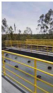
Foto 3 - Guarda-corpos em bom estado de conservação.
