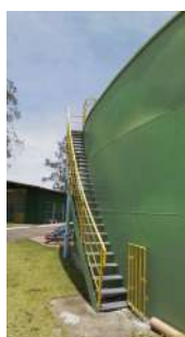
Foto 18 - Escada para acessar o reator
