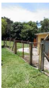
Foto 1 - Cercamento no perímetro.
