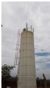
Foto 1 - Visão geral do reservatório.
