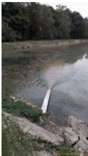
Foto 2 - Entrada de efluente na lagoa.
