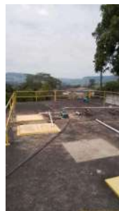
Foto 2 - Guarda-corpo no perímetro da cobertura.
