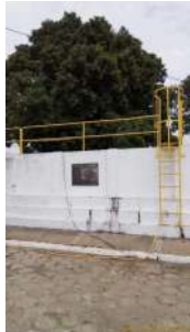
Foto 1 - Visão geral do reservatório.
