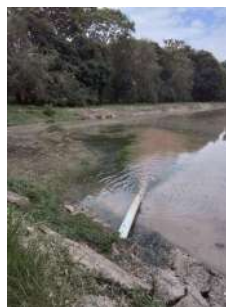
Foto 9 - Entrada de efluente na lagoa.
