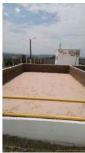
Foto 11 - Filtro lento em manutenção.
