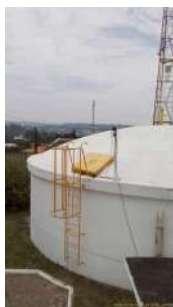
Foto 1 - Tampa de inspeção em boas condições.
