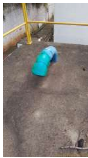
Foto 1 - Tela de proteção em tubulação de ventilação.
