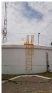
Foto 1 - Escada e guarda-corpo.
