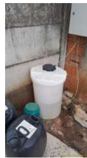
Foto 2 - Armazenamento de cloro.
