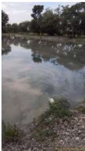
Foto 3 - entrada de efluente na lagoa.
