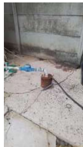
Foto 2 - Poço e laje de concreto.
