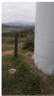
Foto 1 - Cerca ao redor do reservatório.
