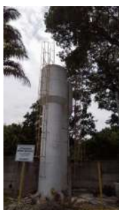
Foto 3 - Visão geral do reservatório.
