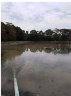
Foto 4 - Entrada de efluente na lagoa.
