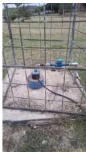
Foto 1 - Laje de concreto.
