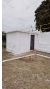
Foto 2 - Visão geral do reservatório.
