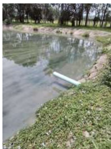
Foto 8 - Tubulação de entrada do efluente obstruída.
