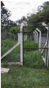
Foto 1 - Cerca e portão de acesso.
