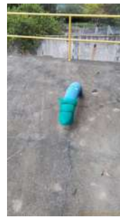
Foto 2 - Tela de proteção em tubulação de ventilação.
