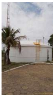
Foto 1 - Visão geral do reservatório.
