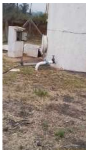
Foto 1 - Manômetro para medição do nível do reservatório.
