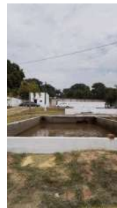
Foto 14 - Visão geral da ETA
