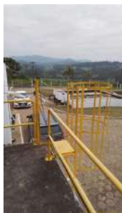
Foto 1 - Guarda-corpo na cobertura.
