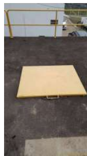
Foto 2 - Tampas de inspeção em boas condições.
