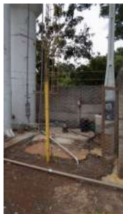
Foto 1 - Visão geral do poço.
