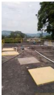
Foto 3 - Laje de cobertura do reservatório.
