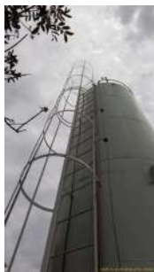
Foto 1 - Escada com proteção e guarda-corpo.
