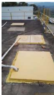
Foto 1 - Tampas de inspeção em boas condições.
