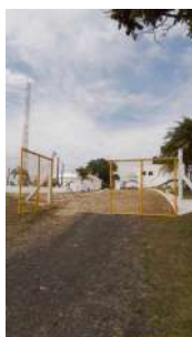
Foto 1 - Portão de acesso.
