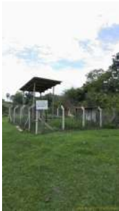
Foto 1 - Visão geral da elevatória de esgoto.
