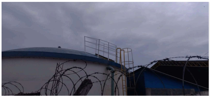
Foto 18 - RES-6.4 - RESERV. ARAÇOIABINHA: Foi instalado guarda corpos no entorno da tampa de inspeção do reservatório.
