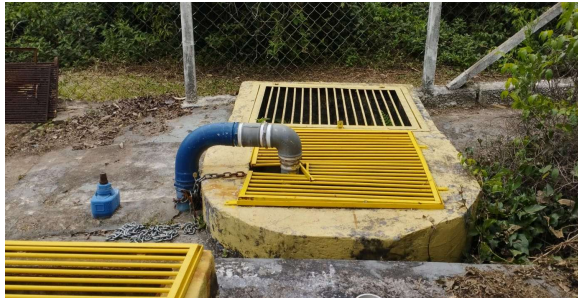
Foto 5 - EEE-7.12 - E.E.E. JARDIM NOVO HORIZONTE: Foi instalada grade de proteção no poço de sucção das bombas.
