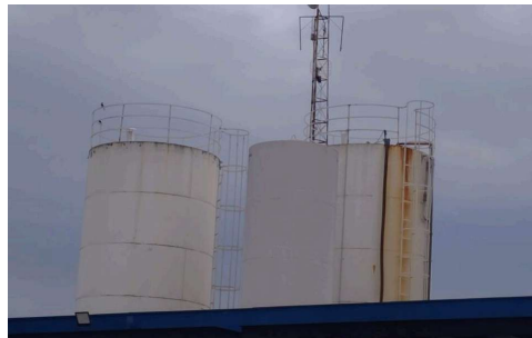
Foto 20 - RES-6.4 - RESERV. RETIRO: Foi instalado guarda corpos na escada de acesso ao topo do reservatório e o guarda corpos no topo do Reservatório I foi consertado.
