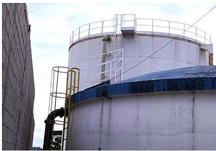
Foto 17 - RES-6.4 - RESERV. TONELLI SEMI ENTERRADO: Foi instalado guarda corpos no entorno da tampa de inspeção do reservatório.
