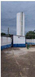
Foto 19 - RES-6.4 - RESERV. RETIRO: Foi instalado guarda corpos na escada de acesso ao topo do reservatório.
