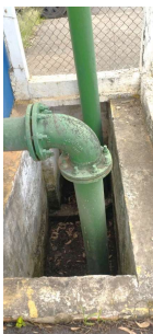
Foto 1 - EEA-4.10 - BOOSTER FLORA: Foi realizada a limpeza e drenagem da água na caixa de passagem das tubulações.
