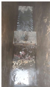
Foto 7 - EEE-7.5 - E.E.E. JARDIM NOVO HORIZONTE: Foi instalado gradeamento grosseiro na canaleta de chegada do esgoto bruto na elevatória.
