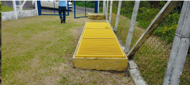
Foto 6 - EEE-7.12 - E.E.E. JARDIM NOVO HORIZONTE: Foi instalada grade de proteção na canaleta de chegada de esgoto bruto na elevatória.
