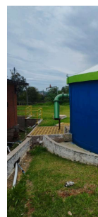
Foto 16 - RES-6.12 - RESERV. ETA JUNDIAQUARA: A posição do tubo extravasor foi corrigida.
