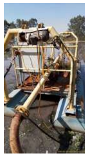
Foto 10 - Dragagem de lodo deteriorada e inoperante.
