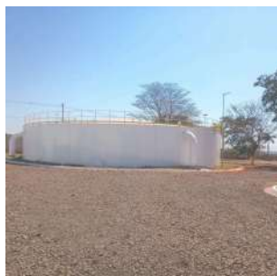
Foto 3 - Vista geral do reservatório.
