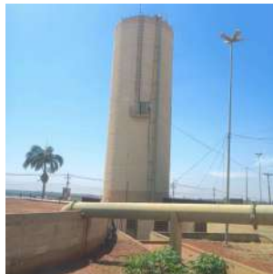
Foto 5 - Vista geral do reservatório.
