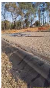
Foto 13 - Geobags para acúmulo e adensamento de lodo inutilizados.
