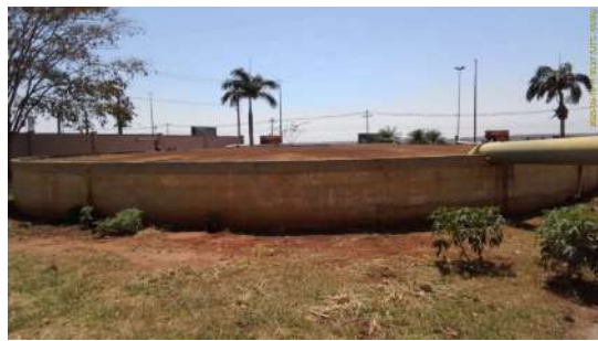
Foto 4 - Vista geral do reservatório.
