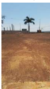
Foto 3 - Vista geral da laje do reservatório, sem tubos de ventilação visíveis.
