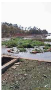
Foto 5 - Situação do assoreamento da primeira lagoa de tratamento.
