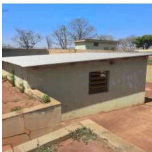
Foto 9 - Vista geral da casa de bombas da elevatória.
