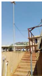
Foto 2 - Origem do cabo de energia fixado no guarda-corpo à frente da escada.
