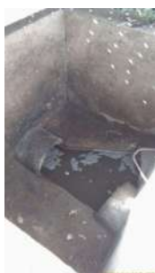
Foto 9 - Emissário de saída do efluente após tratamento.
