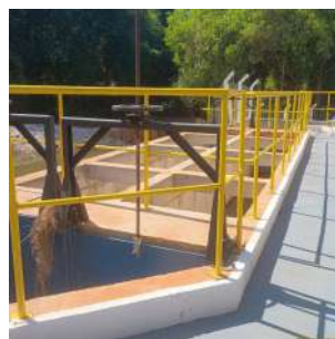
Foto 4 - Canais de desarenação antes do tanque de sucção.
