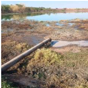
Foto 12 - Uma das tubulação de distribuição do esgoto na chegada à lagoa.
