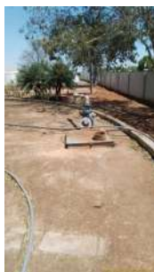
Foto 3 - Tampa com sinais de oxidação.
