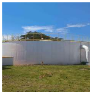
Foto 6 - Vista lateral do reservatório.
