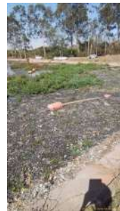
Foto 8 - Excesso de material flutuante na primeira lagoa, demonstrando a ausência de operação adequada e retenção de materiais no tratamento preliminar.
