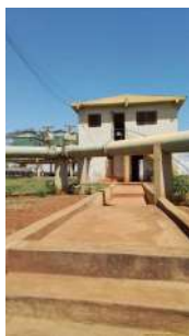
Foto 5 - Prédio operacional que abriga sistema de desinfecção que não é mais utilizado.
