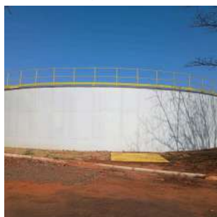
Foto 5 - Vista lateral do reservatório.
