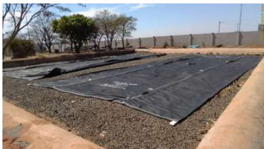
Foto 35 - Geobags para armazenamento de lodo da ETA.
