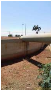
Foto 2 - Vista geral do reservatório e da tubulação de abastecimento.
