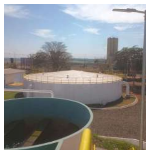
Foto 2 - Vista geral do reservatório.
