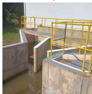
Foto 6 - Canais de direcionamento da água bruta.
