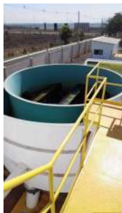
Foto 10 - um dos tanques de filtração.
