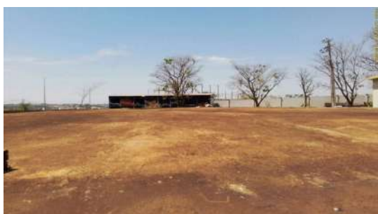
Foto 1 - Vista geral da laje do reservatório, sem tubulação de ventilação.
