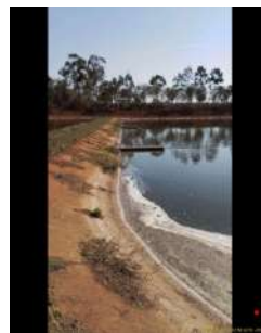
Foto 16 - Entrada de efluentes na lagoa de maturação desniveladas.
