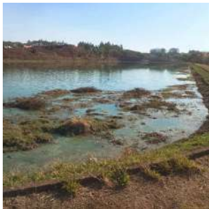
Foto 14 - Vista de jusante para montante da lagoa.
