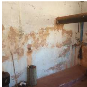
Foto 3 - Situação inadequada do cabeamento de energia da casa de bombas.
