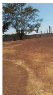
Foto 4 - Vista geral da laje do reservatório, sem tubos de ventilação visíveis.
