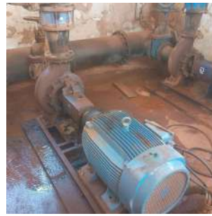
Foto 4 - Situação geral do piso do local.
