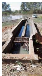
Foto 2 - Tratamento preliminar (grade desarenador).
