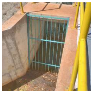
Foto 3 - Gradeamento do canal de derivação para a captação.
