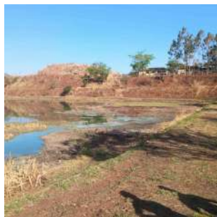
Foto 1 - Vista geral da lagoa de tratamento.
