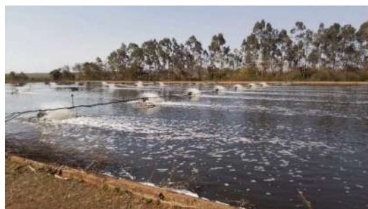
Foto 8 - Vista de uma das lagoas com os aeradores em operação.
