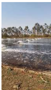
Foto 3 - Aeradores em funcionamento.
