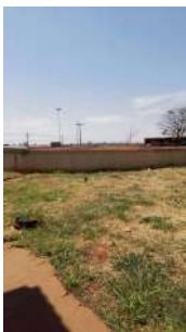
Foto 1 - Vista geral do reservatório.
