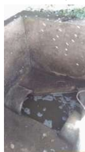
Foto 10 - Emissário de saída do efluente após tratamento.
