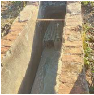
Foto 1 - Situação do canal de chegada de esgoto bruto.
