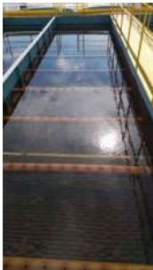
Foto 1 - Vista geral do decantador da ETA.
