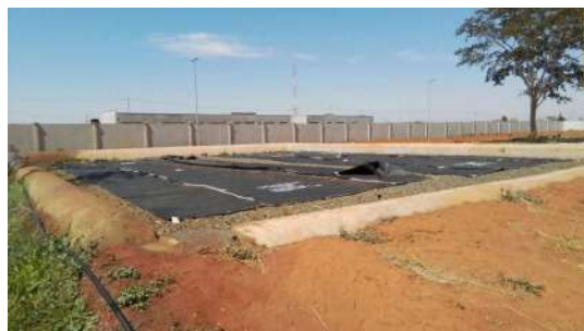
Foto 36 - Geobags para armazenamento de lodo da ETA.
