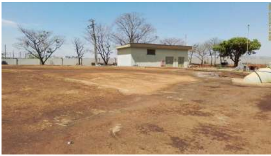
Foto 3 - Vista geral da laje do reservatório, sem tubulação de ventilação.
