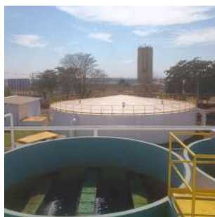
Foto 1 - Vista geral do reservatório.
