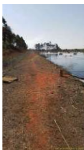
Foto 4 - Vista geral do entorno das lagoas de tratamento.
