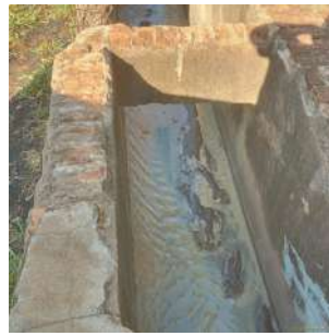
Foto 2 - Situação do canal de chegada de esgoto bruto.
