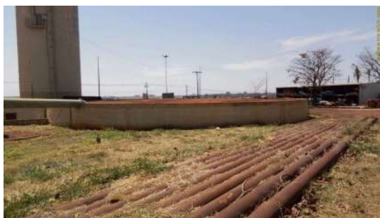
Foto 13 - Vista geral do reservatório.
