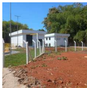
Foto 2 - Casa de bombas e cabine primária da captação superficial.
