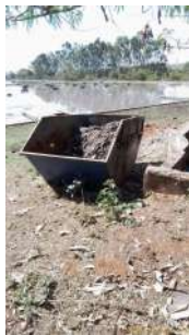
Foto 3 - Material retido no preliminar caído no solo e na lateral da caçamba.
