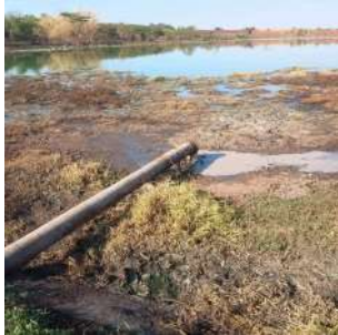
Foto 3 - Situação do trecho inicial da lagoa, com assoreamento evidente.
