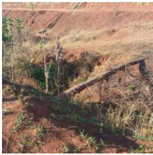
Foto 17 - Emissário de lançamento do efluente após tratamento.
