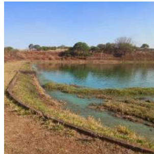
Foto 13 - Trecho final da lagoa, com saídas para emissário.
