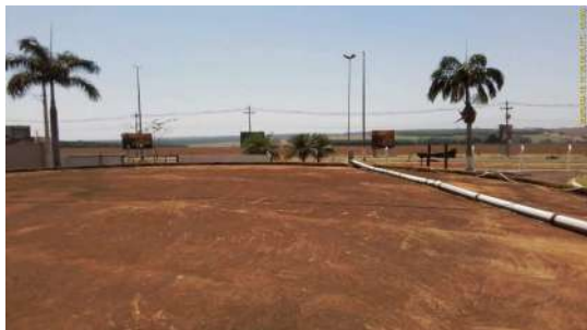
Foto 5 - Vista geral da laje do reservatório.
