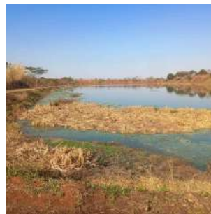
Foto 2 - Vista geral da lagoa de tratamento.
