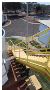
Foto 13 - Escada de acesso e guarda corpo.
