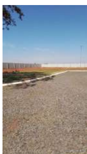
Foto 29 - Cercamento da área da ETA e do CR Comitivas.
