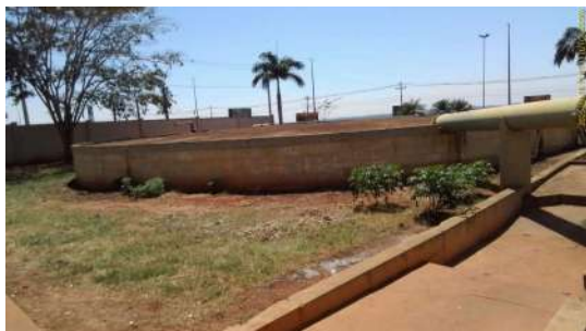
Foto 7 - Vista geral do reservatório.
