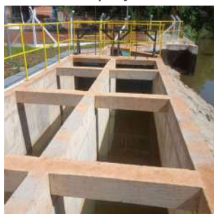
Foto 5 - Canais de desarenação antes do tanque de sucção.
