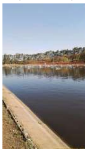
Foto 17 - Aeradores inoperantes na lagoa aeróbia.
