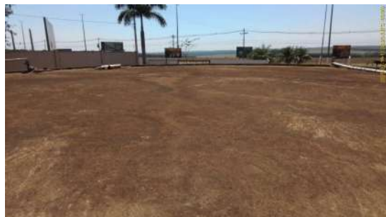
Foto 8 - Vista geral da laje do reservatório.
