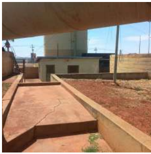
Foto 1 - Vista geral da casa de bombas da elevatória.
