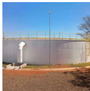
Foto 4 - Vista lateral do reservatório.
