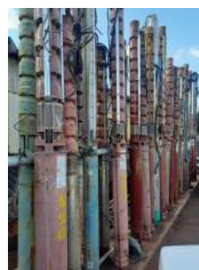
Foto 17 - Conjuntos de bomba reserva armazenados na unidade da Saerp na Rua Pernambuco.
