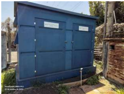
Foto 1 - Abrigo dos reagentes e dosadores para cloração e fluoretação trancado.
