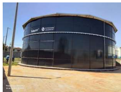
Foto 5 - Vista geral do reservatório.
