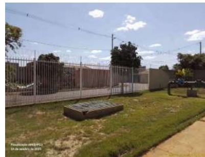
Foto 2 - Vista do interior da área, evidenciando cercamento com gradil metálico.
