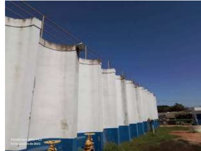
Foto 3 - Guarda corpo na parte superior do reservatório.
