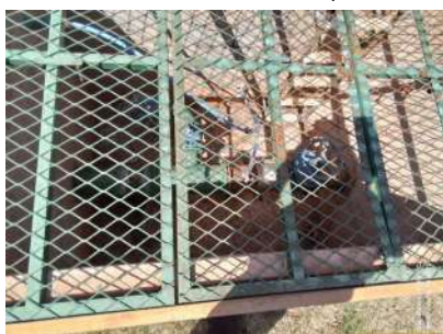
Foto 16 - Registro para manobra na saída da captação.
