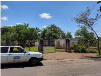
Foto 1 - Vista geral da entrada da área onde se localiza a captação exibindo portão de entrada e cercamento da área com alambrado.
