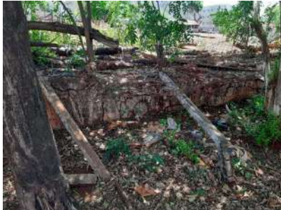
Foto 3 - Dano no cercamento de alambrado.
