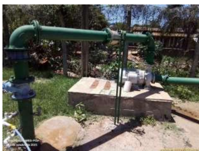
Foto 1 - Vista geral da EEA.
