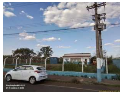
Foto 2 - Vista externa da área, evidenciando cercamento com alambrado
