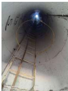
Foto 14 - Escada e guarda corpo para acesso à parte superior do reservatório.
