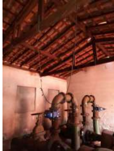
Foto 5 - Vista interna da edificação que abriga a EEA.
