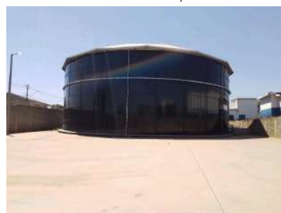
Foto 4 - Vista geral do reservatório.
