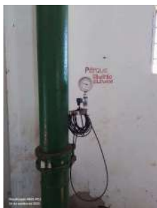
Foto 10 - Manômetro para inferência de nível.
