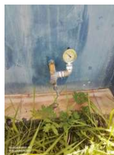
Foto 8 - Manômetro para inferência de nível.
