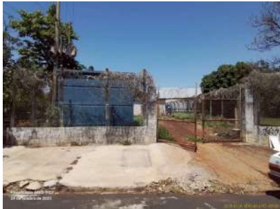
Foto 1 - Vista externa da área onde se localiza a captação.
