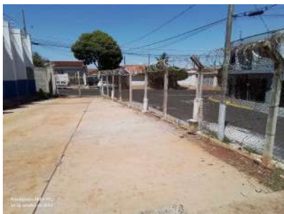
Foto 7 - Cercamento com alambrado na área onde se localiza o reservatório.
