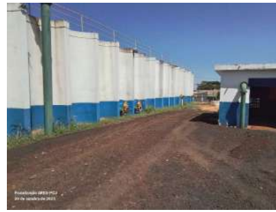
Foto 2 - Vista geral da lateral do reservatório.
