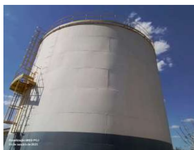
Foto 8 - Vista geral do reservatório, evidenciando guarda corpo na parte superior.
