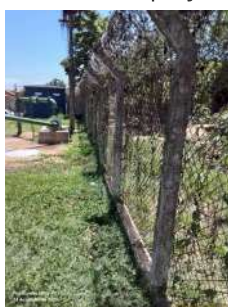
Foto 9 - Cercamento com alambrado nos limites da área.
