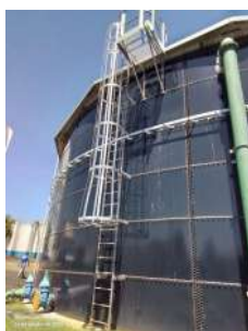
Foto 8 - Escada para acesso à parte superior da estrutura, com guarda corpo.
