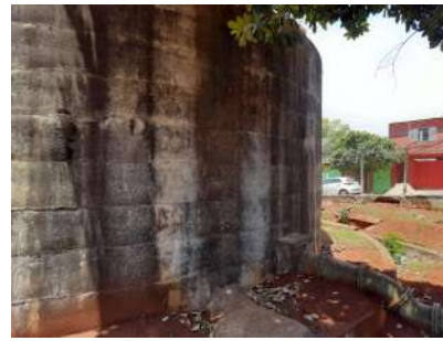
Foto 2 - Tubulação da saída de água do reservatório, para alimentar a EEA instalada ao lado.
