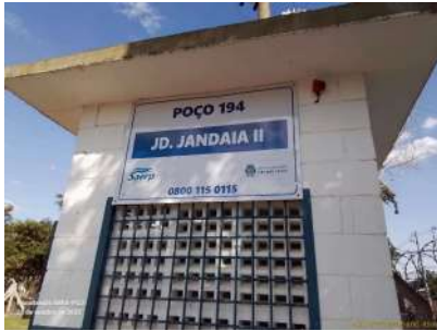
Foto 1 - A placa de identificação existente no local está desatualizada. O poço 194 Jandaia II foi desativado e na mesma área, perfurado o poço 268 Jandaia III, operante e objeto da fiscalização presente.
