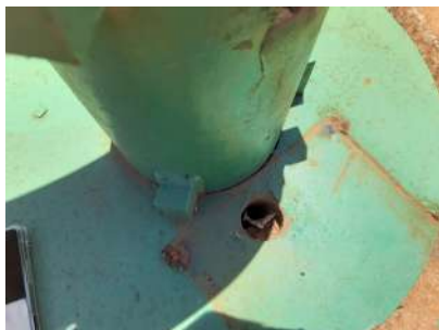
Foto 1 - Tubo de medição de nível do poço.
