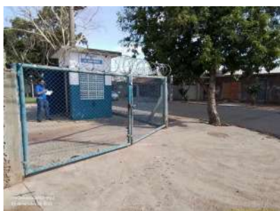
Foto 1 - Vista externa da área, evidenciando cercamento com alambrado de tela e portão metálico.
