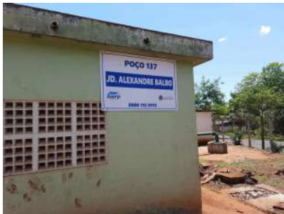
Foto 2 - Placa com identificação da unidade.
