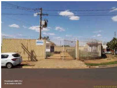
Foto 3 - Vista externa da unidade, evidenciando cercamento com muro, gradil e portão metálico.
