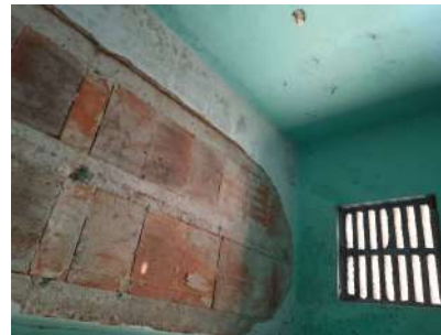
Foto 2 - Laje do banheiro que se localiza na mesma edificação que abriga o painel de comando da unidade.
