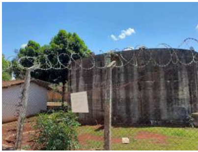
Foto 1 - Dano no cercamento de alambrado.
