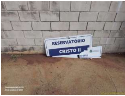
Foto 1 - Placa de identificação quebrada existente no local.
