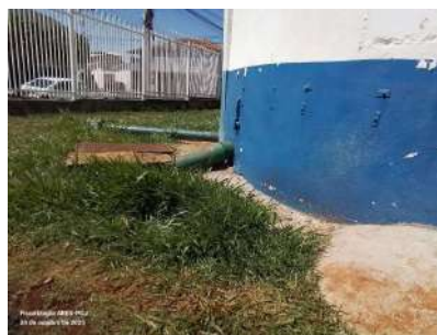
Foto 9 - Saída do tubo extravasor do reservatório.
