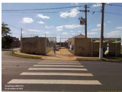
Foto 14 - Vista externa da área, evidenciando cercamento com muro e portão.
