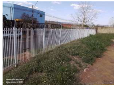
Foto 3 - Vista interna da unidade, evidenciando cercamento com gradil metálico.
