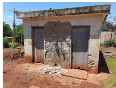
Foto 7 - Vista externa da casa de produtos químicos.
