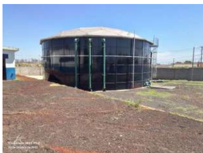
Foto 1 - Vista geral do reservatório.
