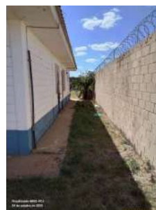
Foto 13 - Vista da área interna da unidade, exibindo cercamento com muro.
