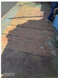
Foto 1 - Placas de concreto armado instaladas para fechamento do compartimento onde estão instaladas as bombas. Não foi possível avaliar o interior do compartimento durante a fiscalização.
