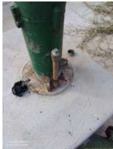
Foto 8 - Tubo para medição de nível
