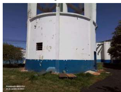
Foto 5 - Vista da base do reservatório.
