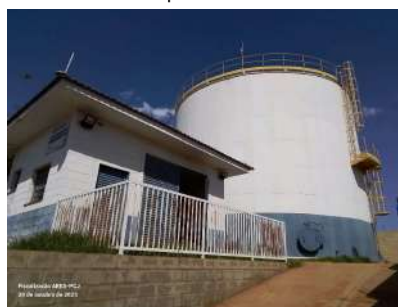
Foto 4 - Vista geral com reservatório ao fundo.
