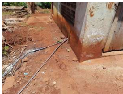
Foto 2 - Tubulação que conduz os produtos químicos até o ponto de adição à água captada.
