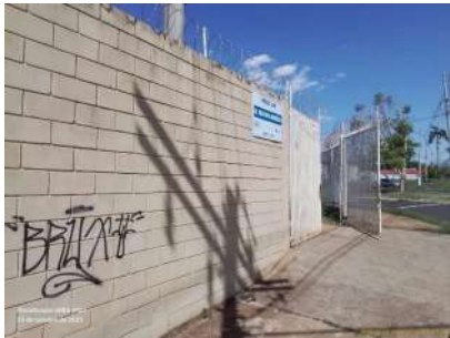
Foto 1 - Vista externa da unidade, evidenciando cercamento com muro e portão metálico.
