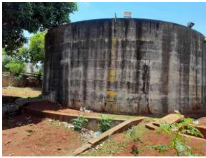
Foto 1 - Vista geral do reservatório.
