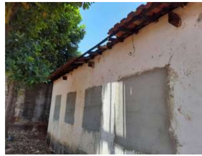
Foto 4 - Vista externa da edificação que abriga a EEA.
