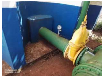
Foto 10 - Manômetro para inferência de nível, na saída do reservatório.
