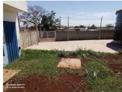
Foto 6 - Portão e cercamento com muro na área onde se localiza o reservatório.
