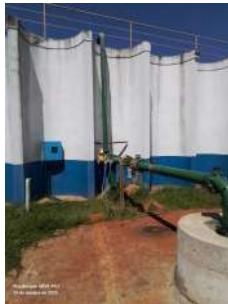
Foto 4 - Saída do poço localizado ao lado do reservatório e tubulação de alimentação.
