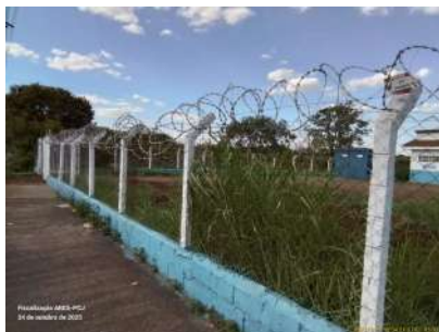
Foto 1 - Vista da área a partir do passeio público, evidenciando cercamento com alambrado e concertina.
