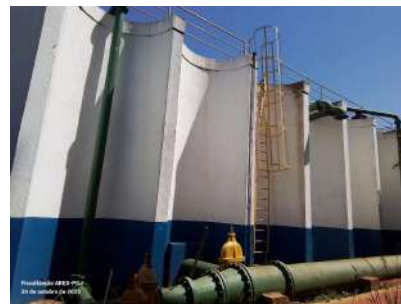
Foto 8 - Escada de acesso à parte superior do reservatório e guarda corpo.
