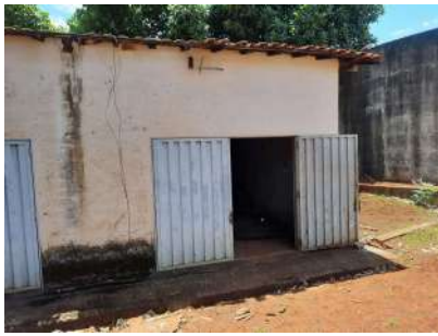
Foto 3 - Vista externa da edificação que abriga a EEA.
