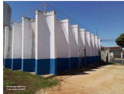
Foto 5 - Vista geral do reservatório.
