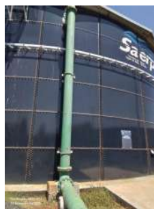
Foto 7 - Tubo extravasor do reservatório, direcionado para galeria pluvial.
