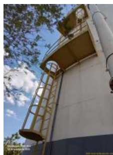
Foto 10 - Escada e guarda corpo do reservatório.
