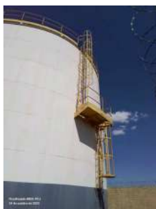
Foto 5 - Escada e guarda corpo instalados na estrutura.
