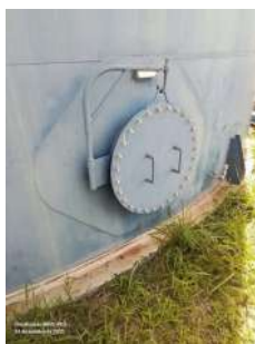
Foto 9 - Tampa de inspeção na parte inferior do reservatório.
