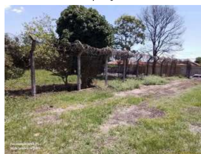
Foto 10 - Cercamento com alambrado nos limites da área.
