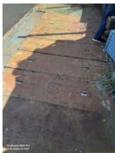
Foto 4 - Placas de concreto armado instaladas para fechamento do compartimento onde estão instaladas as bombas.
