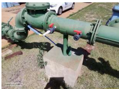
Foto 9 - Ponto para adição de reagente químico utilizado no tratamento.
