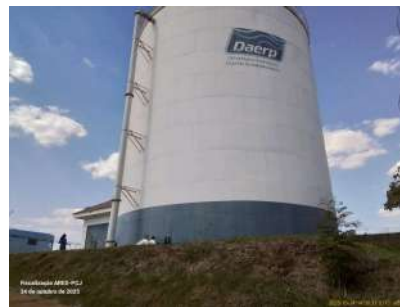
Foto 2 - Vista geral do reservatório.
