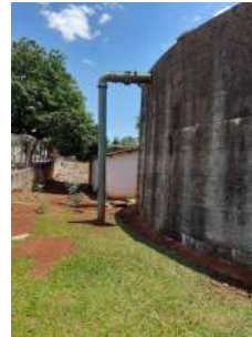
Foto 4 - Tubo extravasor do reservatório.
