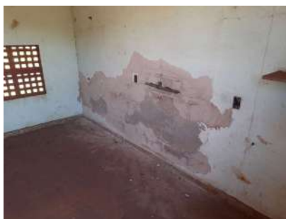
Foto 3 - Interior da edificação que abriga os produtos químicos.
