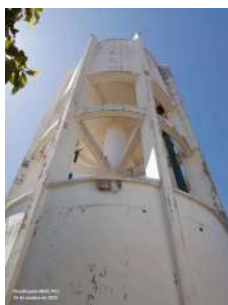
Foto 8 - Vista geral do reservatório.
