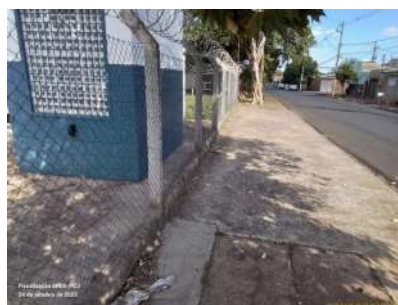
Foto 2 - Vista externa da área, evidenciando cercamento com alambrado de tela.
