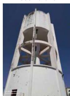
Foto 4 - Vista geral do reservatório.
