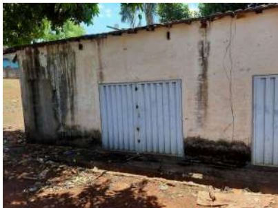
Foto 2 - Vista externa da edificação que abriga a EEA.
