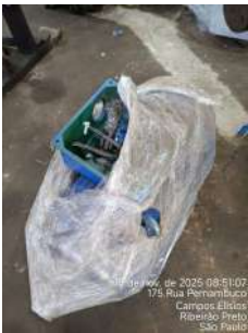
Foto 2 - Fotografia apresentada pelo prestador, referente a conjunto bomba e motor reservas, mantidos para atendimento à unidade fiscalizada.
