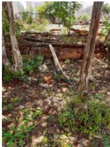
Foto 5 - Mourão de concreto tombado.
