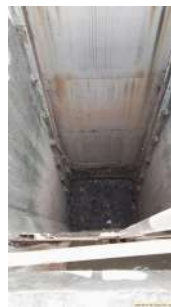
Foto 6 - Vista superior do canal de entrada e do sistema de gradeamento.
