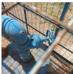
Foto 4 - Detalhe do ponto de coleta água bruta.
