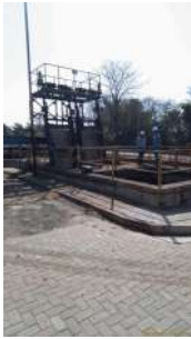
Foto 3 - Vista geral da Estação Elevatória de Esgoto (EEE) e da área externa.
