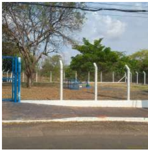
Foto 1 - Vista geral da localização do poço e condição do cercamento da área.
