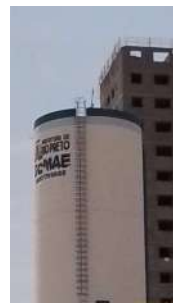
Foto 13 - Vista do reservatório com detalhe para a identificação do local com telefone de contato.
