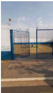
Foto 1 - Vista geral do poço e do portão metálico para controle de acesso ao local.
