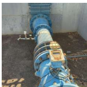
Foto 7 - Detalhe do macromedidor de vazão com ponto de amostragem de água
