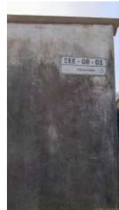
Foto 10 - Detalhe da identificação da unidade (EEE ANA CLÁUDIA 08-01).
