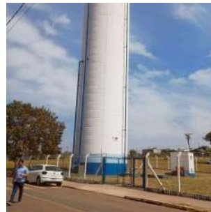
Foto 2 - Vista geral do poço e reservatório adjacente.
