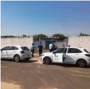
Foto 1 - Vista do cercamento da área em boas condições com portão metálico para controle de acesso.
