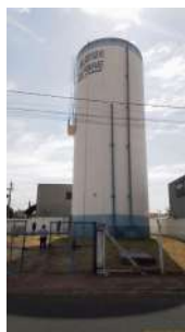
Foto 10 - Vista geral do reservatório elevado.
