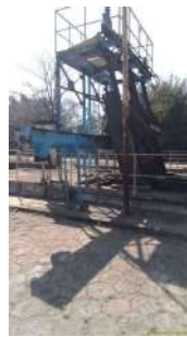
Foto 4 - Vista geral da estrutura do sistema de peneiramento, evidenciando o estado de sucateamento e a inoperância do equipamento.
