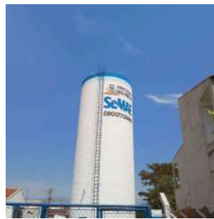
Foto 2 - Vista geral do reservatório elevado com detalhe ao posicionamento da haste do Sistema de Proteção contra Descargas Atmosféricas (SPDA).
