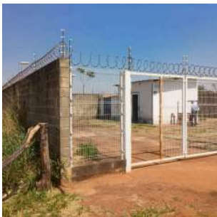
Foto 2 - Detalhe do portão de acesso principal e do cercamento da unidade.
