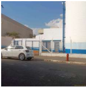
Foto 1 - Vista geral externa do reservatório, evidenciando cercamento da área e controle de acesso através de portão metálico.
