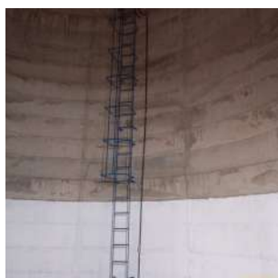
Foto 7 - Vista da escada e guarda-corpo na parte inferior interna do reservatório.
