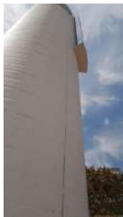
Foto 10 - Fita metálica do SPDA.
