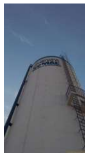
Foto 11 - Vista do reservatório com detalhe para a identificação do local com telefone de contato.
