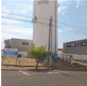
Foto 10 - Vista geral da localização do poço e condição do cercamento da área.
