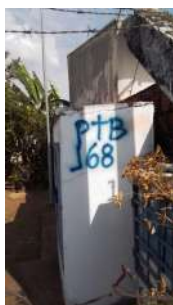
Foto 1 - Evidência da falta de placa de identificação padronizada. A identificação da unidade (PTB 168) foi feita fora do padrão exigido.
