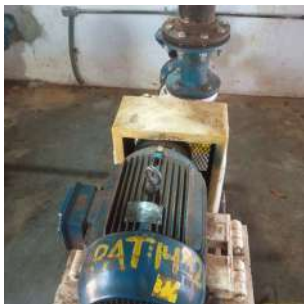
Foto 11 - Vista superior do motor elétrico do CMB-02.
