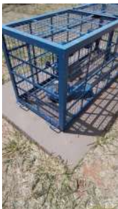
Foto 5 - Detalhe da condição da laje de proteção.
