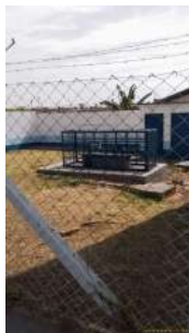
Foto 1 - Vista geral da localização do poço e condição do cercamento da área.
