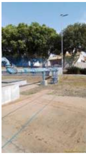
Foto 3 - Vista geral da condição de cercamento da área.
