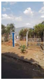
Foto 1 - Vista geral do poço e do portão metálico para controle de acesso ao local.
