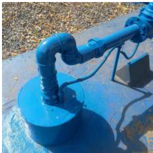
Foto 8 - Detalhe da condição da laje de proteção e sensor de medição de nível do lençol freático.
