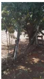
Foto 3 - Evidência da necessidade de manutenção no cercamento.
