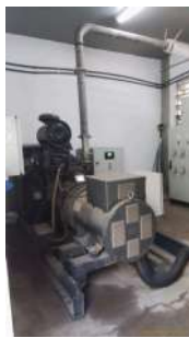
Foto 23 - Detalhe do compressor de ar e seu painel de controle, utilizado para a limpeza ou acionamento de válvulas pneumáticas.
