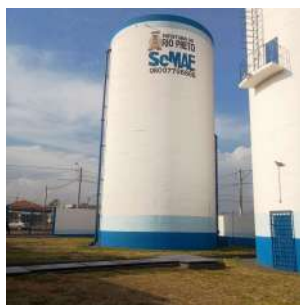
Foto 2 - vista do reservatório com detalhe para a identificação do local com telefone de contato.
