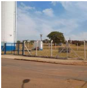
Foto 1 - Vista geral da localização do poço e condição do cercamento da área. com portão metálico para o controle de acesso.
