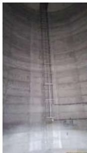
Foto 17 - Vista da escada e guarda-corpo na parte inferior interna do reservatório.
