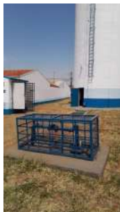
Foto 8 - Vista geral do poço com reservatório ao fundo.
