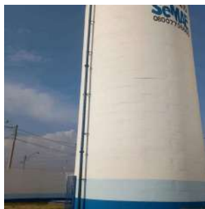
Foto 3 - Vista geral do reservatório.
