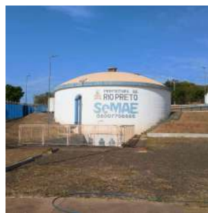
Foto 4 - vista do reservatório para onde a água é recalçada com detalhe para a identificação do local com telefone de contato.
