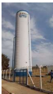
Foto 3 - Vista geral externa do reservatório, evidenciando cercamento da área e controle de acesso através de portão metálico.
