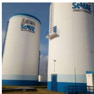
Foto 1 - Detalhe do guarda corpo na escada e plataforma intermediária na parte superior do reservatório.
