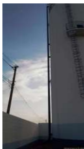
Foto 8 - Vista do tubo extravasor.
