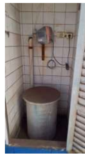
Foto 6 - Armazenamento de flúor sem identificação
