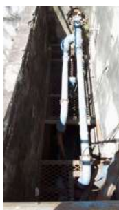
Foto 4 - Vista complementar da tubulação de recalque, destacando a plataforma metálica para acesso e manutenção sobre o poço de sucção.
