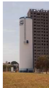
Foto 11 - Detalhe do guarda corpo na escada do reservatório.
