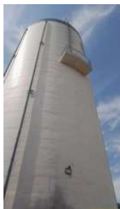
Foto 4 - Detalhe do guarda corpo na escada e plataforma intermediária na parte superior do reservatório.
