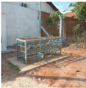
Foto 1 - Vista geral da gaiola de proteção, evidenciando o estado de conservação e a necessidade de limpeza da área.
