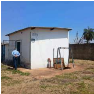
Foto 3 - Vista da casa de bombas da EEE.
