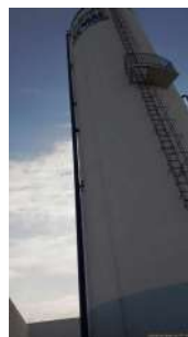
Foto 9 - Detalhe do guarda corpo na escada e plataforma intermediária na parte superior do reservatório.
