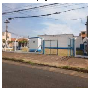
Foto 3 - Vista geral do poço evidenciando cercamento da área e portão para controle de acesso.
