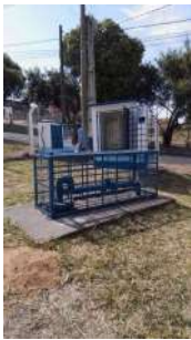
Foto 1 - Vista geral da localização do poço e condição do cercamento da área.
