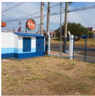
Foto 8 - Vista geral da localização do poço, condição do cercamento da área e abrigo de painéis elétricos do poço.
