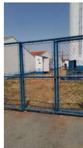
Foto 9 - Em detalhe o portão metálico para controle de acesso ao local.
