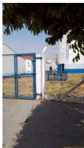
Foto 10 - Vista geral da localização do poço e condição do cercamento da área.
