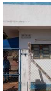
Foto 28 - Detalhe da identificação da EEE na parede externa.
