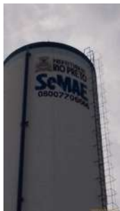
Foto 17 - Detalhe da identificação do local com telefone de contato.
