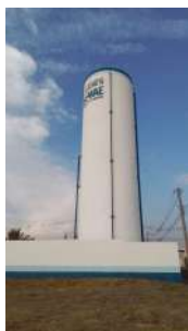
Foto 19 - Vista geral externa do reservatório, evidenciando cercamento da área.
