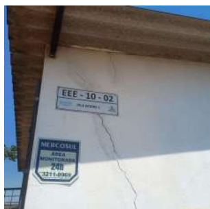
Foto 4 - Detalhe da identificação da unidade (EEE VILA NOBRE 1 - 10-02) na parede externa da casa de bombas.
