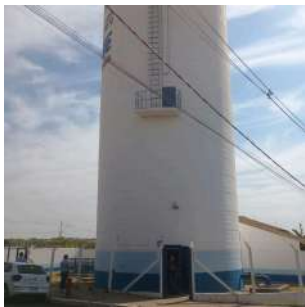
Foto 2 - Detalhe do guarda corpo na escada e plataforma intermediária na parte superior do reservatório.
