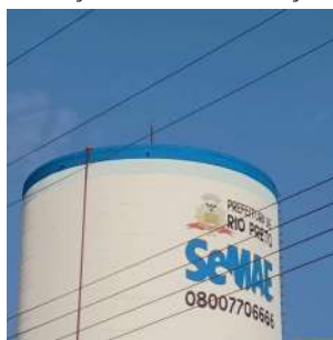
Foto 4 - Vista do reservatório com detalhe para a identificação do local com telefone de contato.
