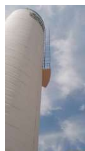
Foto 14 - Detalhe da fita do SPDA.
