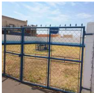
Foto 1 - Detalhe do portão metálico, para controle de acesso, com placa de identificação do poço.
