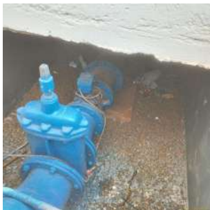
Foto 6 - Válvula sem o seu dispositivo de acionamento (volante/manopla).
