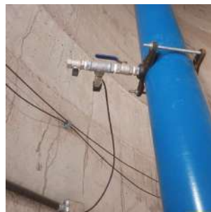
Foto 10 - Detalhe do sensor para medição de nível do reservatório.
