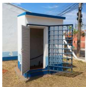
Foto 10 - Vista da nova casa de comando (abrigo de alvenaria) construída para a realocação dos
