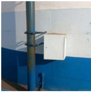
Foto 9 - Detalhe do sensor para medição de nível do reservatório.
