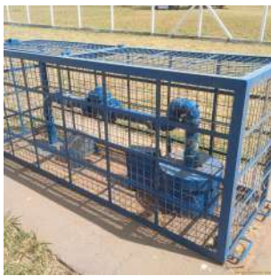
Foto 6 - Detalhe da condição da laje de proteção.
