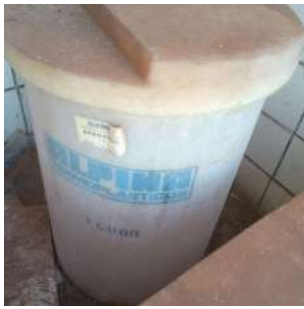
Foto 13 - Armazenamento de Flúor.
