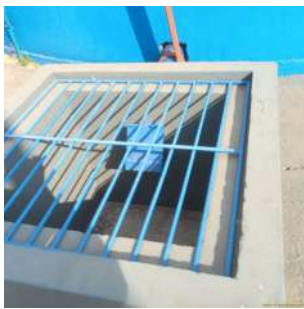
Foto 8 - Saída do tubo extravasor.
