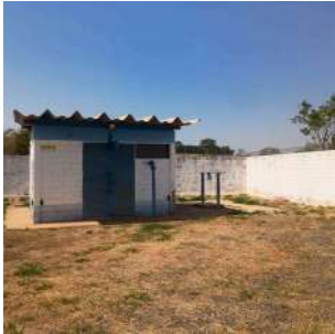
Foto 3 - Vista da área externa da casa de bombas.
