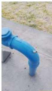
Foto 5 - em detalhe o ponto de coleta de água bruta.
