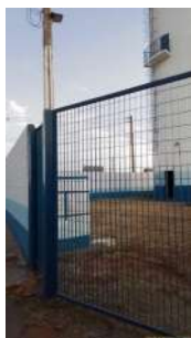
Foto 12 - Detalhe do cercamento do local em boas condições de conservação e controle de acesso através de portão metálico.
