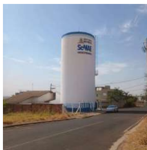
Foto 14 - Vista geral do reservatório elevado com detalhe ao posicionamento da haste do Sistema de Proteção contra Descargas Atmosféricas (SPDA)
