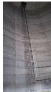
Foto 18 - Vista da escada e guarda-corpo na parte inferior interna do reservatório.
