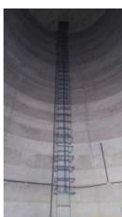
Foto 15 - Vista da escada e guarda-corpo na parte inferior interna do reservatório.
