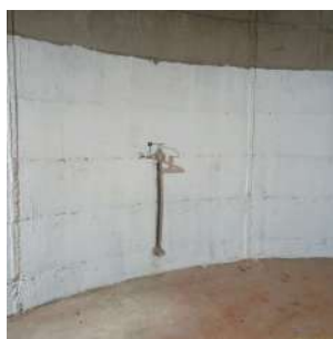
Foto 8 - Detalhe do ponto de coleta de água do reservatório para amostragem .
