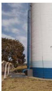
Foto 6 - Vista do tubo extravasor do reservatório.
