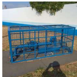
Foto 3 - Detalhe da condição da laje de proteção.
