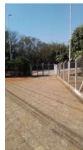
Foto 27 - Vista do cercamento perimetral da EEE.
