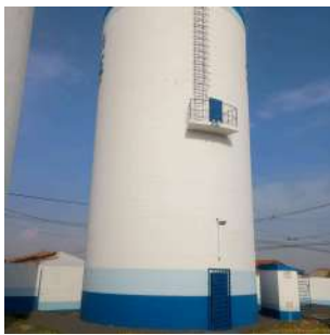
Foto 6 - Vista geral externa do reservatório, evidenciando as boas condições de cercamento da área.
