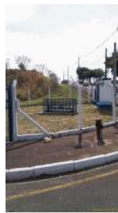
Foto 13 - Vista geral do reservatório evidenciando cercamento da área e portão para controle de acesso.
