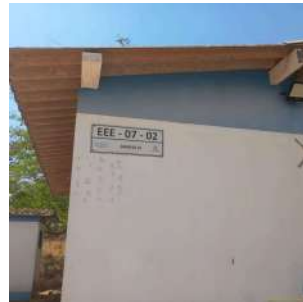
Foto 3 - Detalhe da identificação da unidade (EEE- 07-02 - DAHMA VI) na parede externa da casa de bombas.
