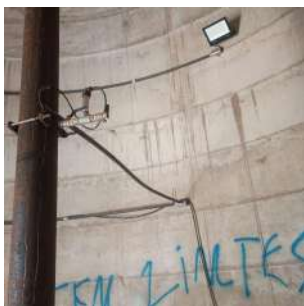
Foto 5 - Detalhe do sensor para medição de nível do reservatório.
