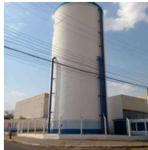
Foto 3 - Vista geral do reservatório.
