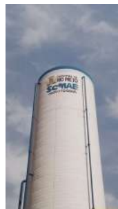
Foto 5 - Vista do reservatório com detalhe para a identificação do local com telefone de contato.
