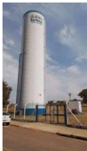
Foto 1 - Vista geral do reservatório.
