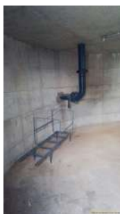
Foto 6 - Vista interna do reservatório.
