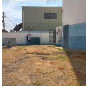
Foto 11 - Vista geral do poço e reservatório adjacente.
