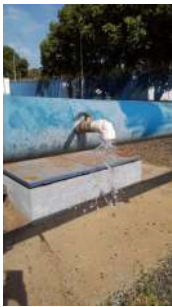
Foto 5 - Detalhe do ponto de coleta de água bruta.
