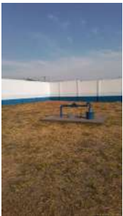
Foto 2 - Vista geral da localização do poço e condição do cercamento da área em boas condições..
