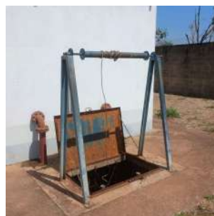
Foto 5 - Vista da estrutura de içamento cesto de retenção de sólidos sobre o poço de sucção.
