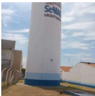
Foto 3 - vista do reservatório com detalhe para a identificação do local com telefone de contato.
