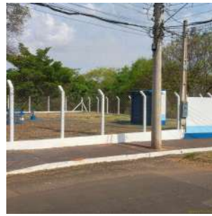
Foto 2 - Detalhe da boa condição do cercamento da área de entorno ao poço.
