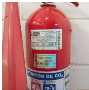
Foto 15 - Extintor de incêndio dentro da validade.
