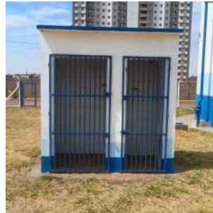
Foto 9 - Vista do local de armazenamento e de dosagem de cloro e flúor sem produto porque o poço não está em operação.
