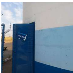
Foto 13 - Detalhe da placa de indicação do poço que abastece o reservatório.
