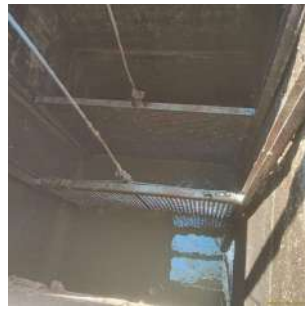
Foto 16 - Vista do poço de sucção, evidenciando o sistema de gradeamento, a estrutura interna e a tubulação de recalque.
