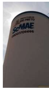
Foto 6 - Vista do reservatório com detalhe para a identificação do local com telefone de contato.
