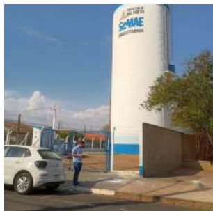
Foto 1 - Vista geral do reservatório elevado.
