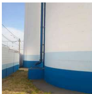
Foto 6 - Vista da extremidade de saída tubo extravasor do reservatório.
