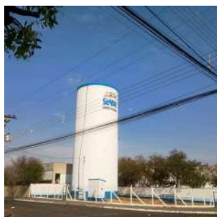
Foto 3 - Em detalhe o posicionamento da haste do Sistema de Proteção contra Descargas Atmosféricas (SPDA).
