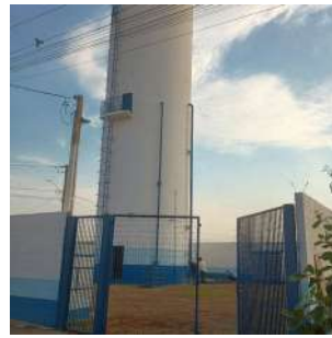
Foto 14 - Vista geral da localização do poço e da boa condição do cercamento da área.
