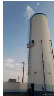
Foto 2 - Detalhe do guarda corpo na escada do reservatório.
