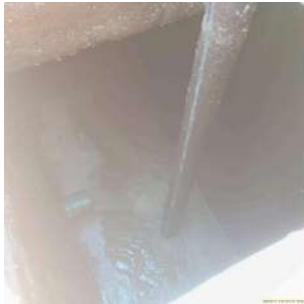
Foto 17 - Vista complementar do poço de sucção, evidenciando o estado de conservação da estrutura.
