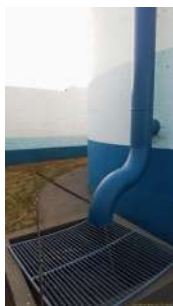
Foto 10 - Detalhe do fosso de drenagem da água extravasada.
