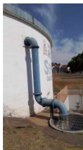
Foto 4 - Vista do Tubo extravasor.
