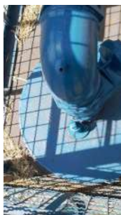
Foto 7 - Detalhe do ponto de coleta de água bruta.
