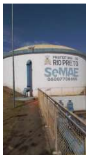
Foto 5 - Vista do reservatório com detalhe para a identificação do local com telefone de contato.
