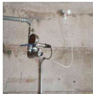
Foto 10 - Detalhe do ponto de coleta de água do reservatório para amostragem .
