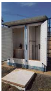
Foto 14 - Vista do local de armazenamento e de dosagem de cloro e flúor.
