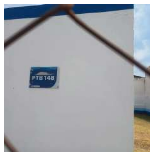
Foto 2 - Em detalhe a placa de identificação do poço.
