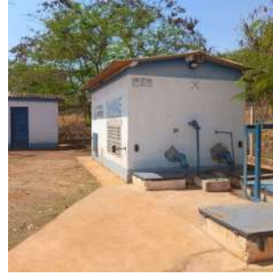
Foto 2 - Vista da fachada da casa de bombas e da tubulação de recalque externa.
