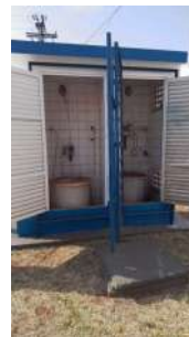
Foto 8 - Local de armazenamento e dosagem de produtos químicos.
