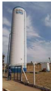
Foto 2 - Vista geral do reservatório.
