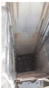
Foto 7 - Vista do canal de entrada e do sistema de peneiramento (gradeamento fino).
