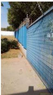
Foto 1 - Vista da condição de cercamento da área.
