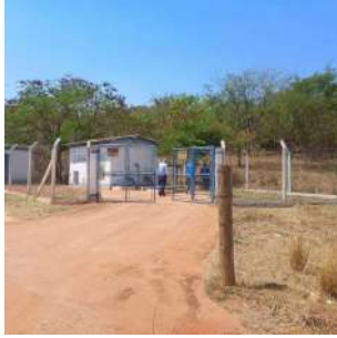
Foto 1 - Vista geral da Estação Elevatória de Esgoto (EEE), mostrando o cercamento perimetral e a área externa.
