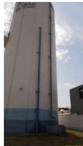
Foto 2 - Vista do tubo extravasor do reservatório.
