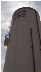
Foto 1 - Detalhe do guarda corpo na escada e plataforma intermediária na parte superior do reservatório.
