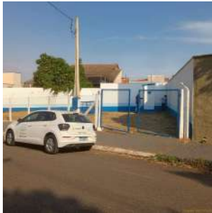
Foto 1 - Vista geral da localização do poço e condição do cercamento da área e portão metálico para controle de acesso.
