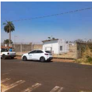
Foto 1 - Vista geral da Estação Elevatória de Esgoto (EEE), mostrando o acesso e o cercamento perimetral.
