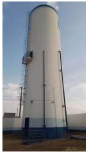
Foto 1 - Vista geral do reservatório.
