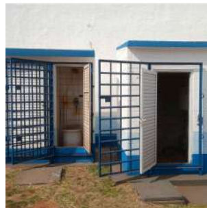
Foto 7 - Vista da nova casa de comando (abrigo de alvenaria) construída para a realocação dos painéis elétricos.
