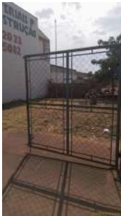
Foto 1 - Em detalhe o portão metálico para controle de acesso ao local.
