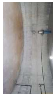
Foto 5 - Vista interna do reservatório.
