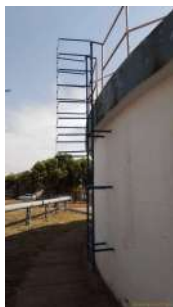
Foto 1 - Detalhe do guarda corpo na escada do reservatório.
