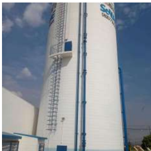
Foto 4 - Detalhe do guarda corpo na escada do reservatório.
