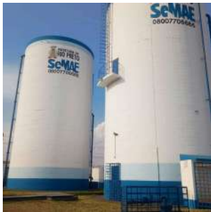
Foto 1 - vista do reservatório.
