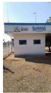
Foto 24 - Vista geral da EEE e da área externa.
