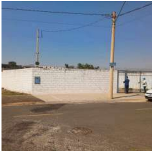
Foto 2 - Vista geral da localização da Estação Elevatória de Esgoto.
