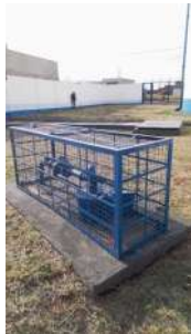
Foto 7 - Vista geral da localização do poço e condição do cercamento da área.
