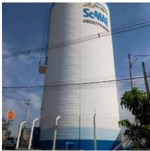
Foto 4 - Vista geral do reservatório elevado.
