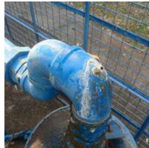
Foto 8 - Detalhe do ponto de coleta de água bruta.
