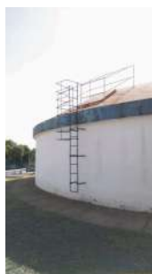
Foto 7 - Detalhe da tampa de inspeção.
