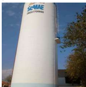
Foto 5 - Detalhe do guarda corpo na escada e plataforma intermediária na parte superior do reservatório.
