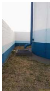
Foto 7 - Detalhe da extremidade de saída do tubo extravasor.
