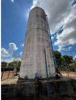
Foto 3 - Vista geral do reservatório
