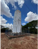
Foto 6 - Vista da área
