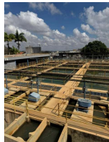
Foto 14 - Vista geral da ETA
