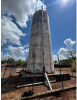
Foto 4 - Vista geral do reservatório
