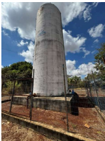
Foto 1 - Vista geral do reservatório
