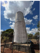
Foto 2 - Vista geral do reservatório
