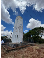
Foto 5 - Vista da área
