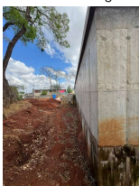
Foto 5 - Detalhe da parede
