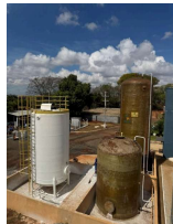
Foto 15 - Tanque de produtos químicos
