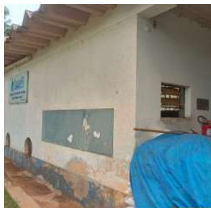
Foto 1 - Vista geral da casa de bombas, na entrada da ETA.
