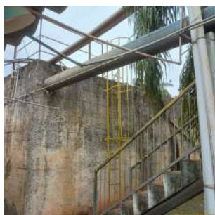
Foto 1 - Vista geral do reservatório.
