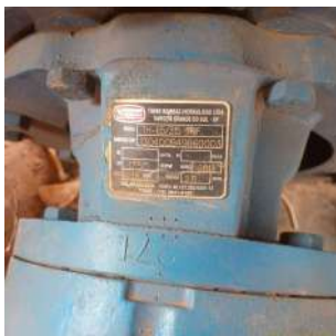
Foto 10 - Placa de especificações técnicas da bomba do conjunto motobomba instalado.
