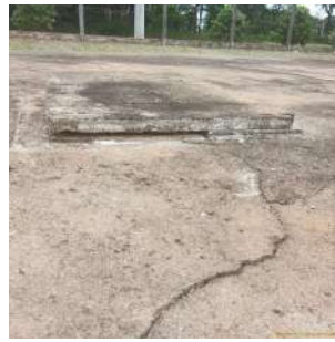
Foto 2 - Tampa de inspeção de concreto do reservatório 1.
