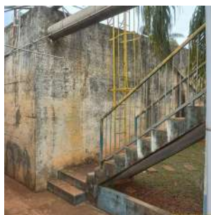
Foto 2 - Vista geral do reservatório.
