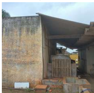
Foto 5 - Vista geral do reservatório e, à direita, a EEAT da ETA.
