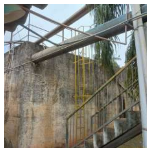
Foto 4 - Chegada da tubulação em ferro fundido no reservatório.
