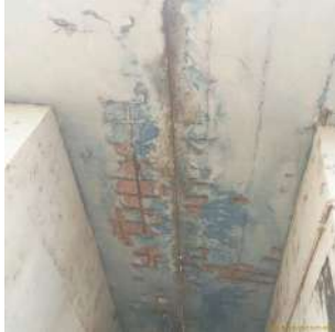
Foto 5 - Exposição de ferragens na lateral das unidade de filtração.
