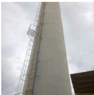
Foto 1 - Vista geral do reservatório antigo.
