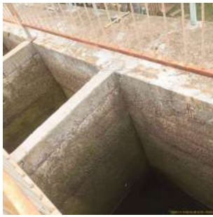
Foto 3 - Situação da alvenaria nos filtros.
