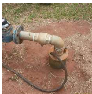
Foto 2 - Vista geral do poço.
