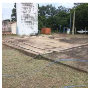
Foto 1 - Vista geral do primeiro reservatório enterrado, situado à frente do reservatório elevado.
