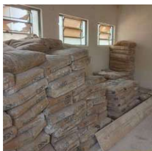
Foto 11 - Armazenamento de sacarias de cal hidratada.
