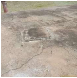
Foto 1 - Tampa de inspeção de concreto do reservatório 1.
