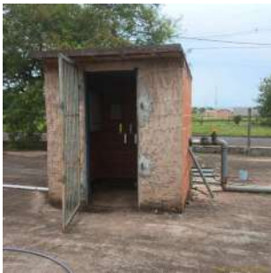
Foto 2 - Vista geral da casa de bombas.
