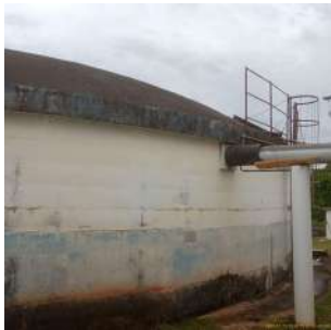
Foto 3 - Vista geral do reservatório.
