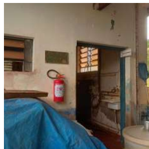
Foto 2 - Vista geral da entrada da casa de bombas.
