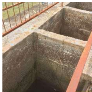
Foto 2 - Situação da alvenaria nos filtros.
