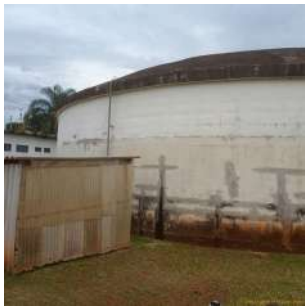
Foto 1 - Vista geral do reservatório.
