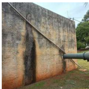
Foto 3 - Vista geral do reservatório.
