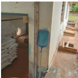
Foto 11 - Local de fixação da mangueira para medição de nível
