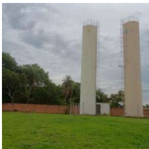
Foto 8 - Vista geral dos dois reservatórios do CR Campos Elísios II: à esquerda (branco) o antigo e, à direita (amarelo), o mais novo.
