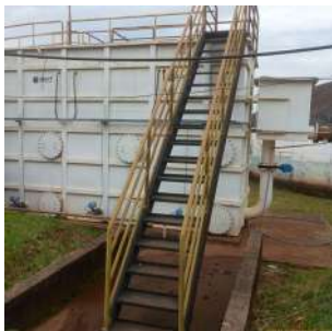
Foto 7 - Escada de acesso à ETA.
