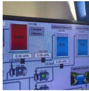
Foto 15 - Detalhe para o nível do reservatório do CR Campos Elísios II.
