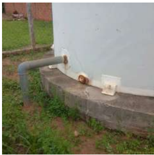
Foto 3 - Base do reservatório antigo.
