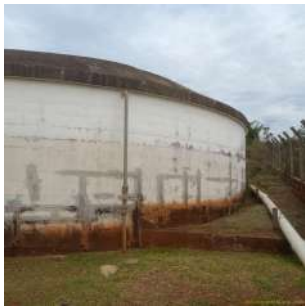
Foto 2 - Vista geral do reservatório.
