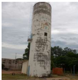
Foto 4 - Vista geral do entorno do reservatório.
