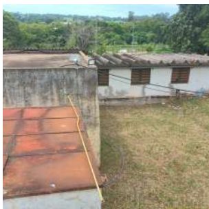
Foto 26 - Vista do tanque intermediário e o reservatório retangular.
