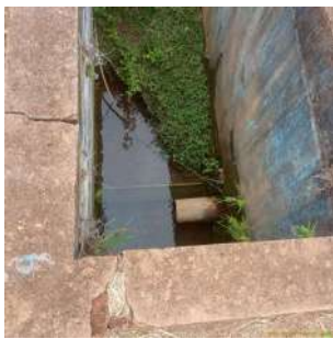
Foto 7 - Caixa enterrada que recebe água de escoamento superficial e vazamentos da chegada de água bruta na ETA Convencional.
