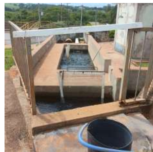
Foto 4 - Canal de passagem da água bruta.
