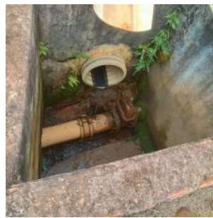
Foto 8 - Caixa enterrada que recebe água de escoamento superficial e vazamentos da chegada de água bruta na ETA Convencional.
