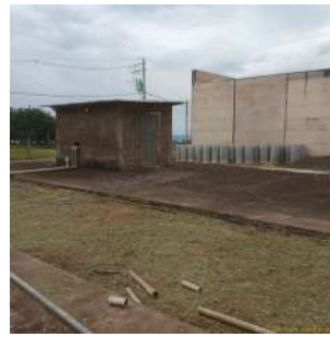
Foto 8 - Vista geral do reservatório enterrado 2 e, ao fundo da EEAT 2, que recalca para o Reservatório elevado Campos Elísios I (que fica ao lado dos enterrados) e para o Campos Elísios II.
