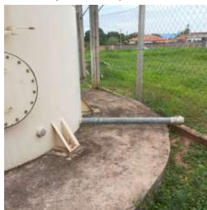
Foto 11 - Vista geral da base do reservatório novo.
