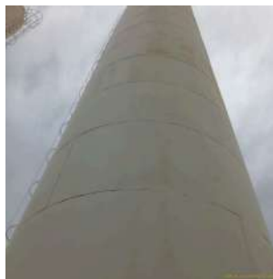
Foto 6 - Vista geral do reservatório antigo.
