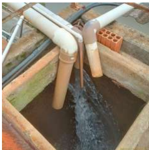
Foto 9 - Abertura de inspeção e de entrada de tubulações no reservatório.
