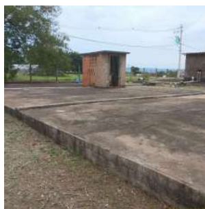
Foto 4 - Vista geral do primeiro reservatório enterrado e, ao fundo, a EEAT 1, que recalca para o reservatório elevado Santa Cecília.
