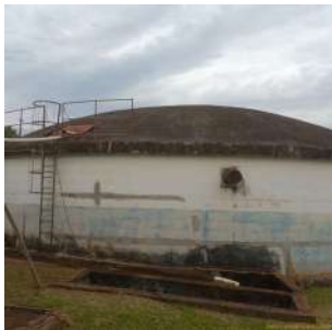
Foto 6 - Vista geral do reservatório.
