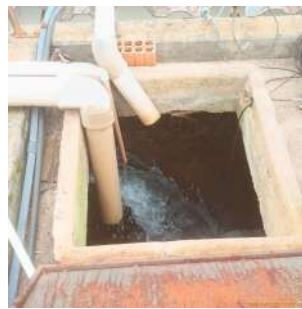
Foto 8 - Abertura de inspeção e de entrada de tubulações no reservatório.
