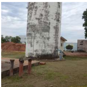
Foto 3 - Vista geral do entorno do reservatório.
