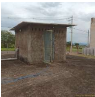
Foto 1 - Vista geral da casa de bombas da EEAT 2.
