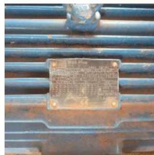
Foto 9 - Placa de especificações técnicas do motor do conjunto motobomba instalado.
