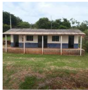
Foto 16 - Abrigo de produtos químicos da ETA Compacta.
