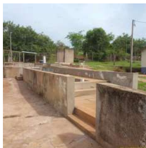
Foto 7 - Vista geral da área de chegada da água bruta.
