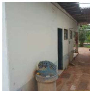
Foto 29 - Prédio administrativo e dos laboratórios da ETA.
