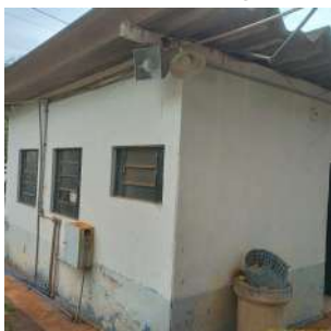
Foto 28 - Prédio administrativo e dos laboratórios da ETA.
