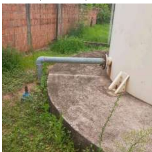
Foto 10 - Vista geral da base do reservatório novo.
