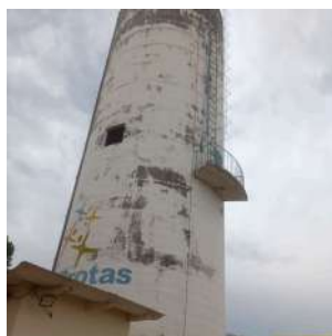
Foto 6 - Vista geral do reservatório.
