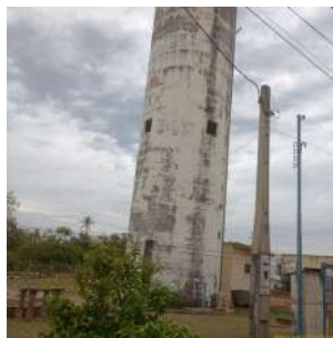
Foto 2 - Vista geral do reservatório elevado.
