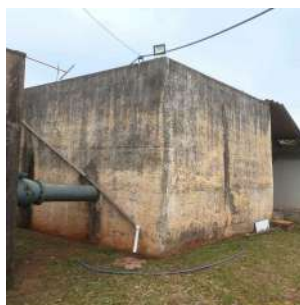
Foto 4 - Vista geral do reservatório.
