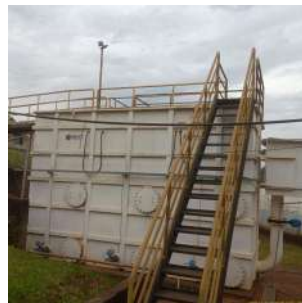
Foto 8 - Escada de acesso à ETA.
