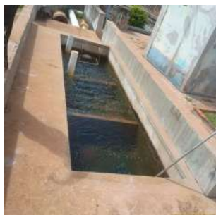
Foto 6 - Canal de passagem da água bruta.
