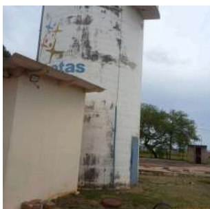
Foto 5 - Vista geral do entorno do reservatório.
