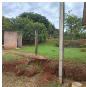
Foto 2 - Ausência de cercamento adequado no entorno da área das ETAs.
