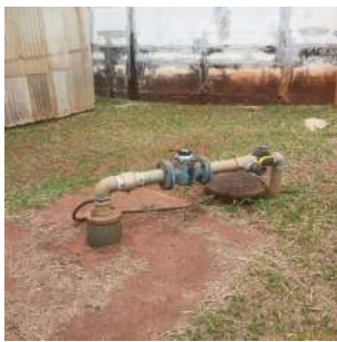
Foto 5 - Vista geral do poço.
