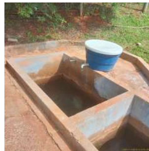
Foto 2 - Chegada da água bruta dos Córregos Águas Claras e Minhoca, com dosagem inicial de cloro (pré-cloração).
