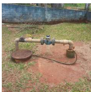
Foto 1 - Vista geral do poço.
