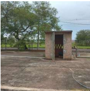
Foto 1 - Vista geral da casa de bombas.
