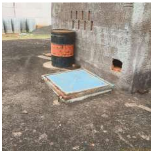
Foto 11 - Tampa de inspeção do reservatório enterrado 2.
