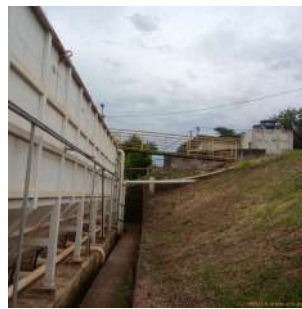
Foto 6 - Vista geral da ETA Compacta.
