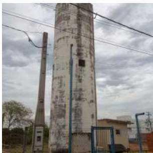
Foto 1 - Vista geral do reservatório elevado.
