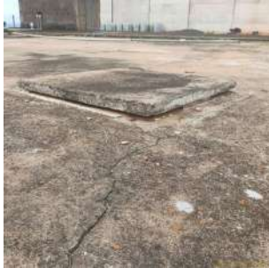
Foto 3 - Tampa de inspeção de concreto do reservatório 1.
