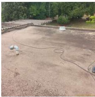
Foto 7 - Laje do reservatório.
