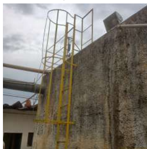
Foto 6 - Acesso à laje do reservatório.
