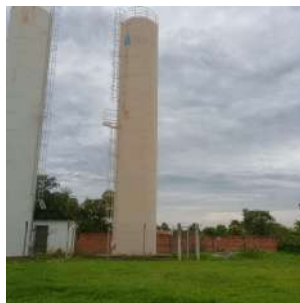
Foto 9 - Vista geral dos dois reservatórios do CR Campos Elísios II: à esquerda (branco) o antigo e, à direita (amarelo), o mais novo.
