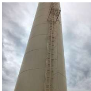
Foto 13 - Vista geral do reservatório novo.
