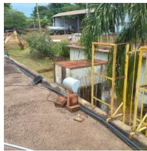
Foto 2 - Vista geral da laje do reservatório, sem guarda-corpo.
