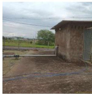
Foto 2 - Vista geral da casa de bombas da EEAT 2.
