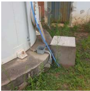
Foto 4 - Base do reservatório antigo.
