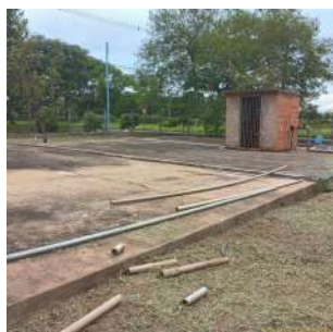
Foto 3 - Vista geral do primeiro reservatório enterrado e, ao fundo, a EEAT 1, que recalca para o reservatório elevado Santa Cecília.
