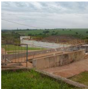
Foto 27 - Vista geral da ETA Compacta.
