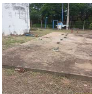
Foto 2 - Vista geral do primeiro reservatório enterrado.
