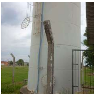
Foto 2 - Vista geral do reservatório antigo.
