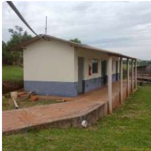
Foto 17 - Abrigo de produtos químicos da ETA Compacta.
