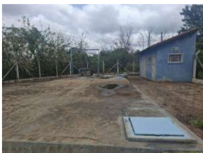
Foto 8 - Vista interna da EEEB Jardim Planalto.
