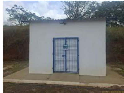
Foto 10 - Casa de comando dos aeradores.
