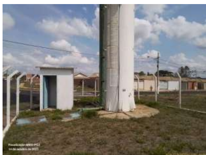
Foto 1 - Vista geral área interna, evidenciando cercamento do local.
