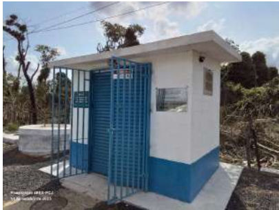
Foto 1 - Vista geral do abrigo do quadro de comando da unidade.
