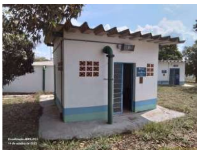
Foto 1 - Vista externa da estação elevatória.
