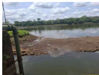
Foto 14 - Ponto de sucção da água bruta na captação II (água tomada da represa).
