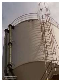
Foto 7 - Detalhe do extravasor (topo do reservatório, à esquerda da escada) protegido com grade.
