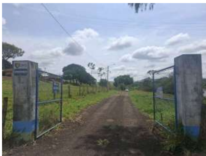
Foto 1 - Portão de acesso à área da captação, evidenciando cercamento da área.
