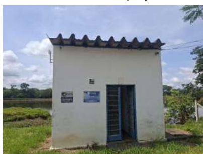
Foto 11 - Vista externa da casa de bombas da captação II.
