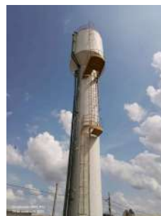
Foto 3 - Vista geral reservatório, evidenciando escadas e guarda corpos.
