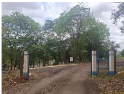
Foto 1 - Portão de acesso a ETE.
