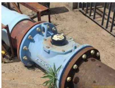
Foto 3 - Medidor de vazão da água que chega a partir da represa São Valentim.
