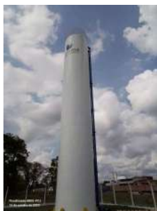
Foto 3 - Vista geral do reservatório.
