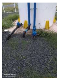
Foto 6 - Tubo de alimentação do reservatório à direita e tubo extravasor à esquerda.
