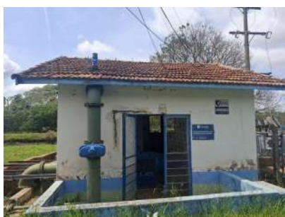
Foto 7 - Vista externa da casa de bombas da captação I.
