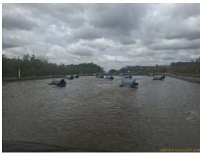
Foto 7 - Lagoa de aeração para estabilização.
