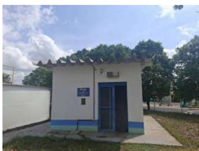
Foto 1 - Vista externa da estação elevatória.
