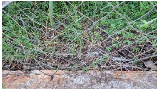
Foto 2 - Registro fotográfico enviado pelo prestador, evidenciando o fechamento da abertura antes existente.
