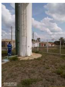
Foto 4 - Vista da base do reservatório.
