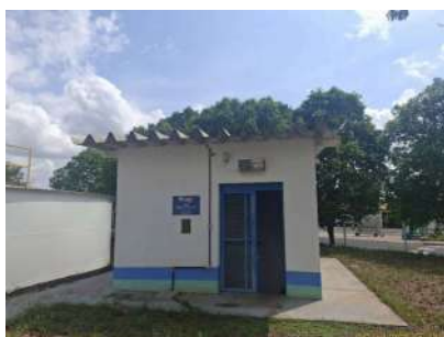
Foto 1 - Vista externa da unidade.
