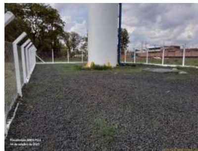
Foto 2 - Vista geral área interna do local, evidenciando cercamento.
