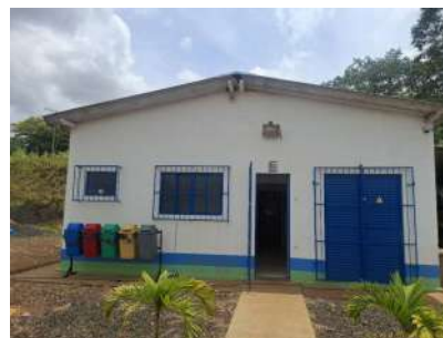
Foto 14 - Vista externa do laboratório da ETE.
