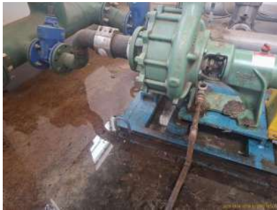
Foto 1 - Drenagem inadequada da água de lubrificação de gaxeta leva ao acúmulo de água no piso.
