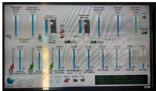
Foto 8 - Painel exibindo níveis dos reservatório no CCO do prestador.
