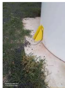
Foto 4 - Detalhe evidenciando aterramento da estrutura.
