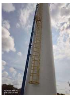
Foto 5 - Escada e guarda corpo instalados na estrutura.
