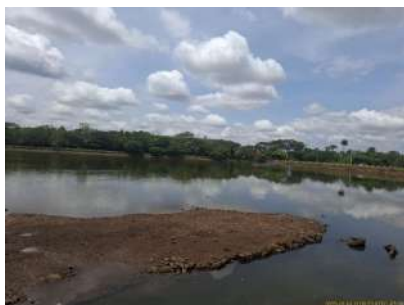
Foto 15 - Vista geral da represa Passa Quatro.
