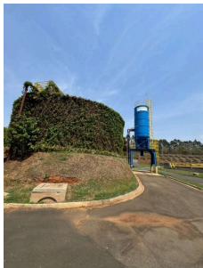
Foto 23 - Adensador de lodo
