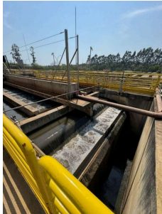
Foto 7 - Canaleta de esgoto bruto
