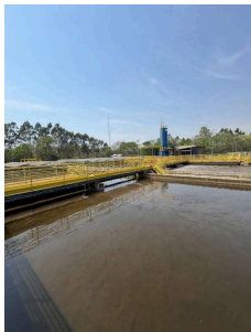
Foto 13 - Vista do tanque de aeração
