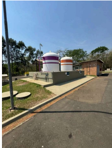
Foto 17 - Tanque de produtos químicos
