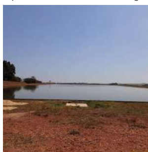
Foto 4 - Vista geral da lagoa facultativa a partir do ponto de entrada do efluente proveniente da lagoa anaeróbica.
