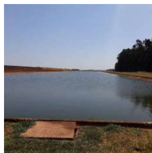
Foto 10 - Vista geral da lagoa de maturação a partir do ponto de saída do efluente tratado.
