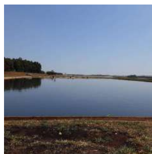
Foto 2 - Vista geral da lagoa anaeróbica a partir do ponto de entrada do esgoto.
