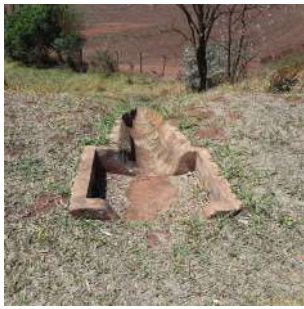
Foto 11 - Canaleta de drenagem de águas pluviais implantada no talude da lagoa de maturação.
