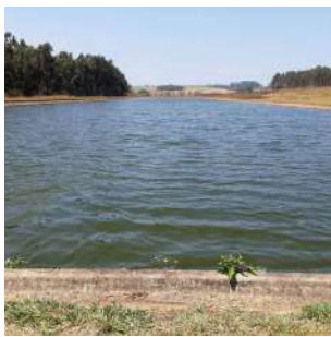
Foto 7 - Vista geral da lagoa de maturação a partir do ponto de entrada do efluente proveniente da lagoa facultativa.
