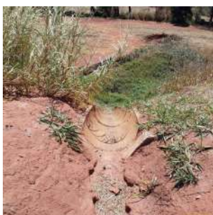
Foto 8 - Canaleta de drenagem de águas pluviais implantada no talude da lagoa de maturação.
