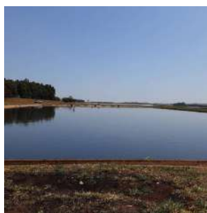
Foto 2 - Vista geral da lagoa anaeróbica a partir do ponto de entrada do esgoto.
