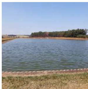
Foto 6 - Vista geral da lagoa facultativa a partir do ponto de saída do efluente.
