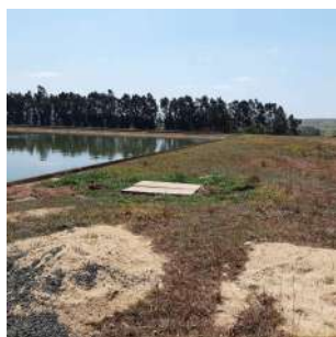
Foto 5 - Tampas de proteção das tubulações que conduzem o efluente da lagoa anaeróbica para a lagoa facultativa.
