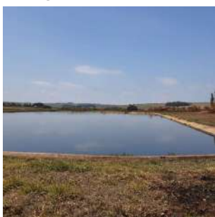
Foto 3 - Vista geral da lagoa anaeróbica a partir do ponto de saída do efluente.
