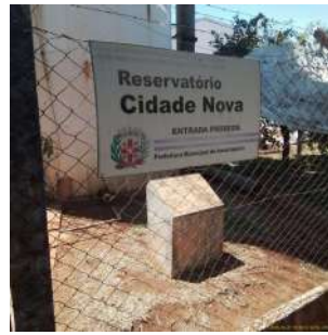
Foto 6 - Placa de identificação do Reservatório
