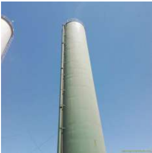
Foto 1 - Reservatório Cidade Nova II
