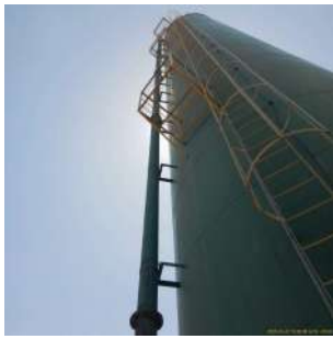
Foto 5 - Destaque para escada e para-raio
