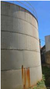
Foto 2 - Lateral do reservatório
