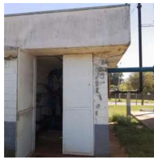
Foto 6 - Estrutura da elevatória
