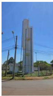
Foto 1 - Visão dos reservatórios
