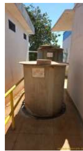
Foto 11 - Tanques de produtos químicos (ácido fluossilícico)
