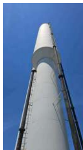
Foto 2 - Reservatório elevado Campo Verde II
