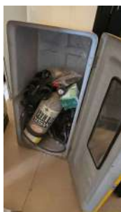
Foto 27 - EPI disponível para a utilização do Cloro Gás
