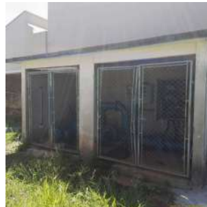
Foto 8 - Estrutura da estação elevatória
