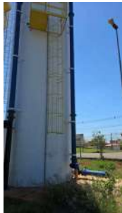
Foto 3 - Destaque para escada de acesso
