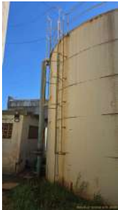
Foto 1 - Destaque para escada de acesso e guarda-corpo
