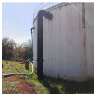
Foto 3 - Lateral do reservatório
