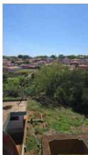
Foto 8 - Cercamento nos fundos da ETA
