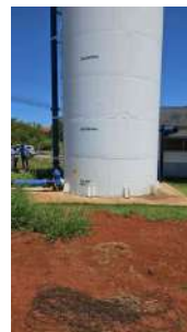
Foto 6 - Base de concreto do reservatório
