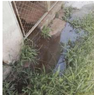
Foto 2 - Água do vazamento
