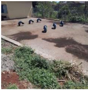
Foto 1 - Reservatório enterrado e tubulações de respiro
