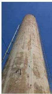
Foto 5 - Lateral do reservatório
