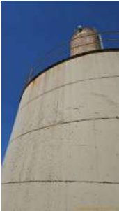
Foto 3 - Lateral do reservatório
