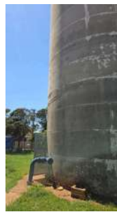
Foto 2 - Lateral do reservatório
