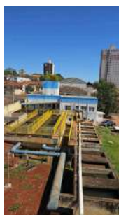
Foto 7 - Estação de Tratamento de Água
