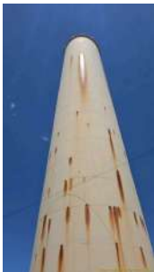
Foto 3 - Reservatório Cidade Nova I
