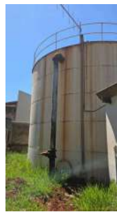
Foto 5 - Reservatório Apoiado Ometto Pavan I
