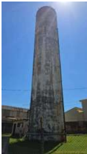
Foto 1 - Reservatório Elevado Ometto Pavan II
