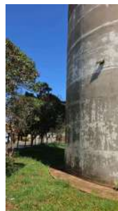
Foto 5 - Lateral do reservatório
