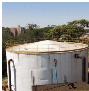
Foto 2 - Vista superior do reservatório
