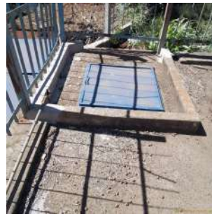
Foto 2 - Tampa do reservatório
