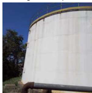
Foto 6 - Lateral do reservatório
