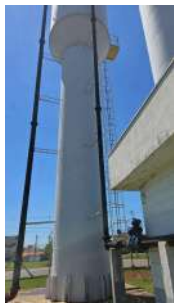
Foto 3 - Reservatório elevado Campo Verde II
