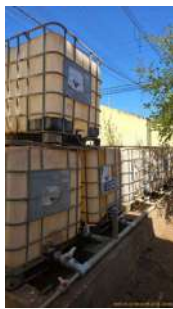
Foto 10 - Tanques de plástico de policloreto de alumínio (não utilizados)
