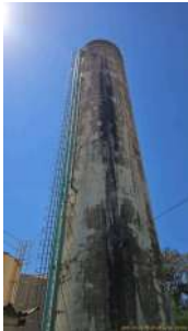
Foto 3 - Escada de acesso e guarda-corpo
