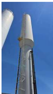
Foto 1 - Reservatório elevado Campo Verde II
