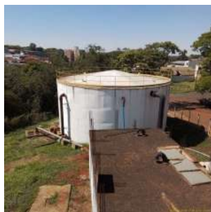
Foto 1 - Vista superior do reservatório
