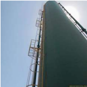
Foto 3 - Escada de acesso e tubulações laterais
