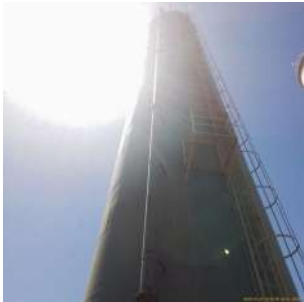
Foto 4 - Reservatório Cidade Nova II
