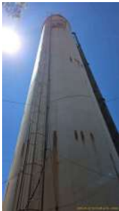
Foto 1 - Escada de acesso e guarda-corpo
