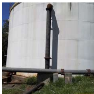
Foto 5 - Lateral do reservatório
