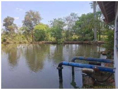
Foto 2 - Tomada de água
