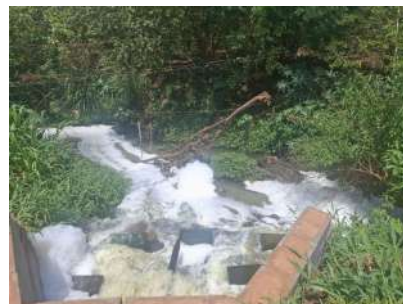
Foto 8 - Lançamento do esgoto tratado
