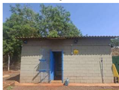
Foto 6 - Abrigo dos painéis da EEEB Final
