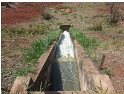
Foto 7 - Dissipador de energia
