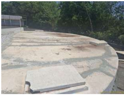
Foto 3 - Tampa de inspeção
