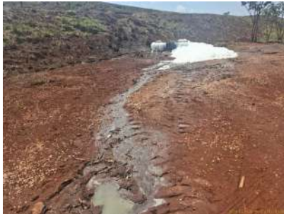
Foto 1 - Extravasamento na caixa de inspeção
