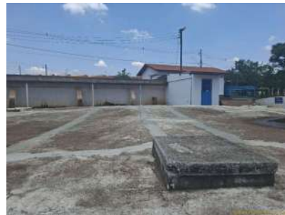
Foto 4 - Tampa de inspeção
