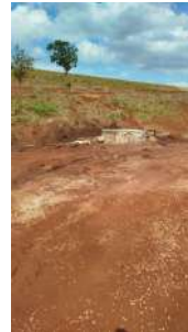
Foto 2 - Comprovação da vedação da caixa de inspeção
