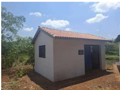
Foto 1 - Vista da externa da EEAB Schiavon B
