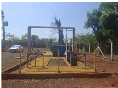
Foto 1 - Vista interna da EEEB Final
