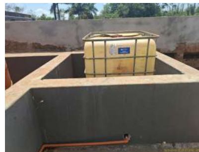
Foto 10 - Armazenamento de ácido fluossilícico
