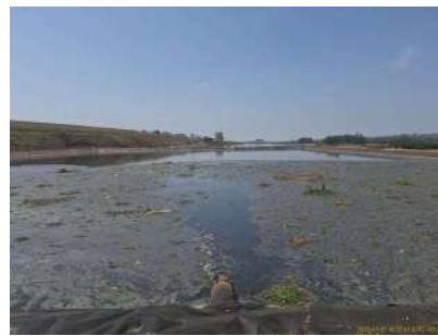
Foto 4 - Vista frontal da lagoa anaeróbia
