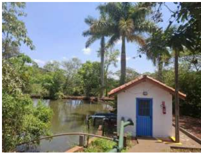
Foto 1 - Vista externa a EEAB Schiavon - A
