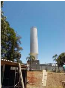
Foto 1 - Vista geral do reservatório.
