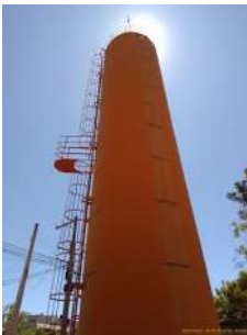
Foto 3 - Escada de acesso ao topo e fiação do para-raio.
