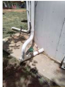
Foto 6 - Saída do tubo extravasor.
