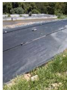
Foto 10 - "Bag" para secagem de lodo.
