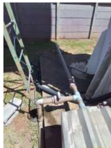
Foto 4 - Detalhe da tubulação de ligação entre o reservatório e a motobomba de recalque.
