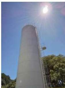
Foto 8 - Topo do reservatório.
