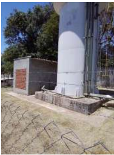
Foto 5 - Base do reservatório.
