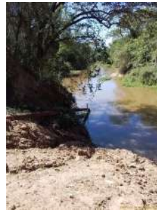
Foto 6 - Tubulação e ponto de captação original.
