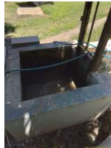
Foto 4 - Passagem do esgoto bruto para as lagoas.
