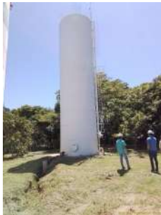
Foto 2 - Vista geral do reservatório
