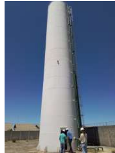
Foto 2 - Vista geral do reservatório.
