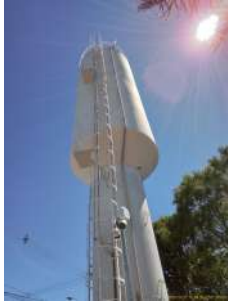
Foto 4 - Escada de acesso ao topo do reservatório e sistema de para-raios (fiação e haste).
