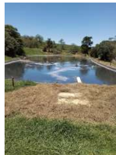
Foto 6 - Lagoa aerada. Com destaque para aeradores flutuantes.
