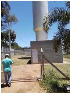
Foto 2 - Entrada do reservatório.
