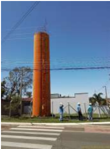
Foto 1 - Vista geral do reservatório.
