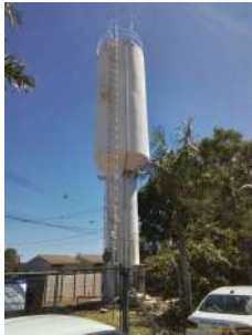
Foto 2 - Vista geral do reservatório.
