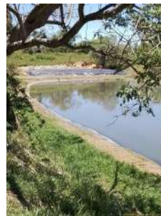
Foto 8 - Lagoa de maturação e "bags" para secagem de lodo.
