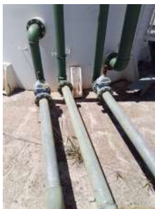
Foto 4 - Imagem detalhada das tubulações.
