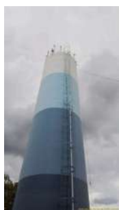
Foto 3 - Escada para manutenção.
