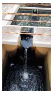
Foto 6 - Vertedor dos decantadores
