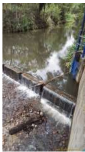
Foto 13 - Barragem da captação
