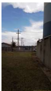
Foto 1 - Portão de acesso.
