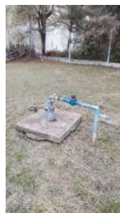
Foto 6 - Visão geral do poço.
