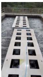
Foto 24 - Aplicação de antiespumante pelas mangueiras e aspersores.
