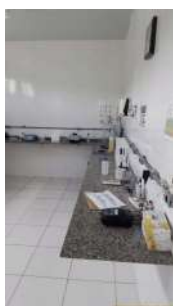
Foto 1 - Laboratório da ETE
