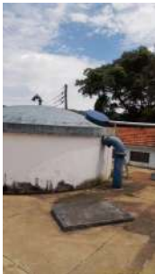
Foto 1 - Entrada do reservatório
