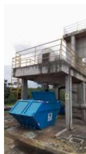
Foto 7 - Peneiramento e caçamba para remoção de detritos
