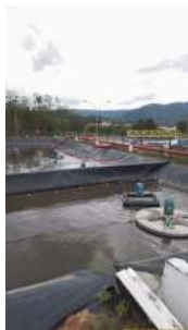
Foto 17 - Lagoa de aeração
