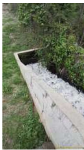
Foto 35 - Lançamento do efluente
