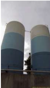
Foto 4 - Conexão entre os reservatórios.
