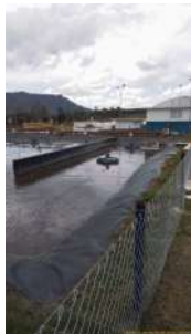
Foto 11 - Lagoa de aeração
