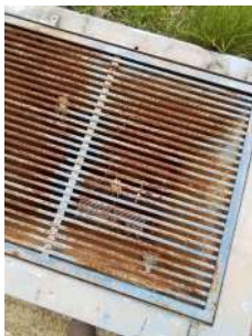
Foto 21 - Medidor de vazão inoperante e aplicação de pré cloração
