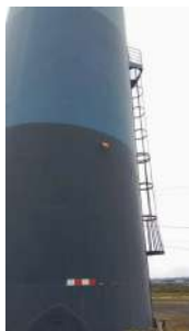
Foto 1 - Medidor de nível por contrapeso.
