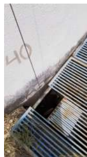
Foto 2 - Medidor de nível por contrapeso
