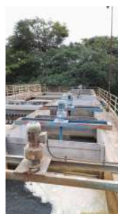
Foto 2 - Floculadores com misturadores mecanizados
