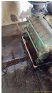
Foto 1 - Tubulação para drenagem
