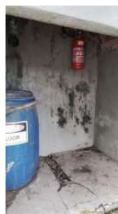
Foto 4 - Flúor e extintor.
