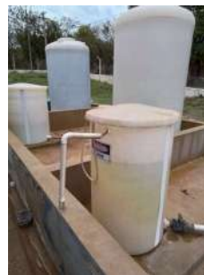
Foto 14 - Armazenamento de flúor
