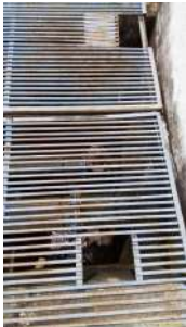
Foto 3 - Tubulação de saída
