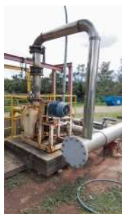
Foto 5 - Bomba para encaminhar o efluente ao peneiramento
