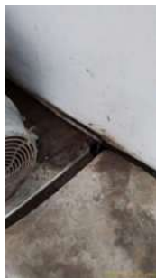
Foto 3 - Canaleta e tubulação para drenar água
