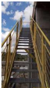
Foto 18 - Escada para acessar os reatores
