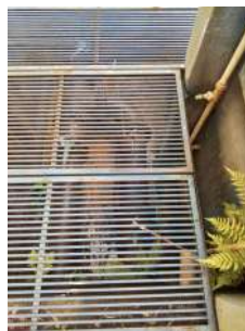
Foto 31 - Tubulação na qual ocorre pré cloração
