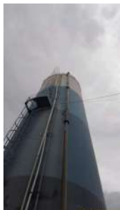
Foto 7 - Escada, tubulação de alimentação e extravasor.
