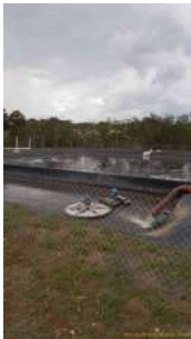
Foto 2 - Lagoa de aeração
