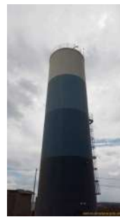
Foto 2 - Visão geral do reservatório.
