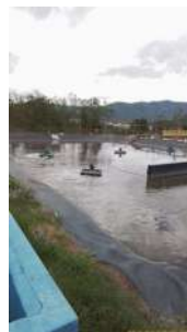
Foto 10 - Visão geral da lagoa de aeração
