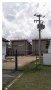
Foto 2 - Visão geral dos reatores
