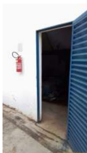
Foto 1 - Entrada da elevatória
