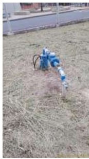
Foto 1 - Visão geral do poço.
