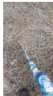
Foto 4 - Torneira para coleta de água bruta.
