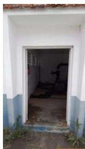
Foto 1 - Entrada da elevatória
