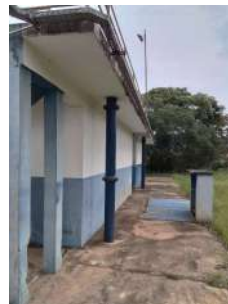
Foto 22 - Tubulação de entrada de água bruta
