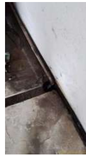
Foto 2 - Canaletas para drenar água de lubrificação das gaxetas
