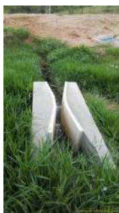
Foto 25 - Calha parshall antes do lançamento
