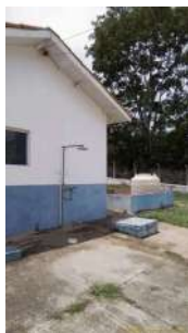
Foto 34 - Chuveiro de emergência próximo aos produtos químicos
