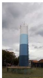
Foto 2 - Visão geral do reservatório.
