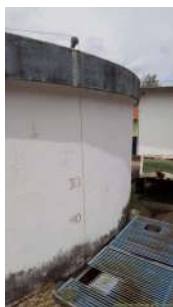
Foto 1 - Marcas para monitoramento do nível
