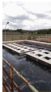
Foto 19 - Visão dos reatores
