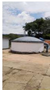
Foto 8 - Visão geral do reservatório
