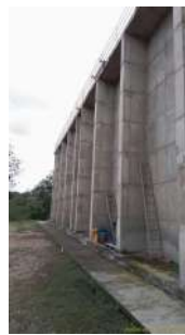
Foto 36 - Visão de um dos reatores.
