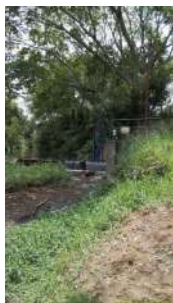
Foto 11 - Barragem da captação
