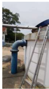
Foto 6 - Alimentação do reservatório
