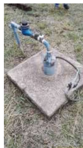
Foto 10 - Laje de concreto do poço.
