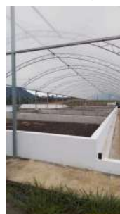
Foto 3 - Estufas para secagem de lodo biológico, proveniente do decantador secundário
