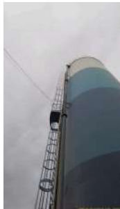
Foto 3 - Escada para manutenção.
