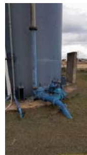
Foto 6 - Alimentação do reservatório
