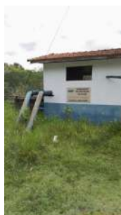
Foto 1 - Casa de bombas da captação
