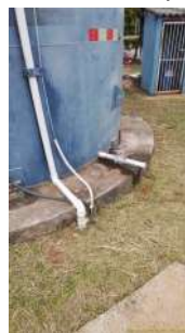
Foto 6 - Alimentação do reservatório
