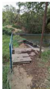
Foto 12 - Barragem da captação
