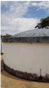
Foto 2 - Visão do reservatório
