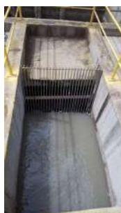
Foto 3 - Gradeamento na entrada do efluente
