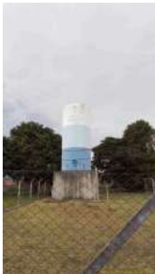
Foto 2 - Visão geral dos reservatórios.
