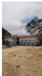
Foto 35 - Visão geral da ETA
