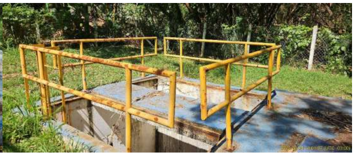
Foto 4 - Guarda-corpo corroído
