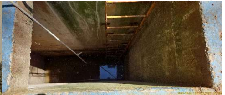
Foto 4 - Poço de gradeamento
