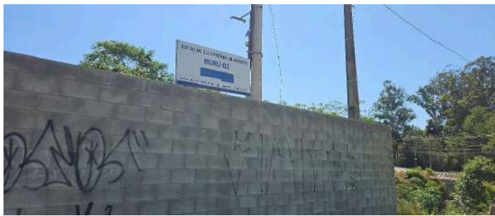
Foto 1 - Placa de identificação da elevatória
