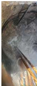
Foto 7 - Chegada do efluente na elevatória
