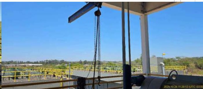
Foto 41 - Içamento para manutenções
