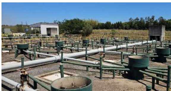
Foto 21 - Reator UASB 4
