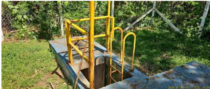
Foto 5 - Guarda-corpo corroído
