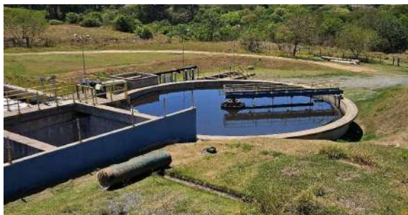
Foto 23 - Decantador pós aeração
