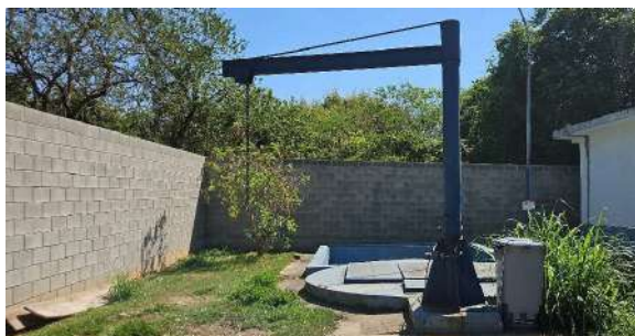
Foto 1 - Içamento para manutenções
