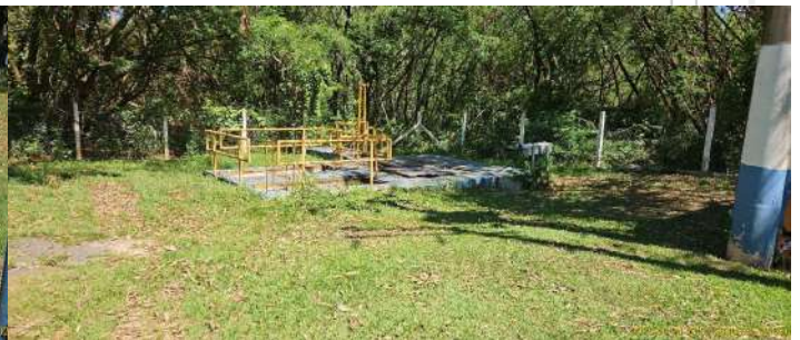
Foto 2 - Vista geral da unidade
