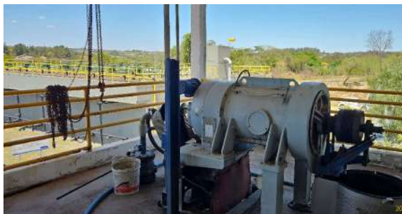
Foto 40 - Centrifuga de lodo
