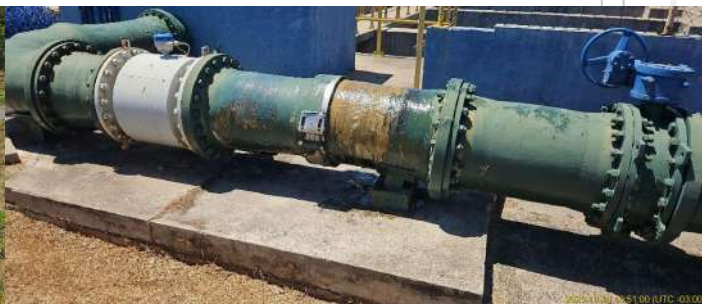
Foto 24 - Vazamento resolvido na tubulação dos tanques de aeração de chegada do efluente no tanque de aeração
