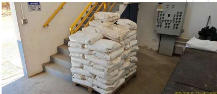
Foto 37 - Armazenamento de polímero para adensamento de lodo.
