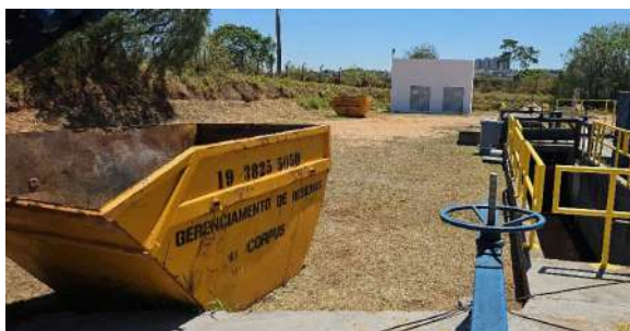
Foto 9 - Vista geral do tratamento preliminar
