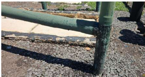
Foto 3 - vazamento na tubulação do reator 4
