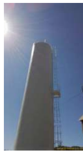
Foto 2 - Escada e Guarda-corpo
