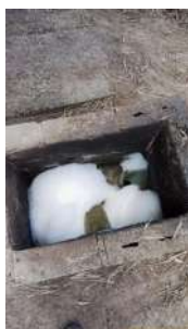
Foto 49 - Espuma acumulada na saída das chicanas, antes do lançamento final.
