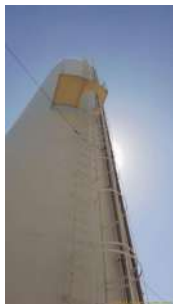
Foto 7 - Escada e proteção
