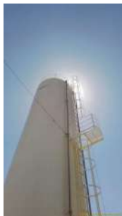
Foto 3 - Reservatório elevado com escada, proteção e Guarda-corpo
