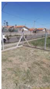
Foto 1 - Cercamento da área.
