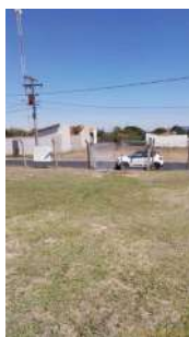
Foto 11 - Portão de acesso
