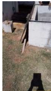
Foto 4 - Tubulação que encaminha água do poço para o reservatório 8.
