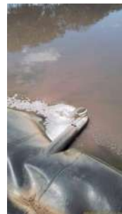
Foto 27 - Tubulação de entrada de efluente na lagoa facultativa.
