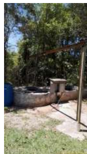
Foto 15 - Visão geral da elevatória
