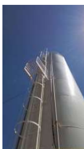
Foto 7 - Escada para manutenção
