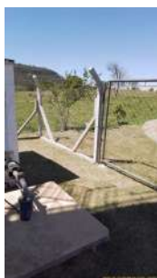
Foto 1 - Portão de acesso.
