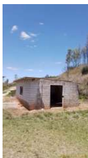
Foto 51 - Construção que abriga o hipoclorito de sódio.
