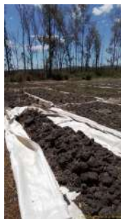
Foto 33 - Bags com lodo ressecado, removido das lagoas.
