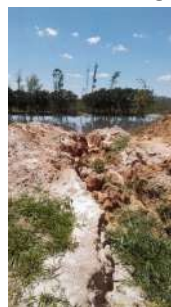
Foto 16 - Obra para bypass para lagoa facultativa
