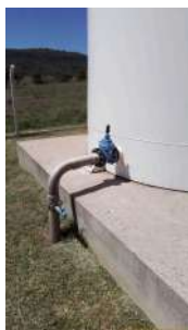
Foto 5 - Saída do reservatório
