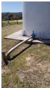
Foto 3 - Saída do reservatório
