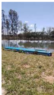
Foto 17 - Material para obra do bypass para lagoa facultativa.
