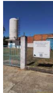
Foto 8 - Visão geral do local. Reservatórios estão desativados.
