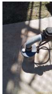
Foto 2 - Tubo para medição no nível do poço
