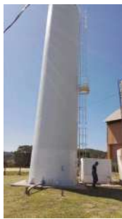
Foto 1 - Reservatório do poço 1
