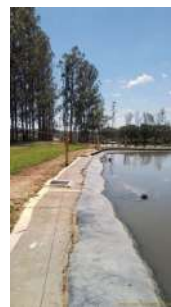
Foto 10 - Saídas de efluente da lagoa anaeróbia
