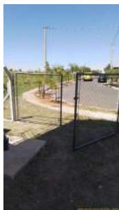
Foto 9 - Portão de acesso
