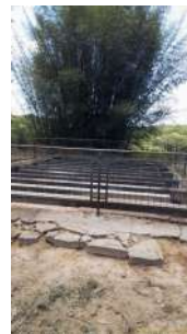
Foto 45 - Chicanas do tanque de contato
