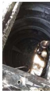
Foto 11 - Entrada de efluente no poço de sucção
