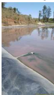
Foto 36 - Saída lagoa facultativa
