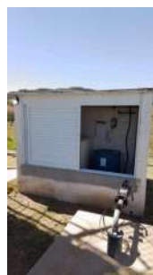
Foto 4 - Abrigo de produtos químicos
