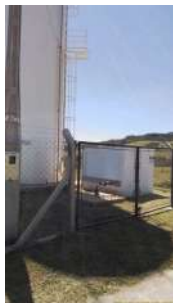
Foto 13 - Portão de acesso
