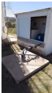
Foto 1 - Poço e laje de proteção
