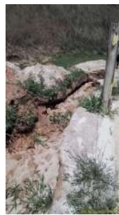
Foto 14 - Obra para instalação da tubulação do bypass entre a caixa de areia e a lagoa facultativa, desviando o efluente da lagoa anaeróbia.
