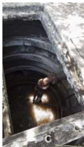
Foto 7 - Poço de sucção com uma bomba em operação.
