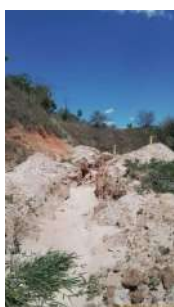
Foto 19 - Obra para bypass para lagoa facultativa
