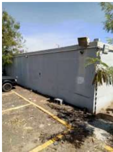
Foto 4 - Lateral do reservatório.
