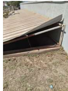
Foto 2 - Caixa de alvenaria na lateral do reservatório.
