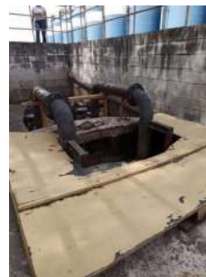
Foto 2 - Detalhe da tampa do poço da elevatória.
