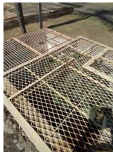
Foto 6 - Gradil na caixa da tubulação de chegada do reservatório.
