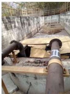
Foto 1 - Tampa do poço da elevatória de esgoto.
