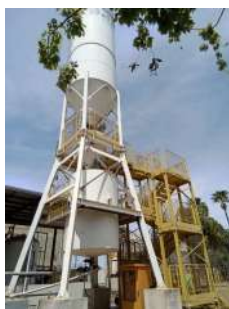
Foto 63 - Silo de carvão.
