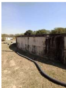
Foto 7 - Parede lateral do reservatório.
