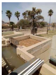
Foto 34 - Calha onde há a separação para os dois tratamentos.
