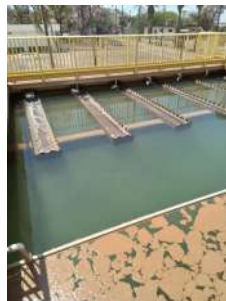
Foto 37 - Vertedores dos decantadores do tratamento convencional.
