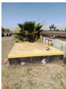
Foto 5 - Caixa com válvula para manobra.
