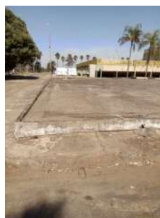
Foto 10 - Laje do reservatório.
