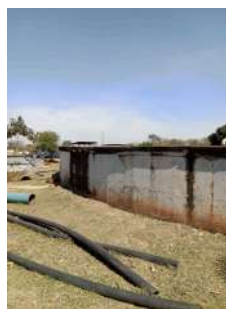
Foto 6 - Lateral do reservatório.
