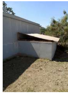
Foto 8 - Vista da segunda caixa submersa.
