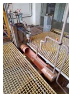
Foto 24 - Dosagem de PAC.
