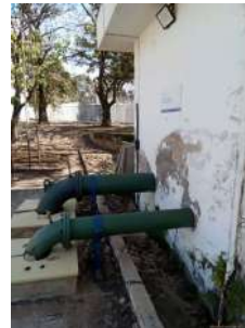
Foto 6 - Tubulação de sucção.
