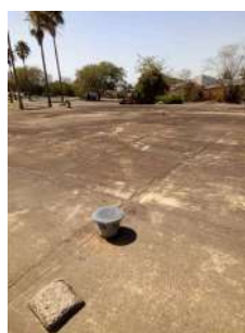
Foto 10 - Laje do reservatório.
