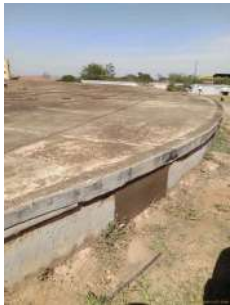
Foto 2 - Lateral do reservatório com a placa.
