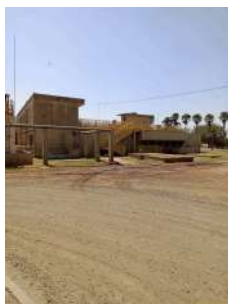
Foto 1 - Vista do sistema de tratamento da ETA.
