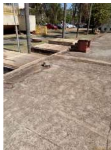
Foto 8 - Vista das caixas com as tubulações de entrada.
