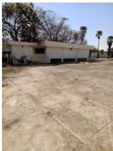
Foto 5 - Laje do reservatório e as duas EEAT ao fundo.
