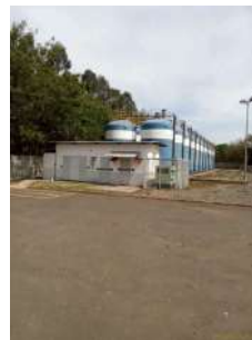
Foto 2 - Vista do tratamento.
