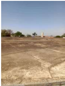
Foto 1 - Vista da cobertura do reservatório.
