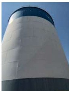
Foto 9 - Vista do topo do reservatório.
