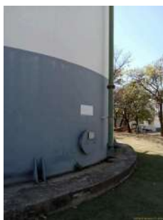
Foto 7 - Lateral do reservatório.
