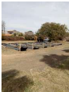
Foto 59 - Bags para desidratação do lodo.
