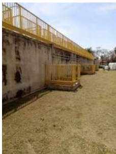
Foto 45 - Parede na parte traseira da ETA.
