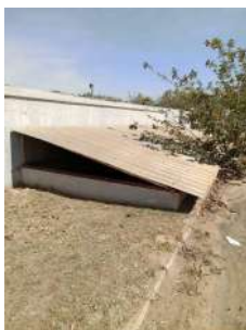
Foto 5 - Vista da primeira caixa submersa.
