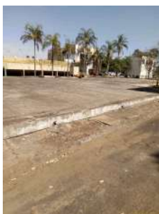
Foto 9 - Vista do reservatório.
