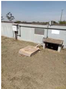
Foto 1 - Vista frontal do reservatório.
