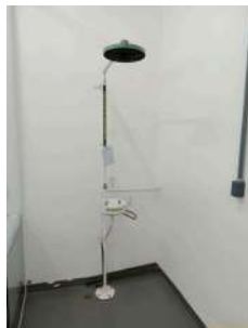
Foto 9 - Chuveiro de emergência do laboratório.
