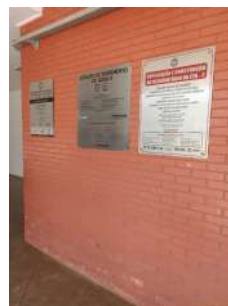
Foto 4 - Placas de identificação da ETA.
