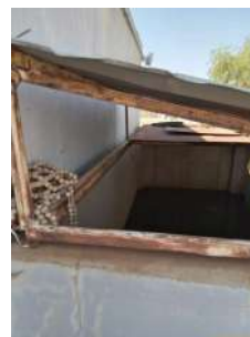
Foto 6 - Segunda caixa de alvenaria.
