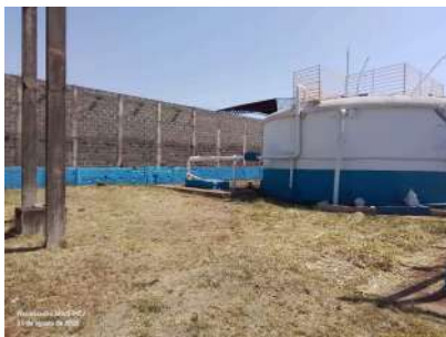
Foto 3 - Vista do poço ao fundo.
