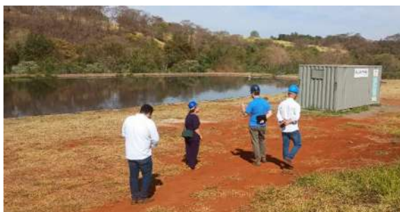
Foto 19 - Vista geral da lagoa 1 da linha 2 de tratamento e, ao lado, abrigo da empresa responsável pela bioaugmentação de microorganismos
