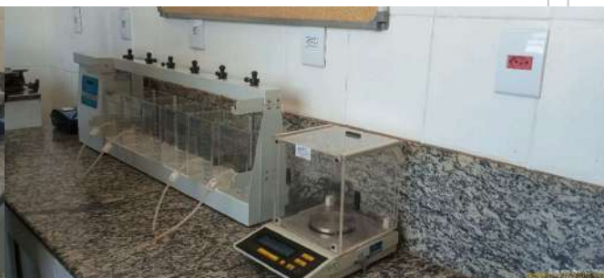
Foto 21 - Bancada do laboratório da ETA.
