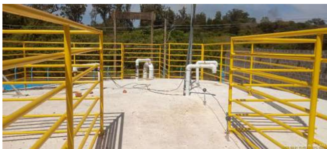
Foto 8 - Vista da cobertura do reservatório e tubos de ventilação.
