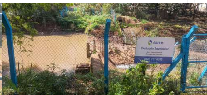
Foto 4 - Identificação do local e cercamento do acesso principal.
