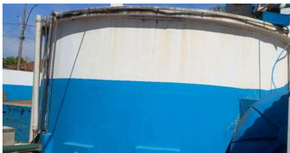
Foto 3 - Vista geral do reservatório.
