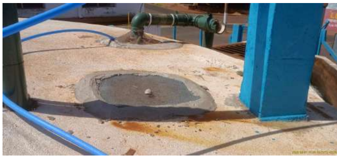
Foto 1 - Vão horizontal coberto com tela mosquiteira.
