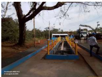
Foto 1 - Vista do canal de chegada da EEE.
