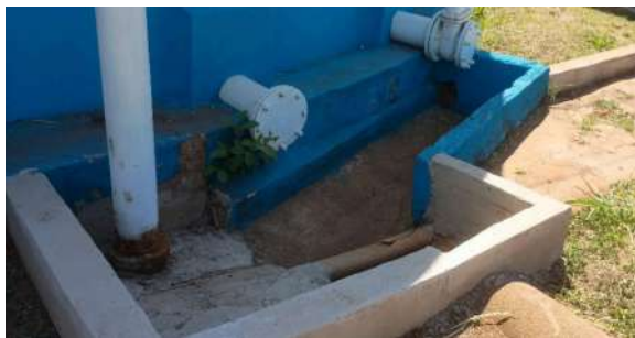
Foto 10 - Tubo extravasor e de descarga do reservatório.
