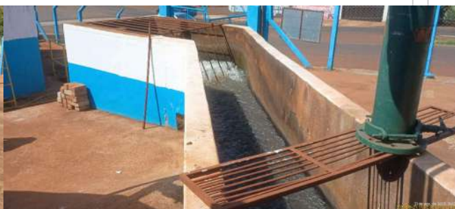
Foto 12 - Canal de direcionamento para a EEAB.
