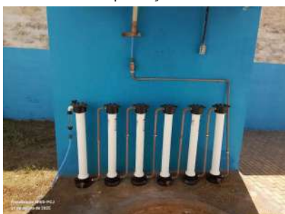
Foto 9 - Sistema de dosagem química com pastilhas.
