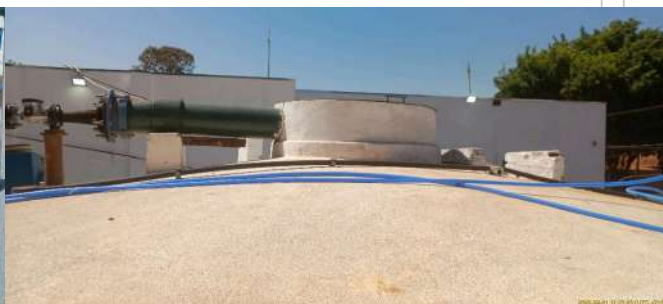
Foto 4 - Vista da cobertura do reservatório.
