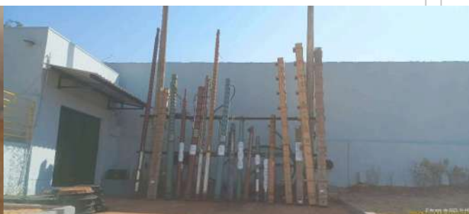
Foto 9 - Estoque de conjuntos motobomba reserva na ETA.
