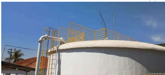
Foto 7 - Vista da parte superior do reservatório.
