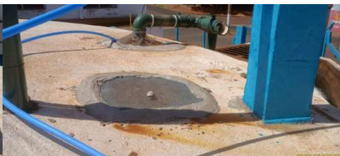
Foto 6 - Vista da cobertura do reservatório.
