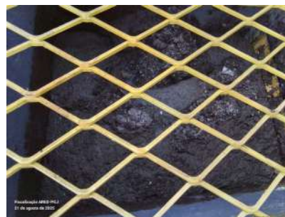
Foto 2 - Caixa de chegada. Material flutuante acumulado.
