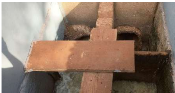
Foto 8 - Vista interna da caixa de distribuição da vazão de esgoto.
