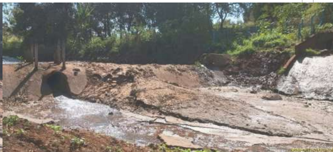
Foto 2 - Vista geral da área da captação.
