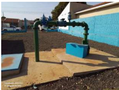
Foto 6 - Vista geral do poço e do cercamento.
