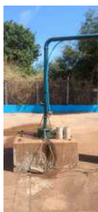
Foto 1 - Vista geral do poço.
