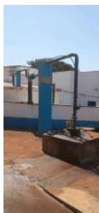
Foto 3 - Vista geral do poço e, ao fundo, do reservatório.
