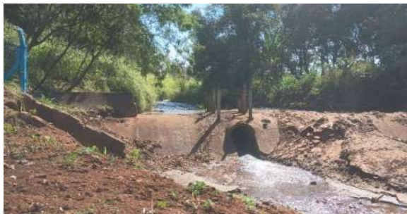
Foto 1 - Vista geral da área da captação.
