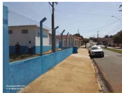
Foto 2 - Vista do cercamento.
