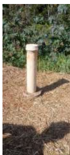
Foto 24 - Um dos poços piezométricos da lagoa facultativa da linha 2.
