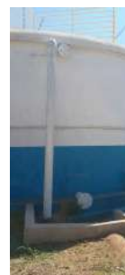
Foto 9 - Tubo extravasor e de descarga do reservatório.
