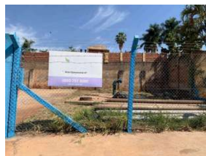
Foto 2 - Vista geral da área do poço P5.
