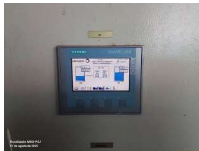
Foto 18 - Pannel de nível dos reservatórios abastecidos.
