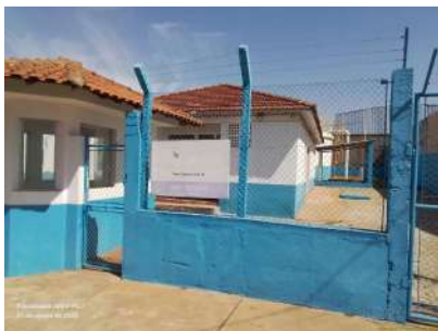
Foto 1 - Vista do acesso ao poço.
