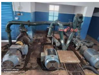
Foto 1 - Conjuntos 1 e 2 em operação (abastecendo áreas distintas) e uma ausente.
