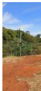
Foto 26 - Vista do visor da macromedicação da saída da ETE.
