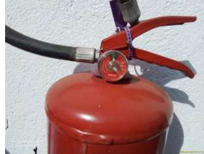
Foto 12 - Pressurização do extintor do acesso.
