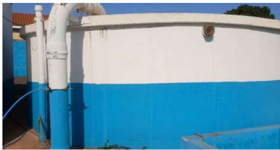
Foto 1 - Vista geral da lateral do reservatório.
