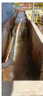
Foto 1 - Dosagem de sulfato de alumínio e cal na chegada da água bruta.
