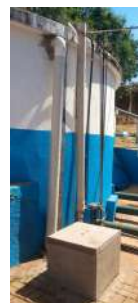
Foto 8 - Vista lateral do reservatório e do tubo extravasor.
