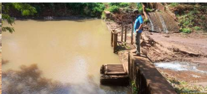
Foto 6 - Vista do barramento e do ponto de captação.
