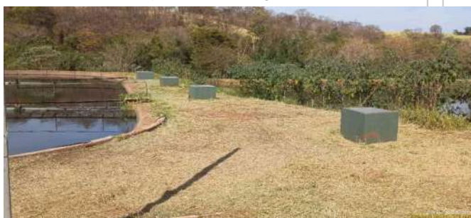
Foto 21 - Trecho final da lagoa 1 e caixas de passagem para a lagoa 2 da segunda linha (inferior).
