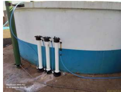
Foto 9 - Dosagem de cloro e flúor com pastilhas.
