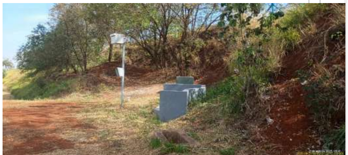
Foto 12 - Segunda chegada de esgoto (não passa pela elevatória) da ETE, com macromedidor.
