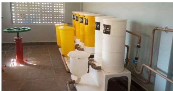
Foto 13 - Sistema de cloração e fluoretação.
