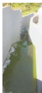
Foto 32 - Situação do efluente na saída do tratamento.
