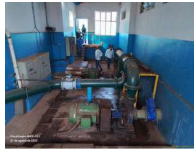
Foto 6 - Vista geral da EEAT.
