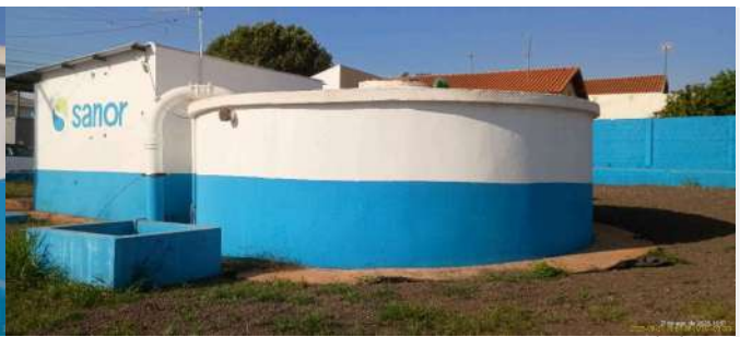
Foto 2 - Vista geral da lateral do reservatório e, ao fundo, da EEAT.
