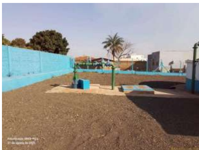
Foto 2 - Vista geral do poço e do cercamento.
