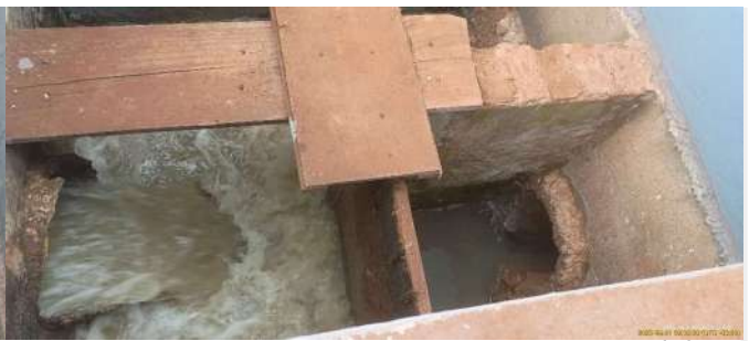
Foto 9 - Vista interna da caixa de distribuição da vazão de esgoto.
