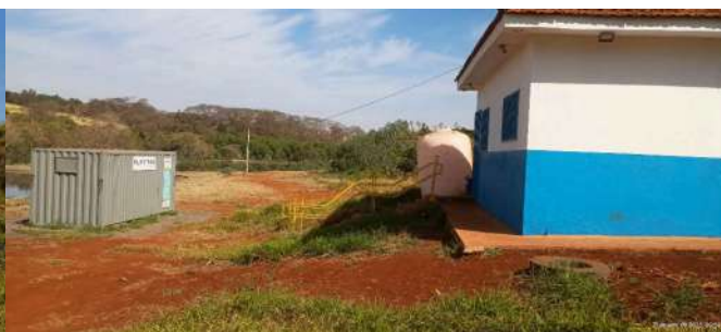
Foto 18 - Prédio operacional e abrigo da empresa responsável pela bioaugmentação de microorganismos na ETE, para aumento da eficiência no tratamento.
