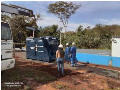
Foto 22 - Sistema de bombeamento alugado em processo de instalação.
