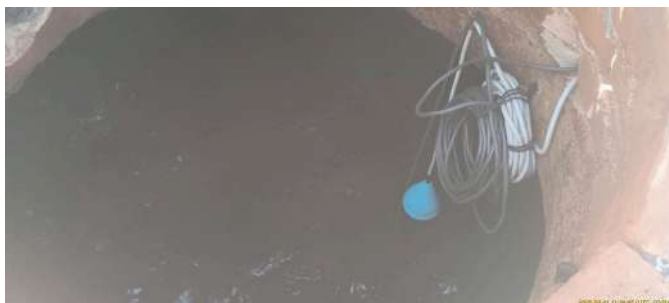
Foto 7 - Vista interna do reservatório.
