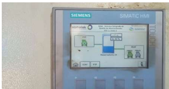
Foto 5 - Nível do reservatório R24.
