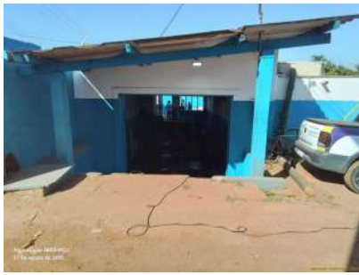
Foto 5 - Vista externa da EEAT.
