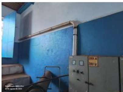
Foto 17 - Tubulação de cabos elétricos substituídos após o incêndio.
