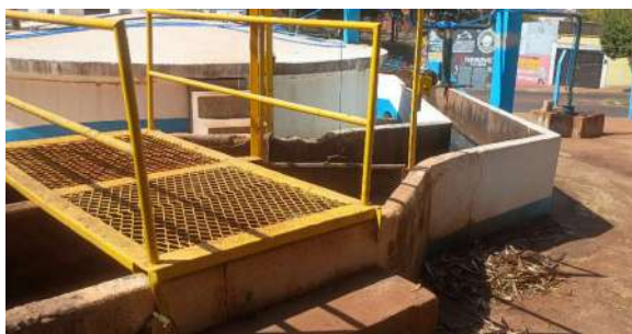
Foto 11 - Canal de direcionamento para a EEAB.
