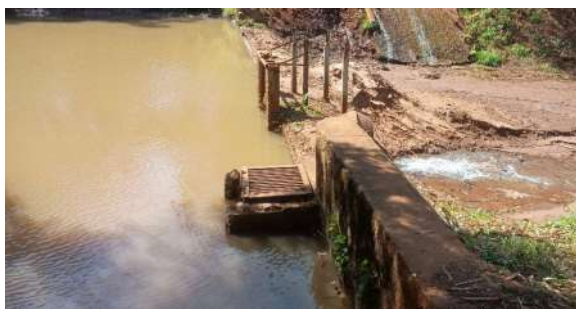
Foto 7 - Vista do barramento e do ponto de captação.
