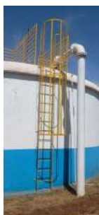
Foto 5 - Escada de acesso à cobertura do reservatório.
