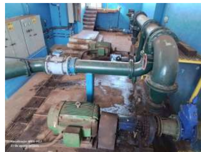
Foto 10 - Vista geral da EEAT.
