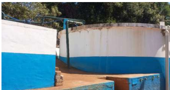
Foto 1 - Vista geral do reservatório.
