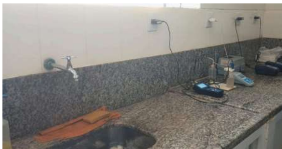
Foto 20 - Bancada do laboratório da ETA.
