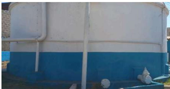
Foto 3 - Vista geral do reservatório.
