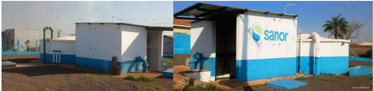
Foto 3 - Vista da EEAT e do reservatório apoiado ao lado.
