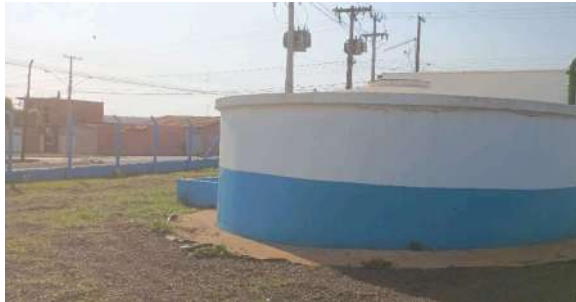
Foto 3 - Vista geral da lateral do reservatório.
