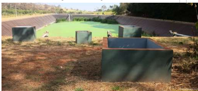
Foto 7 - Caixa de chegada do esgoto na primeira linha de lagoas e divisão das vazões entre as duas linhas.
