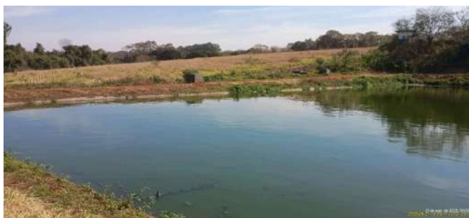
Foto 25 - Vista geral da lagoa 2 da segunda linha.
