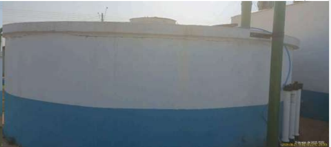
Foto 4 - Vista geral da lateral do reservatório.
