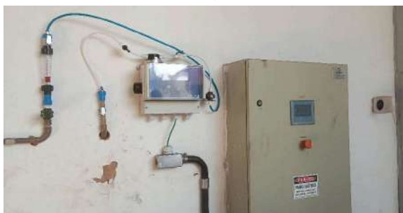
Foto 9 - Turbidímetro instalado.
