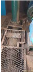
Foto 3 - Vala ao lado do equipamento, por onde passa tubulação de recalque.
