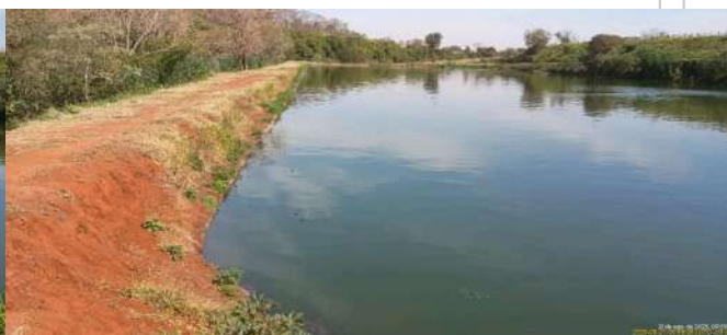
Foto 23 - Vista geral da lagoa 2 da segunda linha.
