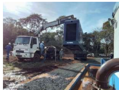
Foto 2 - Sistema reserva de recalque em instalação.
