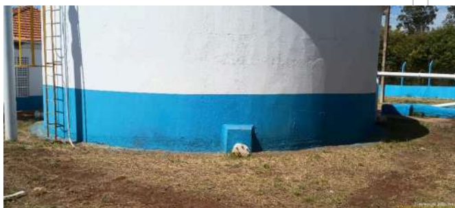
Foto 6 - Vista da lateral do reservatório.
