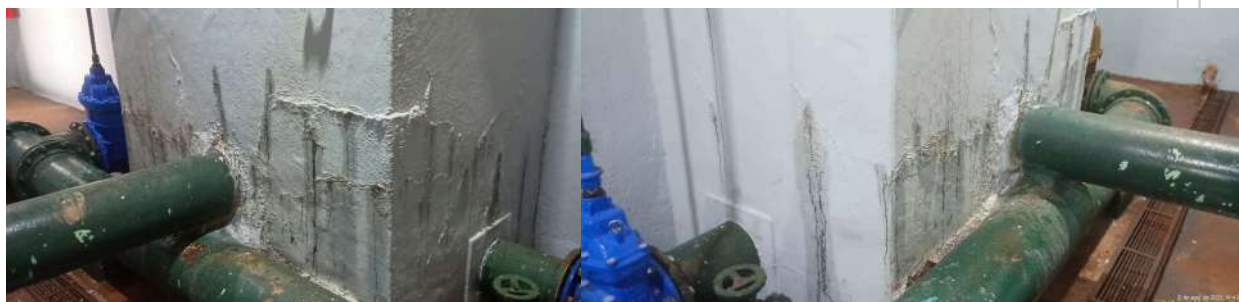
Foto 1 - Tanque da saída dos filtros 3 e 4.
