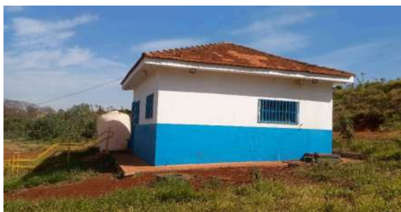
Foto 17 - Prédio operacional entre as duas linhas de lagoas. Ainda sem uso pelo prestador.
