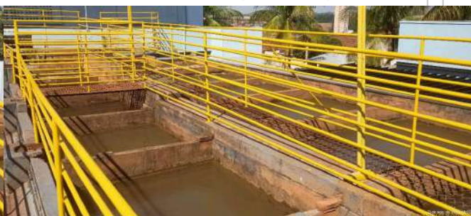
Foto 5 - Floculadores (hidráulicos).
