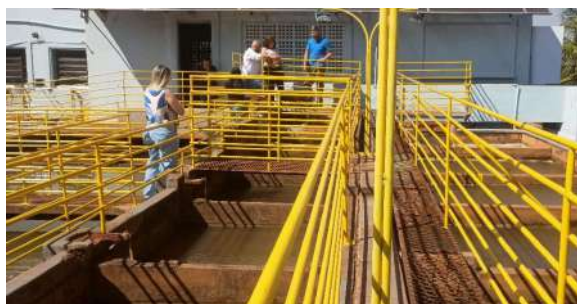
Foto 4 - Floculadores (hidráulicos).
