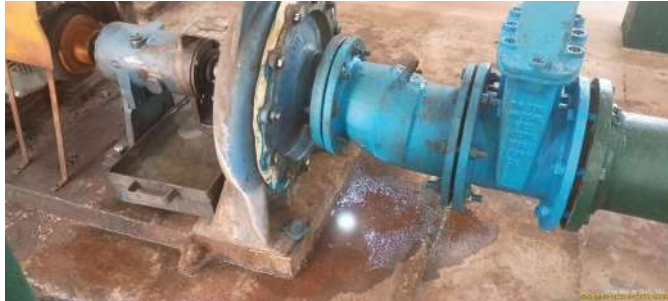
Foto 1 - Recipiente colocado abaixo do eixo.
