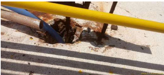
Foto 4 - Abertura para entrada do tubo azul.
