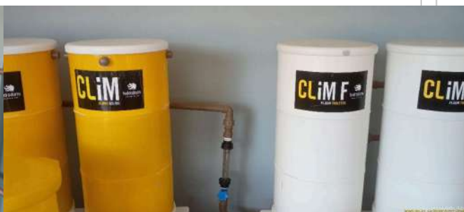
Foto 14 - Sistema de cloração e fluoretação.
