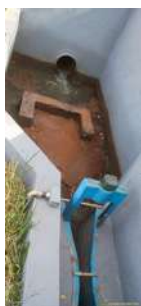
Foto 1 - Situação do canal de chegada do esgoto bruto na chegada 2, antes da Calha Parshall.
