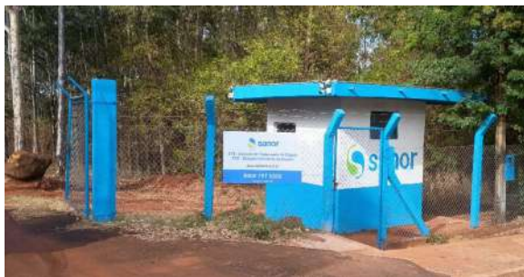
Foto 1 - Entrada da ETE.
