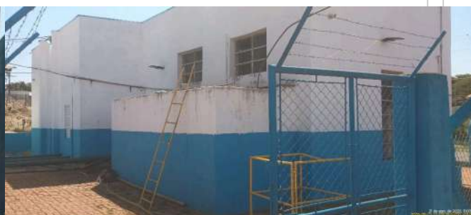
Foto 2 - Estação elevatória de água trata e de água bruta (ao fundo) e tanque de sucção da EEAB.
