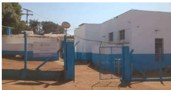
Foto 3 - Vista geral dos abrigos de bomba da elevatória de água bruta e de água tratada 1.
