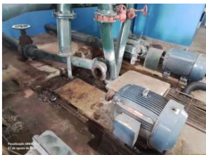
Foto 6 - Equipamento central em manutenção.
