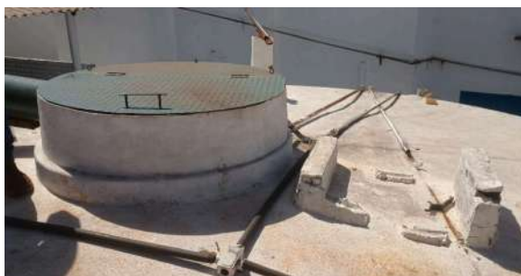
Foto 5 - Vista da cobertura do reservatório.
