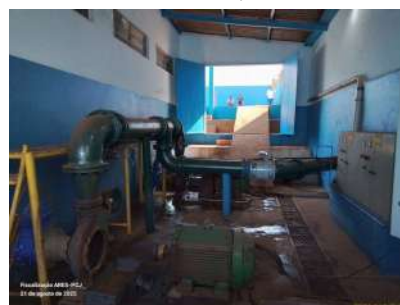
Foto 22 - Vista geral da EEAT.
