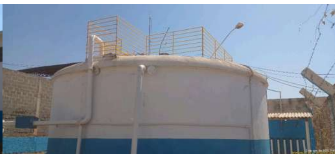
Foto 2 - Vista geral do reservatório.
