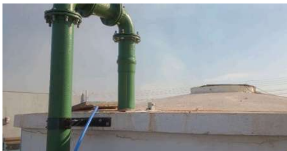
Foto 1 - Vista da cobertura do reservatório com o tubo azul de dosagem de produtos químicos.
