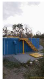
Foto 2 - Escada de acesso ao topo.
