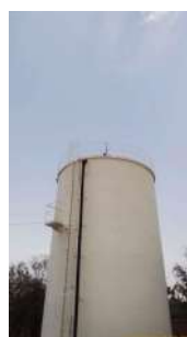
Foto 8 - Vista do topo do reservatório.
