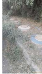
Foto 2 - Poços de vista e sucção.
