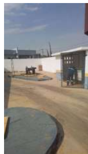
Foto 12 - Vista geral do interior da EEE.
