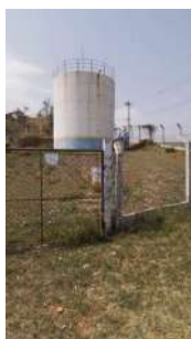
Foto 1 - Vista geral da área do reservatório.
