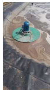
Foto 26 - Flutuante com bomba de aeração reserva.
