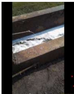
Foto 27 - Local de adição de antiespumante após decantação.
