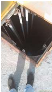
Foto 4 - Conjunto de moto bombas.
