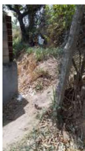
Foto 3 - Acesso usado por diferentes pessoas para o interior da área do reservatório.
