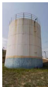
Foto 2 - Vista geral do reservatório
