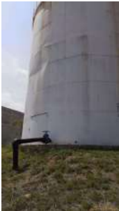
Foto 2 - Vista detalhada do reservatório, com destaque para a tubulação de entrada/saída de água.
