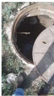
Foto 1 - Poço de sucção.
