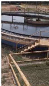
Foto 23 - Área de acesso aos decantadores.
