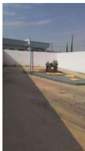
Foto 11 - Vista geral do interior da EEE.
