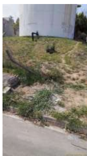
Foto 1 - A cerca encontra-se derrubada, permitindo o livre acesso à área do reservatório.
