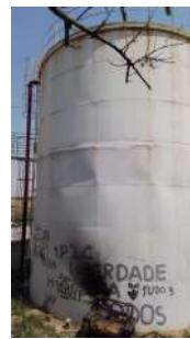
Foto 4 - Vista traseira do reservatório.
