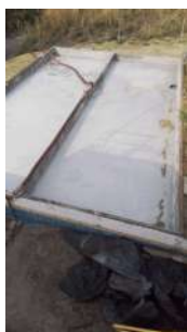
Foto 17 - Espaço reservado para bags de remoção de líquidos do lodo. Atualmente o lodo esta sendo acumulado.
