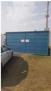
Foto 2 - Vista geral da EEE.
