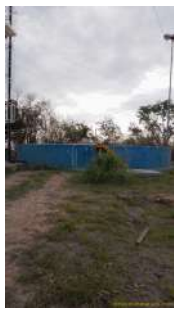
Foto 1 - Vista geral do reservatório.
