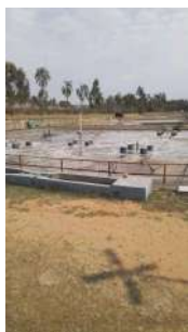
Foto 16 - Lagoas de aeração mecânica.
