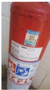
Foto 8 - Detalhe do prazo de validade do extintor, que encontra-se dentro do período vigente, conforme especificado na etiqueta.
