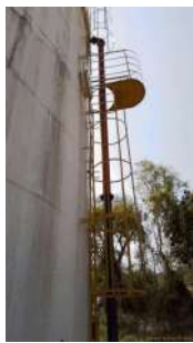
Foto 3 - Escada de acesso ao topo e fiação do para-raio.
