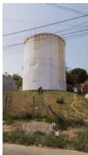
Foto 8 - Vista do reservatório.
