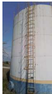
Foto 6 - Escada de acesso ao topo do reservatório.
