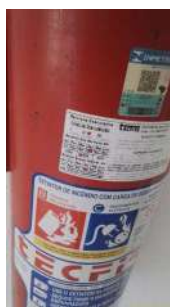
Foto 11 - Detalhe da etiqueta contendo a data de validade do extintor, que se encontra dentro do prazo de vigência.
