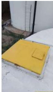
Foto 3 - Tampa de inspeção.
