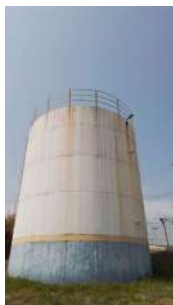
Foto 7 - Para-raios localizado no topo do reservatório.
