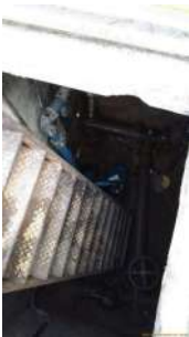
Foto 2 - Escada de acesso às motobombas.
