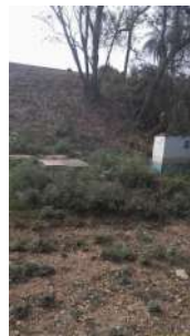
Foto 4 - Visão geral da elevatória.
