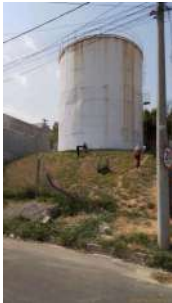
Foto 1 - Vista geral do reservatório.
