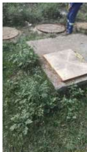
Foto 3 - Poços da elevatória.
