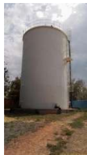
Foto 4 - Vista geral do reservatório.
