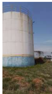
Foto 8 - Área em volta do reservatório.
