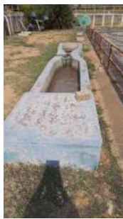
Foto 21 - Vista geral da calha Parshall.
