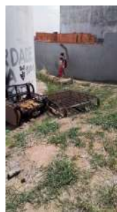
Foto 2 - Na parte traseira do reservatório, devido à falta de cercamento, pessoas estão utilizando a área, inclusive como passagem.
