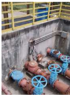
Foto 1 - Cabeamento exposto
