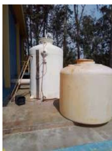
Foto 25 - Tanques de produtos químicos (inutilizados)
