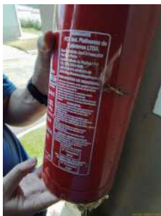
Foto 1 - Extintor de incêndio vencido em 2024
