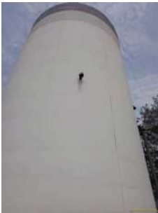
Foto 4 - Tubo extravasador do reservatório
