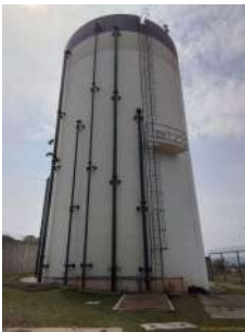
Foto 2 - Lateral do reservatório
