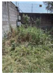
Foto 2 - Área carece de roçagem e limpeza do terreno
