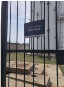
Foto 1 - Placa de identificação do reservatório
