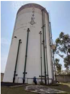
Foto 2 - Lateral do reservatório
