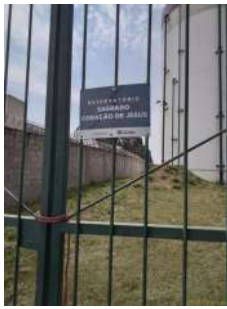
Foto 1 - Placa de identificação do reservatório
