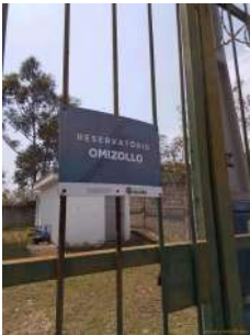
Foto 1 - Placa de identificação do reservatório
