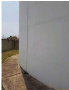
Foto 7 - Condutor de descida
