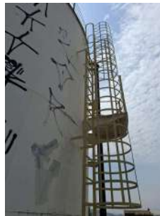
Foto 2 - Escada e guarda-corpo
