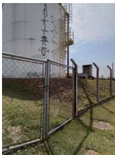
Foto 1 - Reservatório sem identificação
