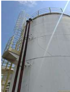
Foto 3 - Lateral do reservatório
