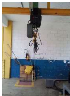
Foto 29 - Içamento para manutenção
