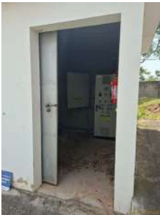
Foto 1 - Entrada da elevatória
