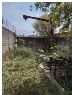
Foto 4 - Estrutura de içamento para manutenções
