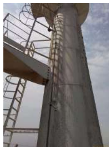
Foto 2 - Lateral do reservatório
