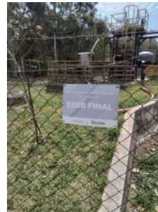
Foto 6 - Placa de identificação da elevatória
