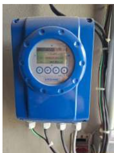
Foto 9 - Medidor de vazão
