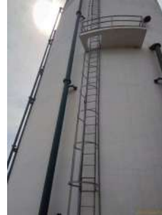
Foto 4 - Destaque para a escada de acesso
