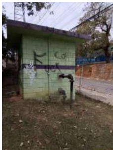
Foto 1 - Instalações do booster
