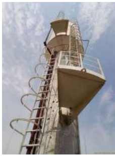
Foto 3 - Destaque para guarda corpo e escada de acesso
