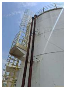
Foto 6 - Lateral do reservatório
