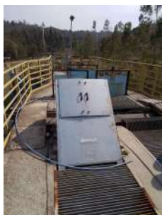
Foto 3 - Entrada do efluente
