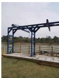
Foto 5 - Estrutura de içamento
