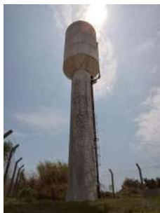
Foto 1 - Vista geral do reservatório
