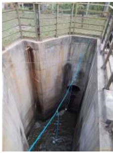
Foto 1 - Chegada do esgoto na ETE
