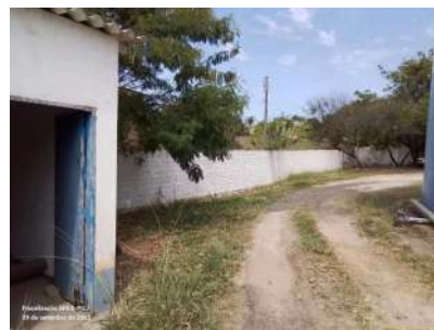
Foto 2 - Cercamento com muro na área onde está localizada a EEA.
