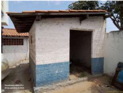
Foto 1 - Vista externa do abrigo onde está a EEA.
