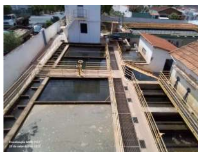
Foto 8 - Vista geral da unidade convencional.
