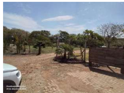
Foto 2 - Entrada da área onde se localiza a captação. Ausência de identificação da unidade.
