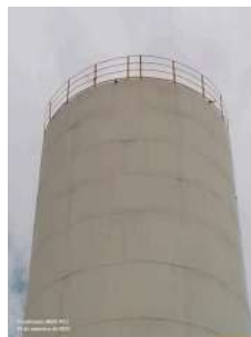
Foto 5 - Guarda corpo no topo do reservatório.
