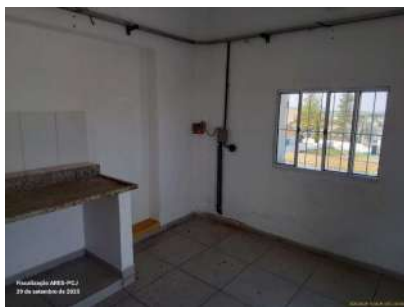
Foto 19 - Vista geral de local sendo reformado para novo laboratório da ETA.
