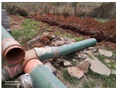
Foto 12 - Bypass desviando o efluente tratado do tanque de contato (em manutenção).
