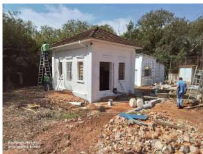
Foto 5 - Vista geral da casa de bombas da captação. No momento, está sob reforma.
