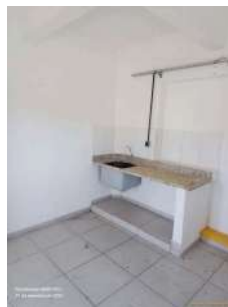
Foto 18 - Vista geral de local sendo reformado para novo laboratório da ETA.
