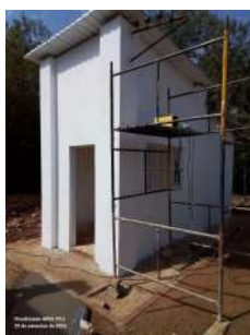
Foto 10 - Abrigo para operador da captação, localizado ao lado da casa de bombas. Encontra-se sob reforma.
