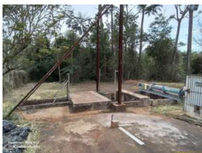
Foto 1 - Ausência de guarda corpo (ou grades de proteção) no poço da elevatória na entrada da ETE.
