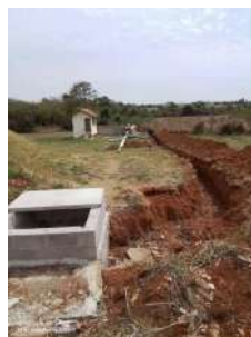
Foto 11 - Bypass desviando o efluente tratado do tanque de contato (em manutenção).
