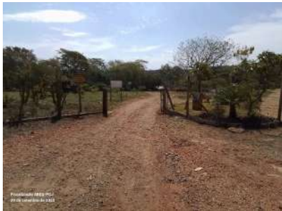
Foto 2 - Vista da entrada da área onde está localizada a captação, evidenciando cercamento da área.
