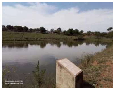
Foto 4 - Vista geral da represa. Detalhe exibe ausência de placa de identificação.
