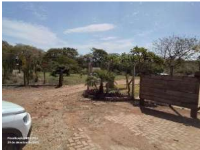
Foto 1 - Vista da entrada da área onde está localizada a captação, evidenciando cercamento da área.
