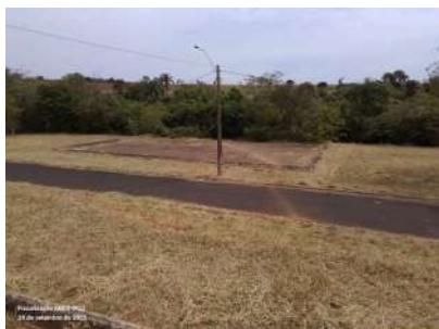
Foto 10 - Pátio para secagem de lodo.
