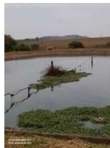
Foto 6 - Aerador quebrado e inoperante na lagoa aeróbica.
