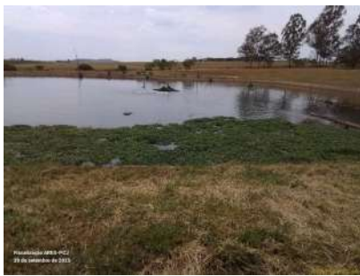
Foto 1 - Presença de macrófitas na lagoa aerada evidenciam necessidade de limpeza.
