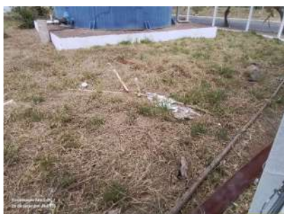
Foto 1 - Vidro quebrado ao lado do reservatório.
