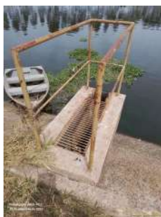
Foto 8 - Saída da lagoa aerada.
