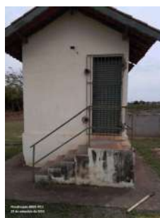
Foto 17 - Abrigo para armazenar produtos químicos para desinfecção, próximo à saída da ETE.
