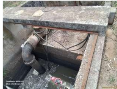
Foto 2 - Há somente uma bomba submersa na elevatória na entrada da ETE.
