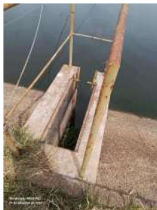
Foto 3 - Saída de uma das lagoas, sem a grade de segurança.
