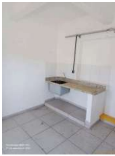
Foto 1 - Espaço sob reforma para instalação de novo laboratório.
