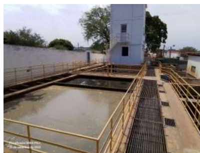
Foto 5 - Vista geral da unidade convencional.
