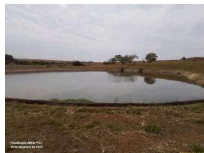
Foto 7 - Vista geral da primeira lagoa anaeróbia.
