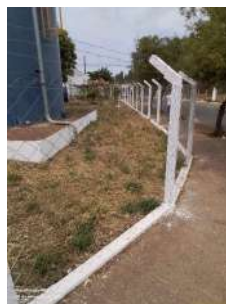
Foto 2 - Vista cercamento do local.
