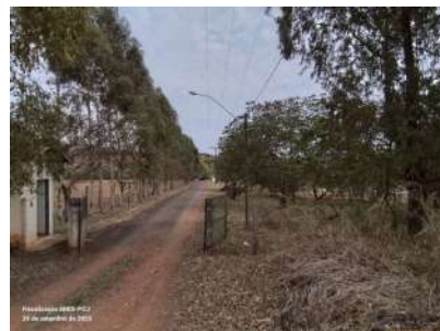
Foto 2 - Vista da entrada da ETE.
