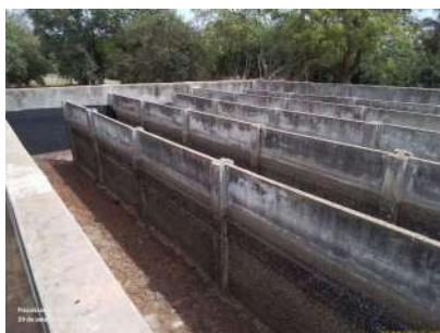
Foto 14 - Tanque de contato na saída da ETE, em manutenção para correção de vazamentos.
