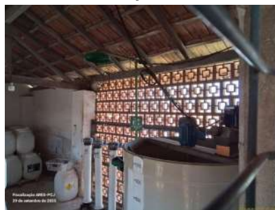
Foto 16 - Chuveiro de emergência presente na ETA.
