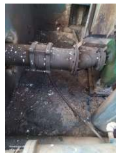
Foto 2 - Drenagem inadequada da água de lubrificação de gaxetas. Para alcançar a abertura
