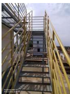
Foto 7 - Acesso para parte superior da unidade compacta. Escadas e guarda corpo em condições adequadas.
