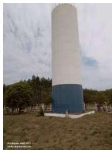
Foto 4 - Vista geral do reservatório.
