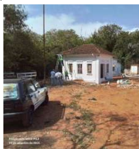
Foto 11 - Vista geral da casa de bombas da captação. No momento, está sob reforma.
