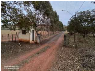
Foto 1 - Vista da entrada da ETE.
