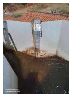
Foto 11 - Adição de PAC na entrada da unidade compacta.
