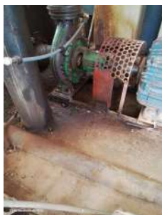
Foto 1 - Drenagem inadequada da água de lubrificação de gaxetas e acúmulo de água sob o
