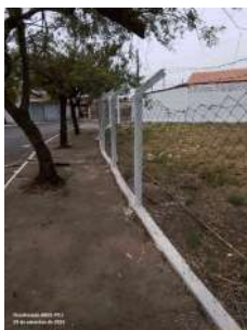
Foto 1 - Vista cercamento do local.
