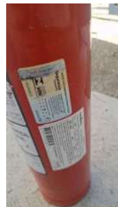
Foto 9 - Extintor com validade regular
