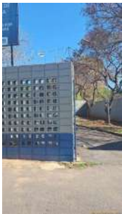
Foto 2 - Cercamento com muro e cerca concertina
