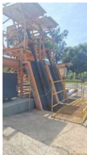
Foto 15 - Gradeamento mecanizado - Casa de bombas 2
