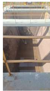
Foto 22 - Desarenador em manutenção - casa de bombas 4
