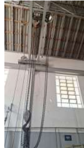
Foto 6 - Içamento manual - casa de bombas 1
