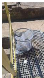
Foto 6 - Material raspado do gradeamento
