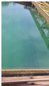
Foto 11 - Raspagem do fundo do decantador
