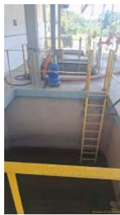
Foto 21 - Poços de sucção - casa de bombas 4
