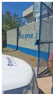
Foto 1 - Cercamento com muro e identificação do subsistema
