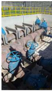
Foto 7 - Duas linhas de recalque
