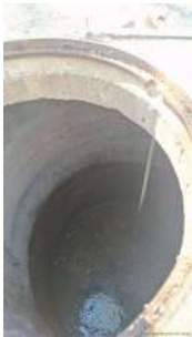
Foto 4 - Poço de chegada do esgoto e registro
