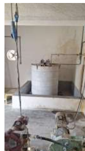
Foto 17 - Aplicação de ácido fluossilícico
