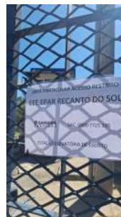
Foto 2 - Placa de identificação da estação elevatória de esgoto
