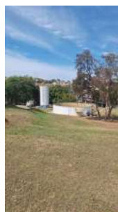
Foto 22 - Tanque de equalizacao do lodo e águas de lavagem
