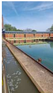
Foto 3 - Raspagem do decantador
