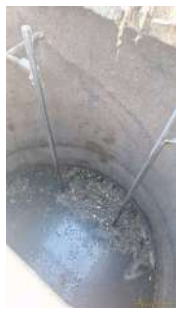
Foto 5 - Gradeamento com cesto
