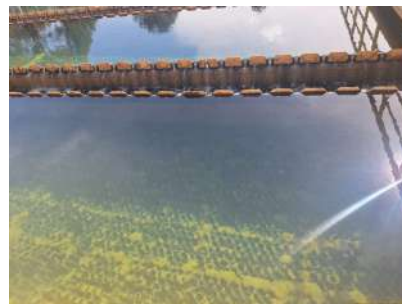
Foto 19 - Decantador lamelar ETA 4
