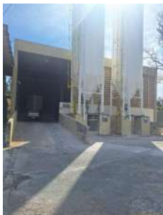
Foto 6 - Silos de cal virgem
