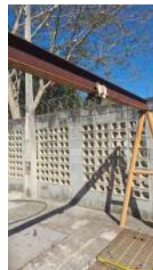
Foto 5 - Pórtico para acesso de manutenção
