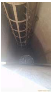
Foto 7 - Cesto com gradeamento
