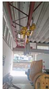
Foto 16 - Casa de bombas 3 acesso para manutenção
