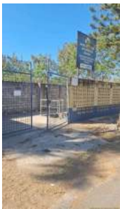
Foto 1 - Visão geral e cercamento
