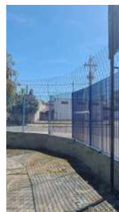
Foto 8 - Cercamento da área
