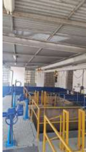
Foto 3 - Local para instalação de linha da vida
