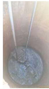
Foto 5 - Gradeamento com cesto
