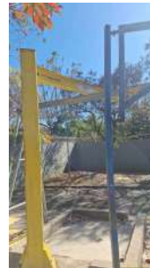
Foto 11 - Pórtico para içamento e manutenção
