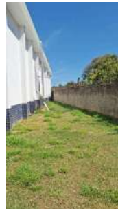
Foto 12 - Fundos da estação elevatória
