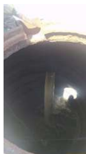
Foto 4 - Poço de chegada de esgoto
