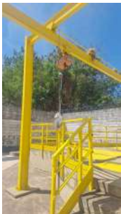
Foto 5 - Pórtico para acesso de manutenção
