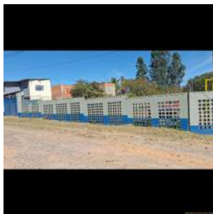
Foto 1 - Visão geral externa e cercamento de área
