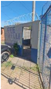
Foto 1 - Identificação e cercamento com concertina
