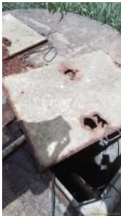
Foto 2 - Tampa que protege a moto bomba. A estrutura encontra-se oxidada e com buracos, podendo ocasionar acidentes.
