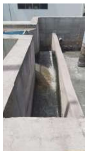
Foto 5 - Passagem de esgoto, com detalhe para calha parshall.
