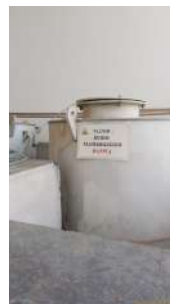
Foto 33 - Armazenamento e dosagem de flúor.
