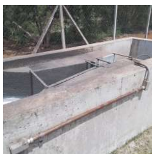
Foto 15 - Calha Parshall no tanque de
