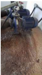
Foto 2 - Vazamento verificado em uma das bombas.
