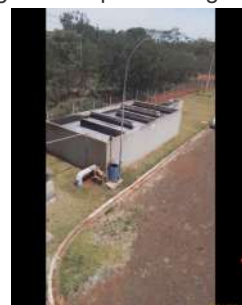
Foto 12 - Vista do tanque de contato, antes do lançamento final do esgoto. Não adição de substâncias para desinfecção.
