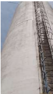
Foto 2 - Vazamento próximo a escada de acesso.
