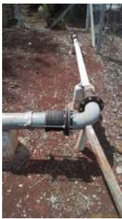
Foto 6 - Tubulação de entrada e saída de água do reservatório.
