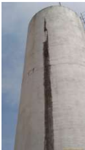
Foto 1 - Detalhe de um vazamento, próximo ao topo.
