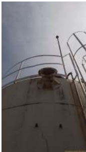
Foto 1 - Abertura superior do tanque sem tela de proteção.
