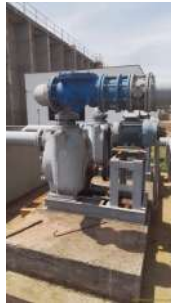
Foto 1 - Conjunto de moto bomba da elevatória de esgoto após peneiramento.
