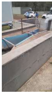
Foto 8 - Calha Parshall para análise do volume de esgoto após peneiramento.
