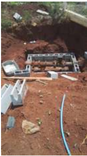
Foto 4 - Tubulações e conexões do reservatório.
