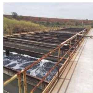
Foto 2 - Guarda-corpo com pintura precária.
