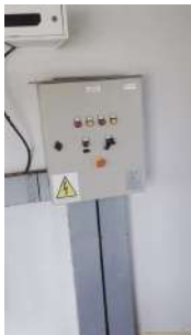
Foto 1 - Painel de comando da estação elevatória.
