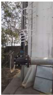
Foto 5 - Tubulação de entrada e saída de água do reservatório.
