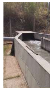
Foto 7 - Entrada de esgoto após peneiramento,
