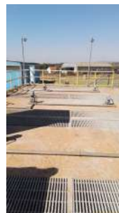
Foto 9 - Floculadores mecanizados, 8 no total
