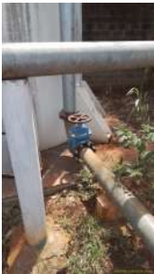
Foto 4 - Tubulação de entrada e saída de água do reservatório.
