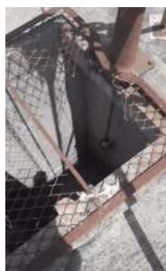
Foto 1 - Imagem da grade de proteção oxidada e com um buraco..
