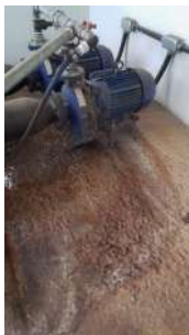
Foto 1 - Vazamento verificado em uma das bombas.
