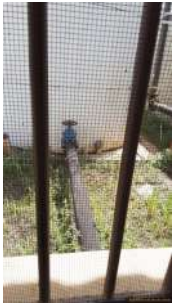
Foto 4 - Tubulação de sucção a partir do reservatório apoiado.
