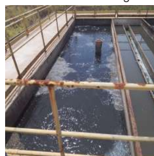
Foto 16 - Foi observado acúmulo de sólidos em um dos decantador, causado
