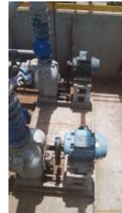
Foto 2 - Conjunto de moto bomba da estação elevatória, localizada antes da peneira rotativa.
