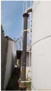
Foto 3 - Alimentação do reservatório.
