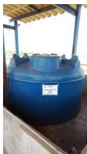
Foto 34 - Armazenamento de hipoclorito de sódio.
