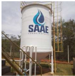
Foto 24 - Reservatório para acúmulo de lodo.
