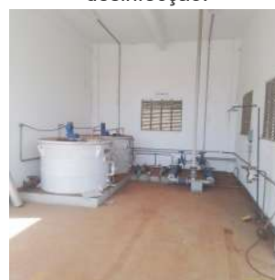
Foto 14 - Tanque de polímeros usado no tratamento de esgoto.
