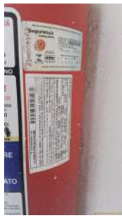
Foto 1 - Manutenções vencidas do extintor.
