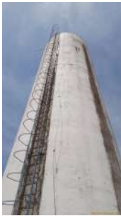
Foto 4 - Escada de acesso ao topo e fiação do para-raio.
