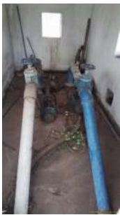
Foto 2 - Bombas e recalque.
