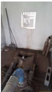
Foto 2 - Abertura do reservatório enterrado deve ser vedada.
