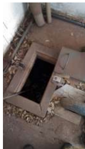
Foto 1 - Abertura do reservatório enterrado deve ser vedada.
