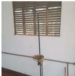
Foto 21 - Chuveiro de emergência.
