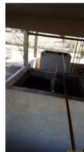
Foto 15 - Ponto de aplicação de cloro e fluor em caixas de equilíbrio
