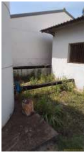
Foto 2 - Tubulação que encaminha água do reservatório para a elevatória, que por sua vez abastece o reservatório elevado.
