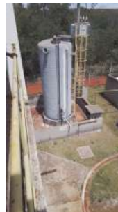
Foto 23 - Reservatório de hipoclorito de sódio vazio. Segundo o prestador, não são utilizados produtos químicos para desinfecção na etapa final. O uso do produto deve ocorrer futuramente conforme orientação da CETESB.
