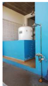
Foto 31 - Chuveiro de emergência.
