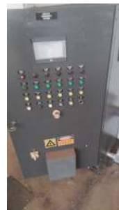
Foto 10 - Painel de controle da centrífuga usada para secagem de lodo.
