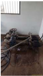
Foto 6 - Vazamento em uma das bombas.
