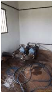
Foto 1 - Conjunto de motobombas da estação elevatória.
