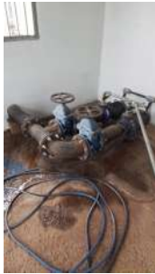
Foto 3 - Conjunto de motobombas da estação elevatória. Sendo uma em funcionamento e outra em reserva.
