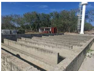
Foto 15 - Tanque de desinfecção
