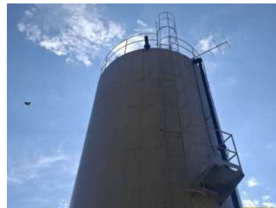
Foto 3 - Topo do reservatório com guarda-corpo
