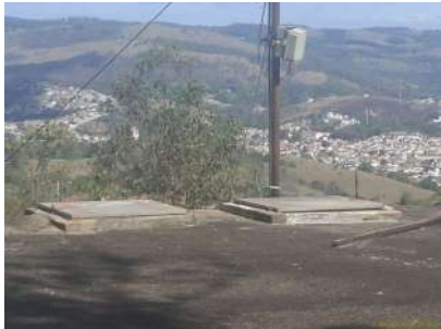
Foto 3 - Tampa de inspeção
