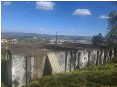
Foto 2 - Laje de cobertura do reservatório
