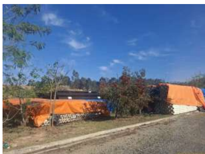
Foto 11 - Armazenamento de tubulação das obras
