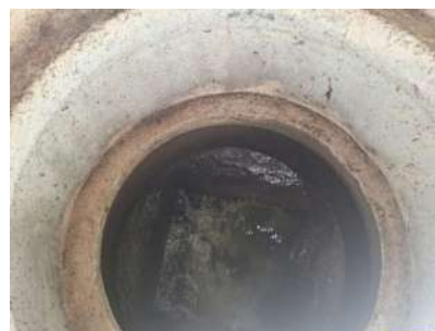
Foto 16 - Saída esgoto tratado
