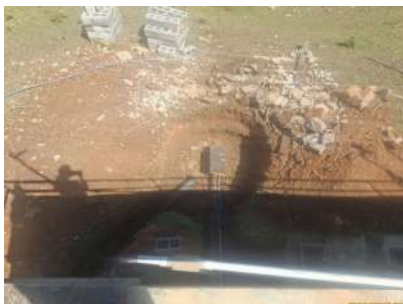
Foto 13 - Obras em andamento
