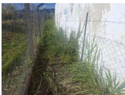
Foto 1 - Vista da área dos reservatórios
