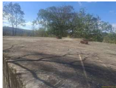
Foto 2 - Vista da laje de cobertura
