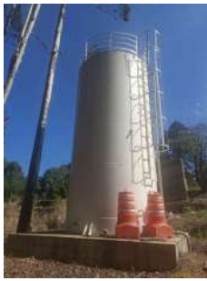
Foto 1 - Reservatório Planalto da Serra
