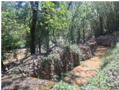
Foto 1 - Tomada de água
