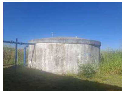
Foto 2 - Vista da área do reservatório
