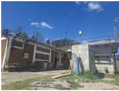
Foto 19 - Vista da ETA III
