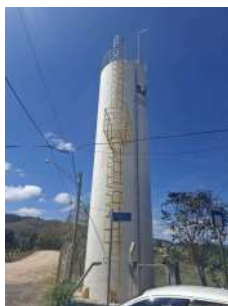
Foto 1 - Vista externa do reservatório Veneto
