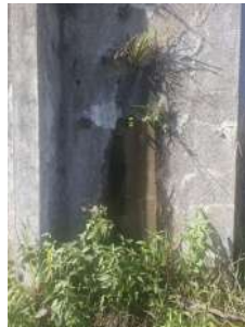
Foto 4 - Vazamento - Ponto 4
