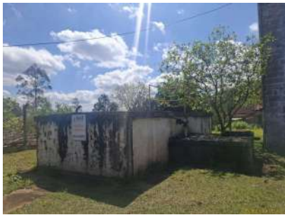
Foto 1 - Reservatório da Torre
