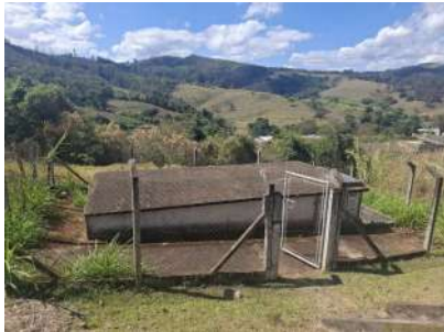
Foto 1 - Vista externa do reservatório Machucho
