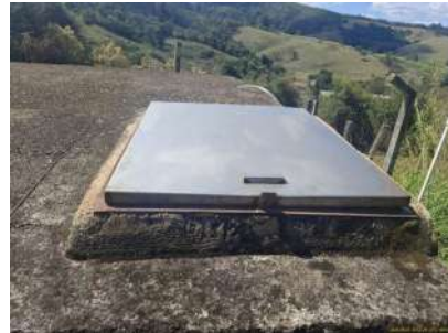
Foto 2 - Tampas de inspeção
