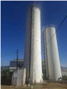
Foto 1 - Vista da área dos reservatórios e EEA.
