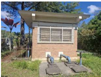
Foto 3 - Vista da captação
