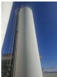
Foto 1 - Escada de acesso e guarda-corpos
