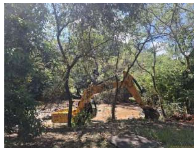
Foto 4 - Obra em andamento
