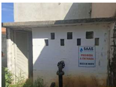
Foto 1 - Vista externa da casa de bombas
