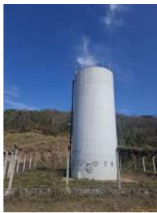
Foto 1 - Vista externa do reservatório Quintas de Santiago
