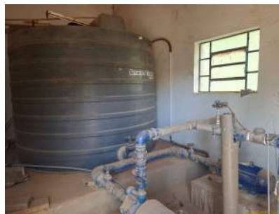
Foto 2 - Vista interna do reservatório e EEA
