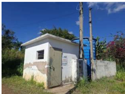
Foto 1 - Vista externa da EEA. e reservatório de recalque Bosque dos Eucaliptos
