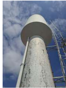
Foto 2 - Escada de acesso e guarda-corpo
