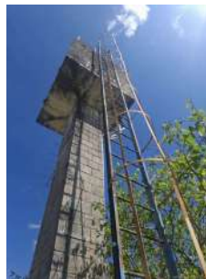
Foto 2 - Escada de acesso e guarda-corpo
