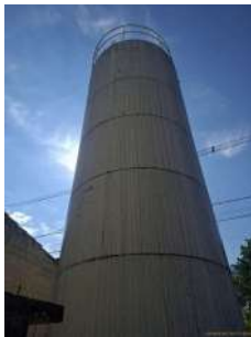
Foto 3 - Reservatório Quintas de Santiago
