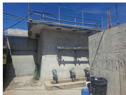
Foto 18 - Obras em andamento
