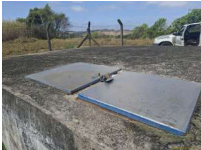
Foto 2 - Tampas de inspeção
