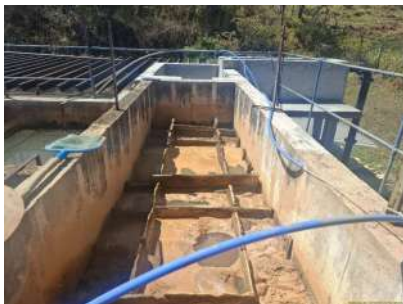
Foto 15 - Floculador em reforma e ampliação
