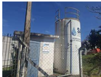
Foto 2 - Reservatório recalque Santa Maria
