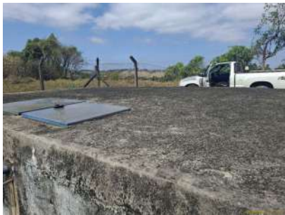
Foto 3 - Vista superior do reservatório
