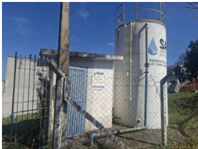
Foto 1 - Vista externa do cercamento da EEA e reservatório
