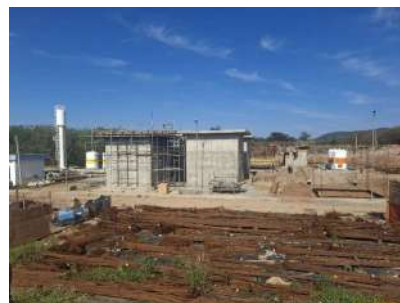
Foto 14 - Obras em andamento
