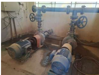
Foto 5 - Vista da interior da captação
