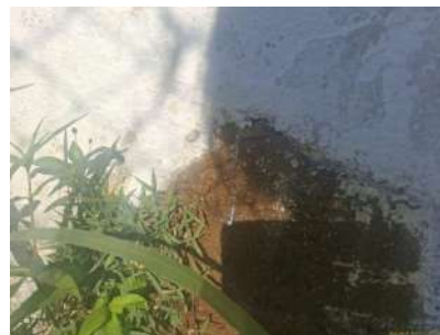
Foto 2 - Vazamento - Ponto 2
