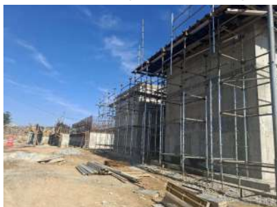
Foto 17 - Obras em andamento
