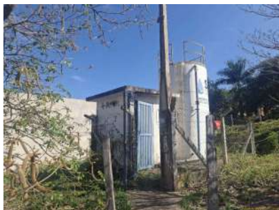
Foto 1 - Vista externa da área do reservatório e EEA.
