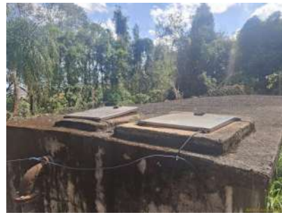
Foto 2 - Tampas de inspeção
