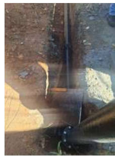
Foto 11 - Obras em andamento
