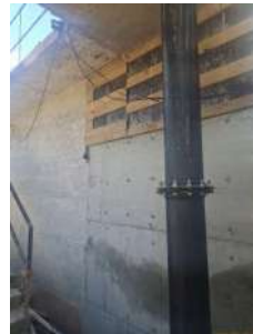
Foto 12 - Obras em andamento
