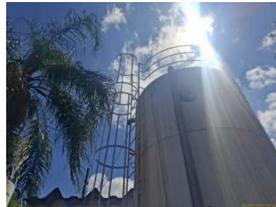
Foto 3 - Escada de acesso e guarda-corpo
