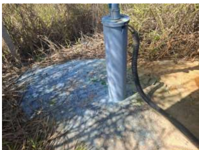
Foto 3 - Laje de proteção e medidor de nível
