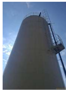
Foto 2 - Reservatório Quintas de Santiago
