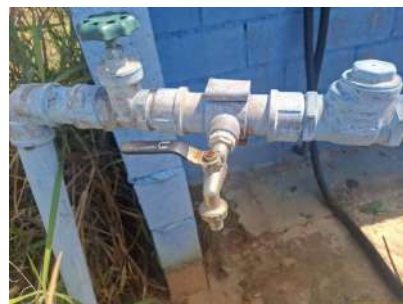
Foto 4 - Tomada para coleta de água bruta
