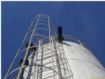
Foto 4 - Escada de acesso, guarda-corpo e tubo extravasor
