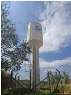
Foto 1 - Vista externa do reservatório Atílio Mazzini
