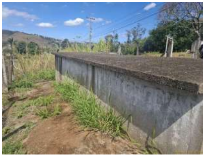
Foto 5 - Vista lateral do reservatório Machucho
