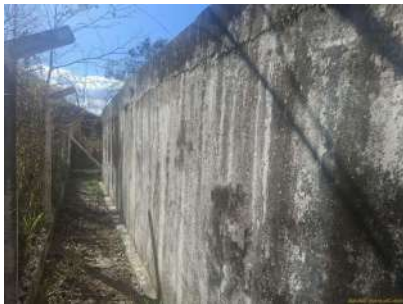
Foto 3 - Vista lateral do reservatório Parque do Sol
