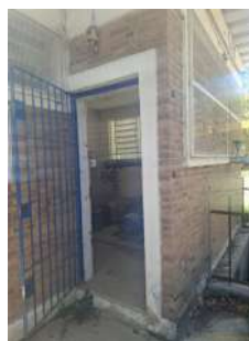
Foto 8 - Portão de acesso
