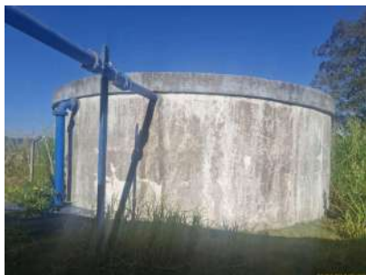
Foto 1 - Reservatório Jardim Itália (circular)
