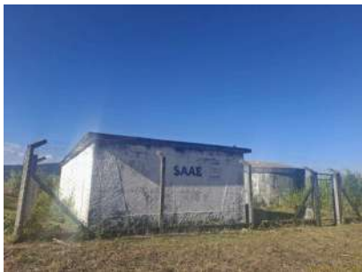
Foto 1 - Vista externa do reservatório Jardim Itália
