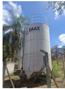
Foto 2 - Vista externa do reservatório
