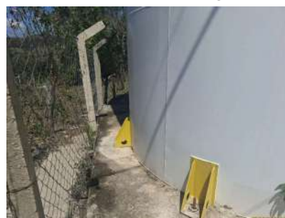
Foto 4 - Vista lateral do cercamento
