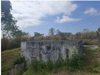
Foto 1 - Reservatório Vista Alegre
