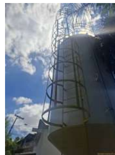
Foto 3 - Escada de acesso e guarda-corpo
