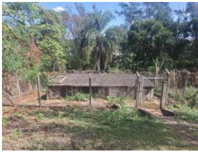
Foto 1 - Reservatório do Buraco
