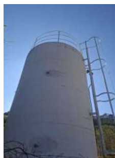
Foto 2 - Escada de acesso e guarda-corpo
