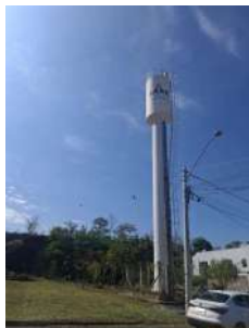
Foto 1 - Reservatório Santa Maria
