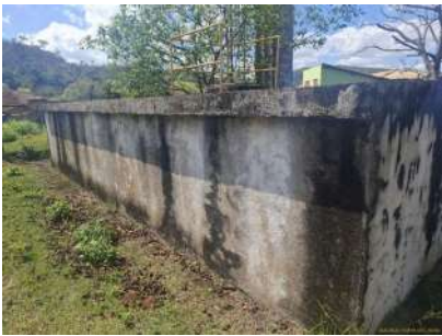
Foto 2 - Vista lateral do reservatório da Torre
