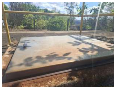
Foto 4 - Tampa de inspeção
