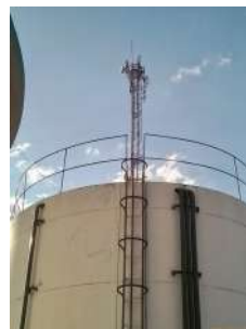
Foto 5 - Reservatório à frente e torre de comunicação ao fundo com para-raio.
