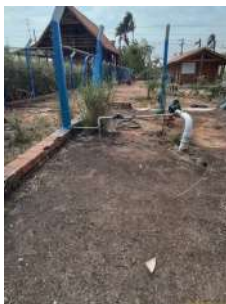
Foto 1 - Detalhe do cavalete sem a torneira para coleta de água bruta.
