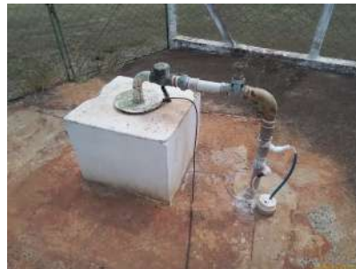
Foto 2 - Detalhe do cavalete.
