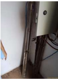
Foto 4 - Bomba retirada do poço do sistema 5 para manutenção.
