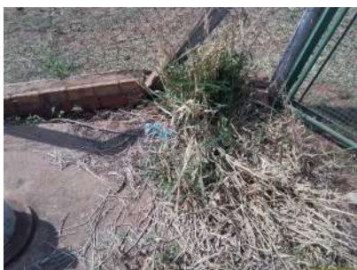
Foto 1 - Acúmulo 1 de vegetação no local.
