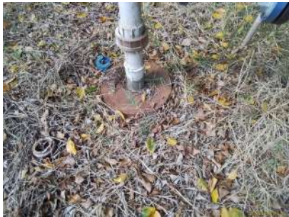
Foto 1 - Detalhe do poço.
