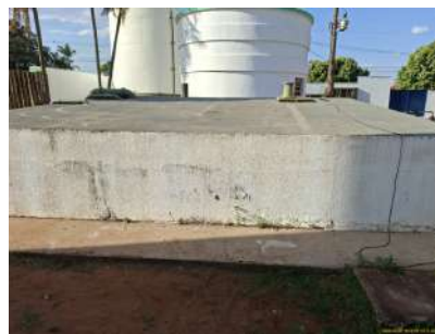
Foto 4 - Fachada do reservatório 3.
