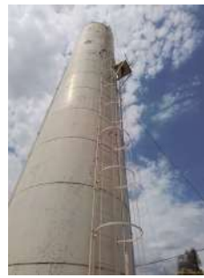
Foto 2 - Detalhe da escada com guarda-corpos.
