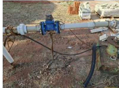
Foto 2 - Lateral do poço.
