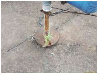
Foto 3 - Detalhe da laje do poço.
