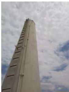
Foto 1 - Vista do reservatório.
