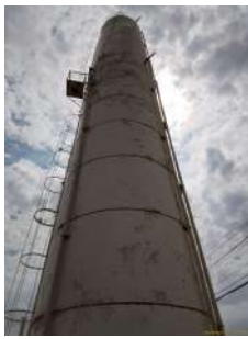
Foto 1 - Vista do reservatório.
