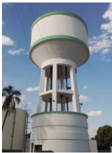
Foto 1 - Vista do reservatório elevado.
