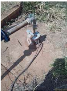
Foto 2 - Detalhe do cavalete.
