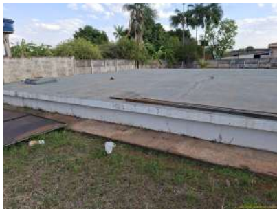
Foto 1 - Vista do reservatório 2.
