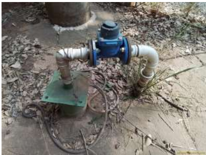
Foto 2 - Detalhe do cavalete.
