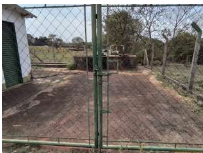
Foto 1 - Cercamento do local.
