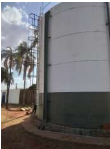
Foto 3 - Chegada de água no reservatório.
