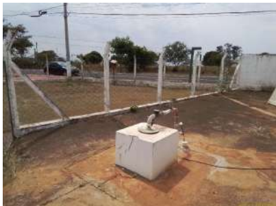
Foto 1 - Vista geral do poço.
