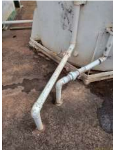
Foto 3 - Saída do reservatório.
