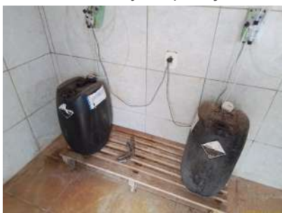
Foto 5 - Aplicação de cloro e flúor.
