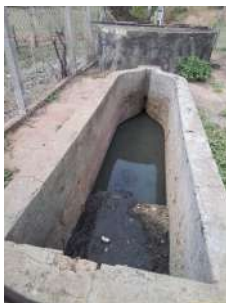
Foto 1 - Detalhe da caixa de areia.
