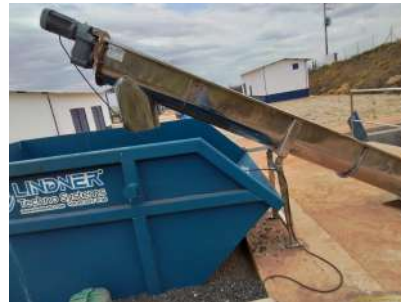
Foto 6 - Caçamba e rosca infinita para retirada da areia.
