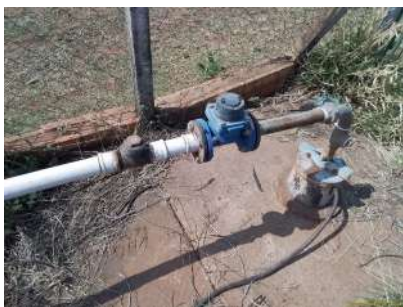
Foto 1 - Detalhe do cavalete.
