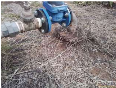
Foto 2 - Detalhe do cavalete.
