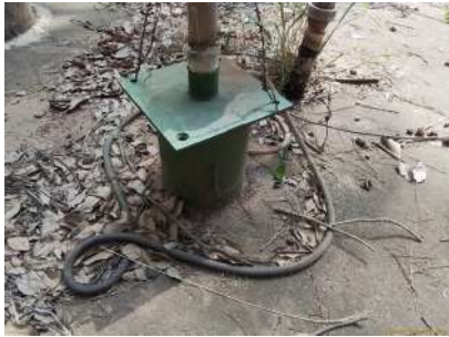
Foto 3 - Detalhe da laje.
