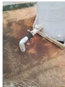
Foto 2 - Saída do reservatório.
