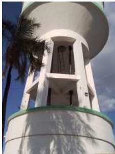
Foto 3 - O acesso ao reservatório é feito por escadas interligadas por patamares intermediários.
