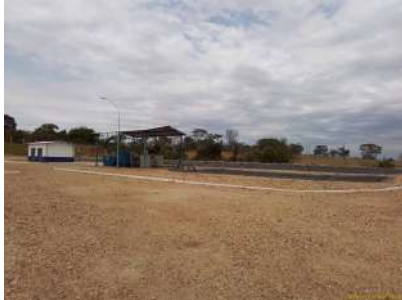
Foto 1 - Vista geral da ETE.
