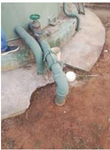
Foto 3 - Extravasor à esquerda.
