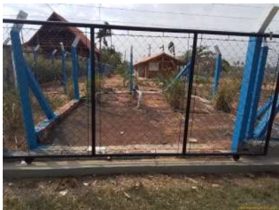
Foto 1 - Cercamento do local.
