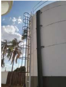
Foto 2 - Escada com guarda-corpos para acesso ao topo do reservatório.
