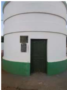
Foto 2 - Entrada da EEA sob o reservatório elevado.
