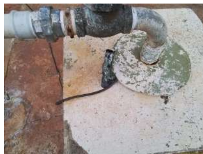
Foto 4 - Detalhe da laje.
