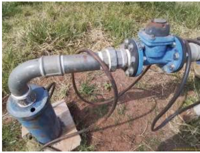
Foto 1 - Detalhe do cavalete.
