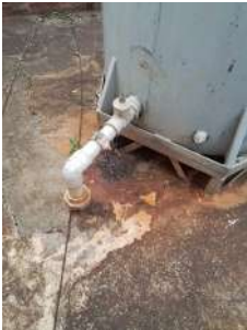
Foto 2 - Detalhe da saída.
