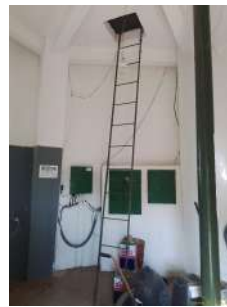
Foto 2 - Acesso interno ao reservatório.
