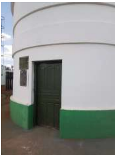
Foto 1 - A EEA encontra-se dentro de área cercada, junto dos reservatórios 1 a 5 e poços 13 e 14.
