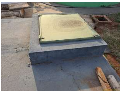
Foto 3 - Tampa de inspeção do reservatório 2, próximo ao reservatório 3.
