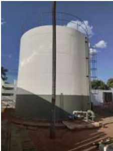
Foto 1 - Vista do reservatório.
