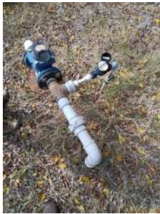
Foto 2 - Detalhe do cavalete.
