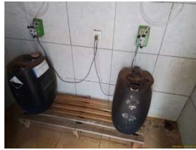
Foto 4 - Aplicação de cloro e flúor no local.
