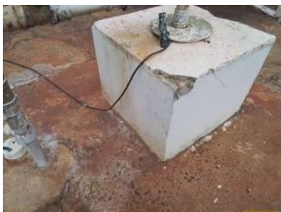
Foto 3 - Laje de proteção.
