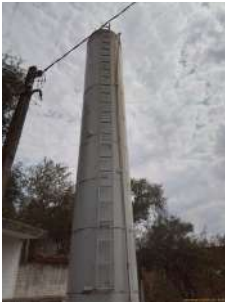
Foto 1 - Vista do reservatório.
