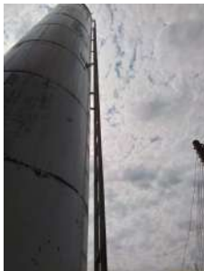
Foto 1 - Detalhe da escada.
