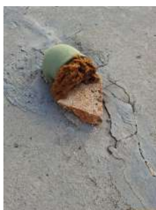
Foto 1 - Detalhe da tubulação de ventilação.
