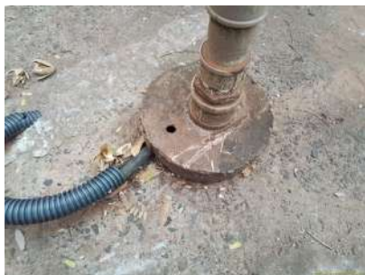
Foto 1 - Detalhe do local para instalação do tubo de medição de nível.
