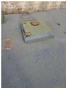
Foto 2 - Tampa de inspeção do reservatório 2.
