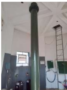
Foto 6 - Extravador do reservatório.
