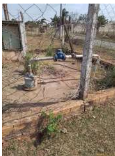
Foto 1 - Detalhe da abertura na cerca.
