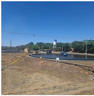
Foto 16 - Decantador primário
