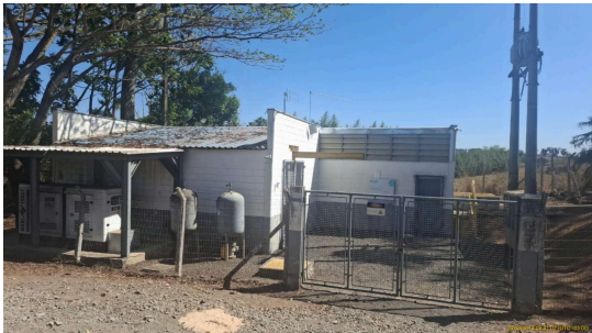
Foto 1 - Vista externa da EEEB Lagoa Nova
