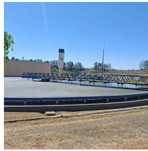
Foto 17 - Decantador primário
