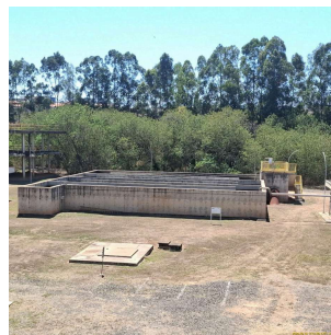
Foto 21 - Vista superior do sistema de desinfecção
