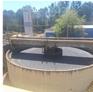
Foto 14 - Adensador com controle de odor
