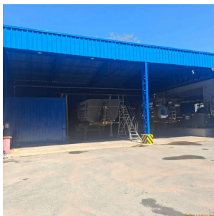
Foto 11 - Desidratação de lodo primário
