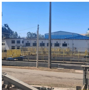
Foto 4 - Vista lateral dos desarenadores
