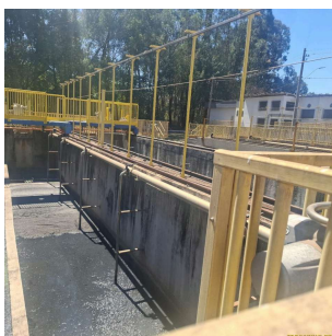
Foto 5 - Desarenador em manutenção
