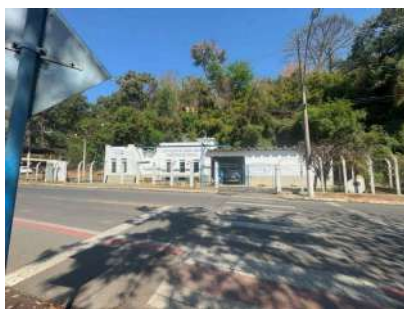
Foto 5 - Vista geral da captação
