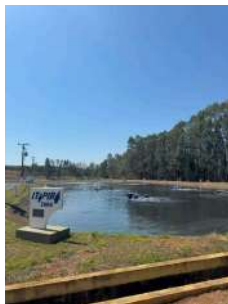
Foto 19 - Vista lagoa aerada
