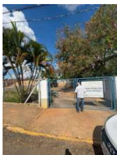
Foto 1 - Vista geral da fachada
