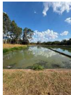
Foto 4 - Lagoa de estabilização
