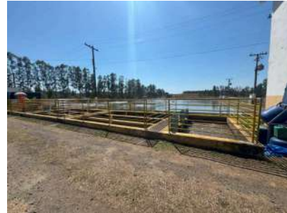
Foto 16 - Entrada de esgoto bruto
