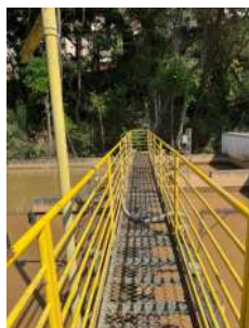
Foto 30 - Armazenamento de lodo
