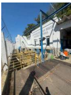
Foto 3 - Vista da casa de bombas
