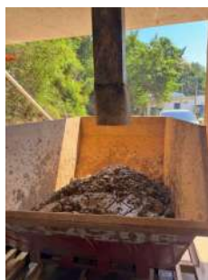
Foto 24 - Caçamba de lodo
