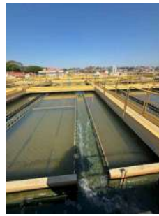
Foto 14 - Vista geral da ETA
