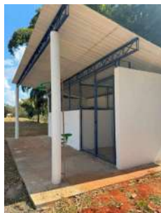
Foto 10 - Casa de produto químico
