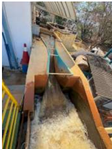
Foto 9 - Entrada de água bruta
