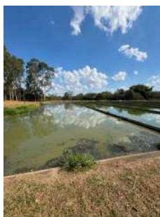
Foto 5 - Lagoa de estabilização
