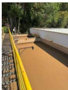
Foto 28 - Armazenamento de lodo
