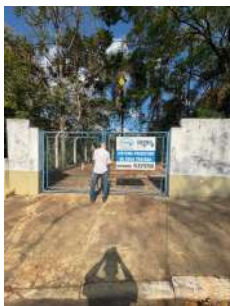
Foto 3 - Fachada da área (antigo poço)
