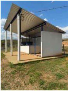
Foto 3 - Casa de produto químico
