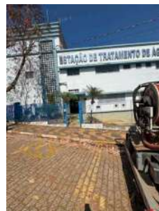
Foto 22 - Vista da fachada
