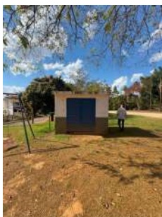
Foto 1 - Área do poço
