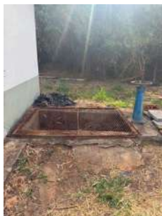
Foto 13 - Elevatório de esgoto final
