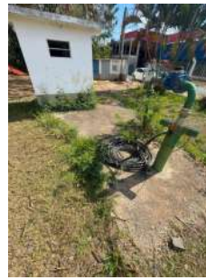
Foto 4 - Detalhe do cavalete
