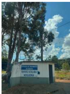
Foto 1 - Fachada da ETE
