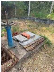
Foto 12 - Elevatório de esgoto final
