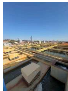
Foto 12 - Vista geral da ETA
