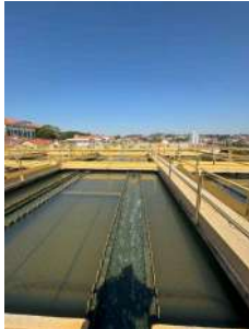
Foto 15 - Vista geral da ETA
