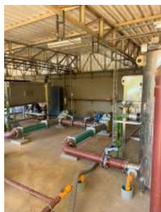
Foto 26 - Tratamento de lodo
