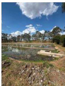
Foto 1 - Ausência de limpeza
