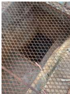
Foto 11 - Gradeamento da EEBB
