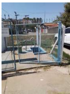
Foto 1 - Cercamento da área
