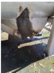
Foto 1 - Vazamentos aparentes
