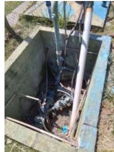
Foto 2 - Detalhe da tubulação dos poços.
