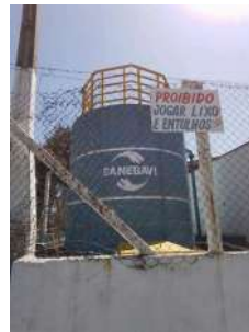
Foto 5 - Cercamento da área do reservatório
