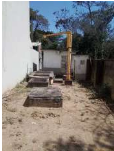
Foto 5 - Estação elevatória de esgoto bruto do Treviso
