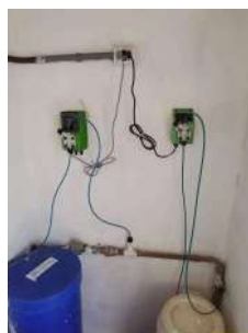
Foto 6 - Aplicação de cloração e/ou fluoretação
