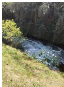
Foto 17 - Lançamento do efluente tratado
