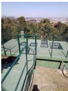
Foto 1 - Estação elevatória de esgoto Morada do Sol
