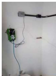
Foto 4 - Dosadores de cloração e/ou fluoretação
