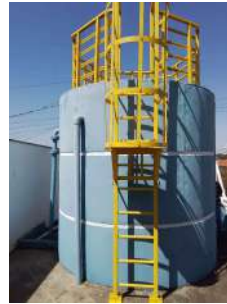
Foto 2 - Reservatório do Jardim Melle
