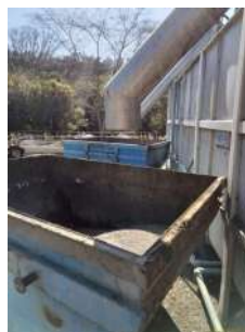
Foto 7 - Caçambas para descarte do material retido
