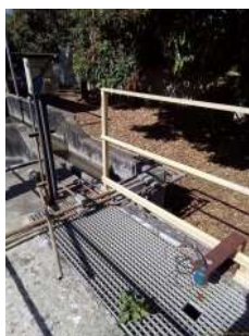
Foto 8 - Medidor de pressão após a caixa de areia
