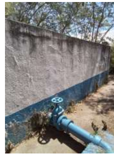
Foto 5 - Destaque para tubulações e registro
