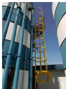
Foto 2 - Escada de acesso e guarda corpo
