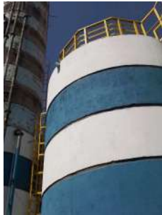
Foto 3 - Tubo extravasor e guarda corpo
