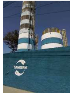
Foto 4 - Vista externa do reservatório com a identificação do prestador
