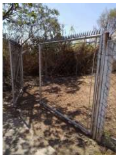
Foto 1 - Cercamento da área
