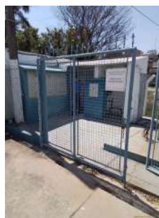
Foto 2 - Poço P-18 - Barra Funda
