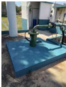
Foto 3 - Laje de proteção do poço 11
