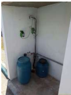
Foto 5 - Sistema de aplicação de cloração e/ou fluoretação
