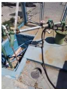
Foto 7 - Destaque para estrutura do poço
