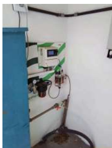
Foto 5 - Dosadores de cloração e/ou fluoretação
