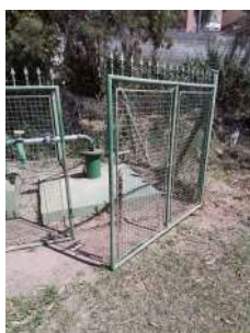
Foto 1 - Cercamento da área
