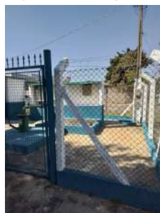
Foto 8 - Área do poço devidamente cercada
