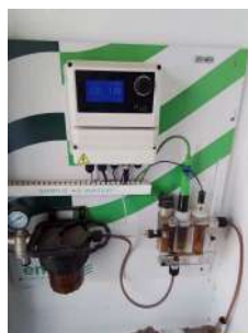
Foto 6 - Dosadores de cloração e/ou fluoretação
