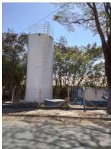
Foto 1 - Reservatório metálico (ainda não está operando)
