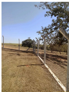
Foto 7 - Região cercada por alambrado.
