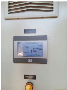
Foto 2 - Pannel de exibição do níveis e controle do funcionamento da bomba
