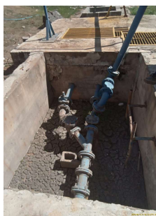
Foto 4 - Recalque de esgoto - Tubulação de chegada do conjunto instalado provisório.
