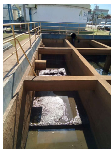
Foto 9 - Tanque de acúmulo de resíduos do tratamento, com sucção da fase sólida para centrífuga
