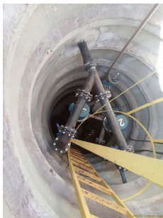
Foto 3 - Acesso às bombas
