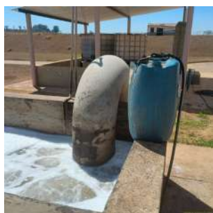
Foto 21 - Dosagem de antiespumante e cloro.
