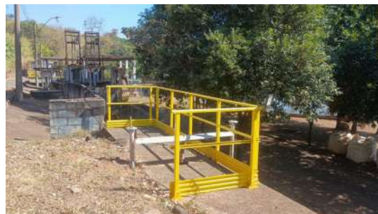
Foto 32 - Macromedidor de entrada (segundo informação do prestador, o medidor não está informando precisamente as vazões).
