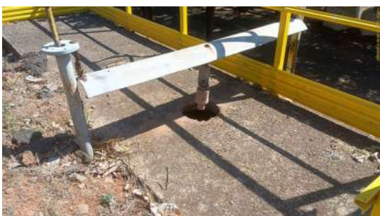
Foto 33 - Macromedidor de entrada (segundo informação do prestador, o medidor não está informando precisamente as vazões).
