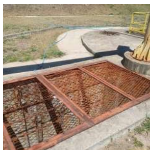
Foto 1 - Situação da grade acima do canal do gradeamento.
