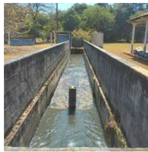
Foto 18 - Canal de saída do efluente final.
