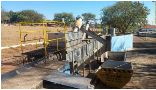
Foto 5 - Gradeamento e remoção de areia.
