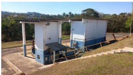
Foto 17 - Abrigos dos conjuntos motobomba de recirculação de lodo e da centrífuga de adensamento de lodo.
