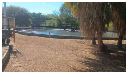
Foto 49 - Decantador primário 2.
