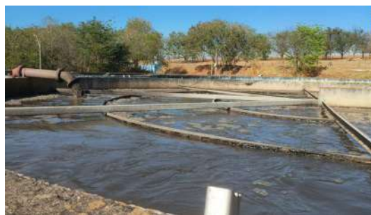
Foto 16 - Valo de oxidação (tubulação à esquerda de recirculação de lodo).
