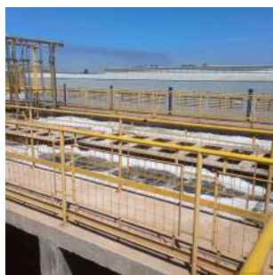
Foto 16 - Vista geral da parte superior dos tanques.
