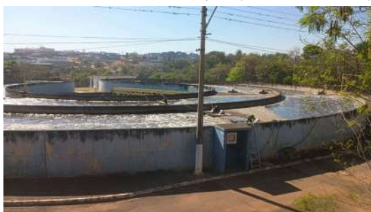
Foto 51 - Vista geral das unidades de tratamento (valo de oxidação).
