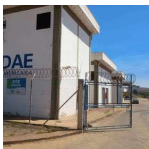
Foto 1 - Vista externa da ETE, com identificação do local.
