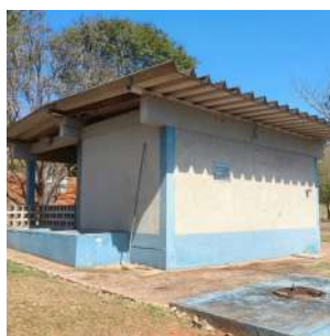
Foto 6 - Abrigo dos conjuntos motobomba de lodo.
