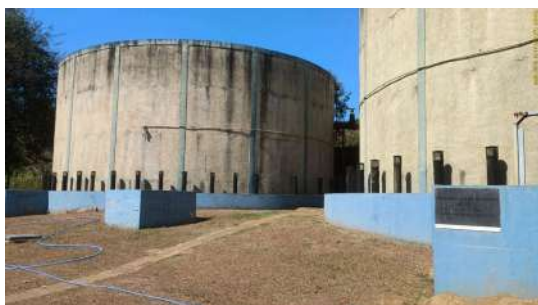
Foto 52 - Filtros biológicos de percolação (desativados).
