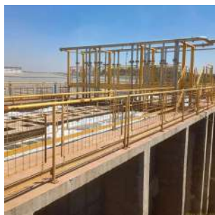
Foto 18 - Vista geral da parte superior dos tanques.
