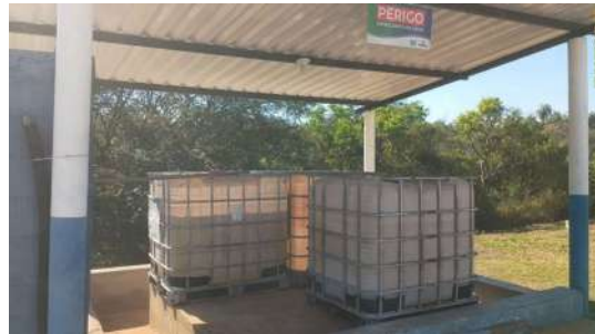
Foto 29 - Abrigo dos tanques de produtos químicos.
