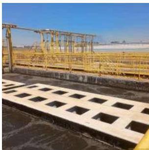
Foto 14 - Vista superior dos tanques de tratamento (lodos ativados).
