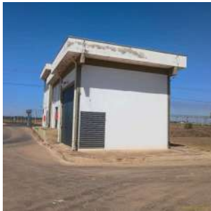
Foto 39 - Abrigos do grupo gerador e cabine primária.
