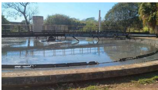
Foto 48 - Decantador primário 1.
