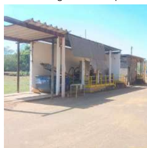
Foto 16 - Vista geral do tratamento de lodo (centrífuga).
