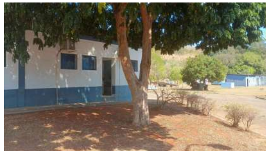
Foto 30 - Vista geral de parte do prédio administrativo/laboratório da ETE.
