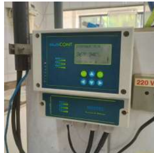
Foto 28 - Tela do sistema de telemetria, com indicação da vazão momentânea de entrada.
