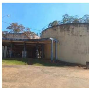
Foto 15 - Biodigestores de lodo (apenas o da esquerda que está operando).
