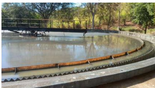
Foto 50 - Decantador primário 2.
