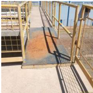
Foto 1 - Situação da passarela entre os dois tanques de tratamento.
