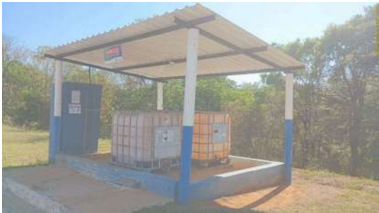
Foto 28 - Abrigo dos tanques de produtos químicos.
