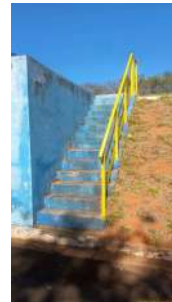
Foto 12 - Escada de acesso ao tratamento preliminar.
