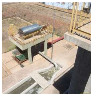
Foto 17 - Vista superior do local de chegada do esgoto antes do gradeamento.
