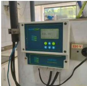
Foto 27 - Tela do sistema de telemetria, com indicação da vazão momentânea de saída.
