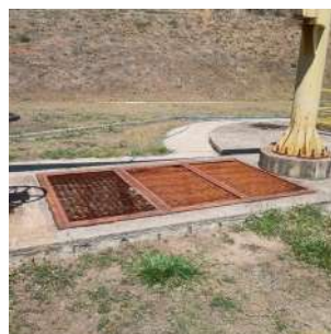
Foto 2 - Situação da grade acima do canal do gradeamento.
