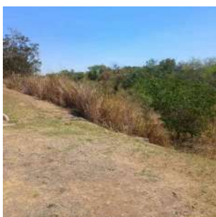
Foto 1 - Ausência de cercamento na parte inferior do local.
