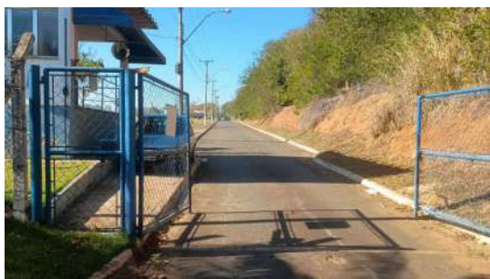
Foto 1 - Entrada da ETE.
