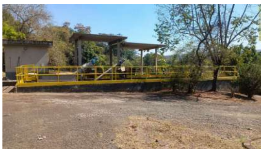
Foto 43 - Desarenador 3 e preliminar 3, em operação.
