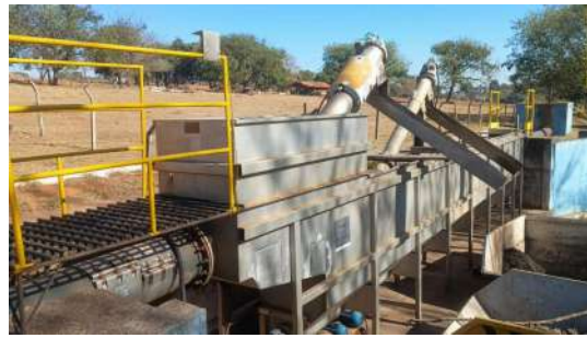
Foto 6 - Gradeamento e remoção de areia.
