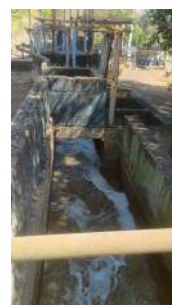
Foto 34 - Canal entre chegada do esgoto e tratamento preliminar.
