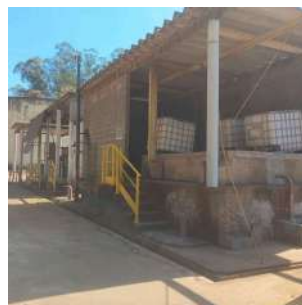
Foto 11 - Abrigo de tanques de polímero para adensamento do lodo.
