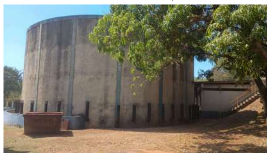
Foto 51 - Filtros biológicos de percolação (desativados).
