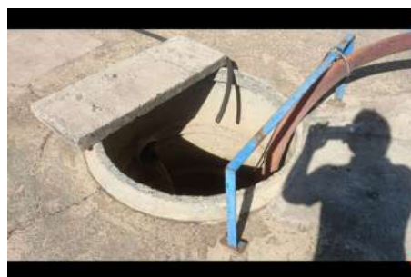
Foto 23 - Tanque com o líquido percolado da centrífuga, que retorna para o tratamento.
