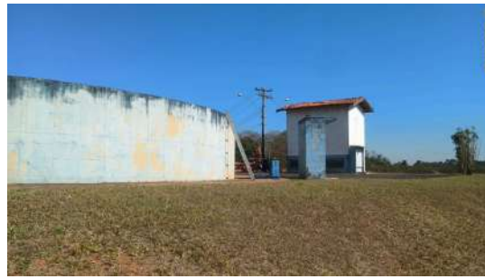
Foto 35 - Vista geral de parte do valo de oxidação.
