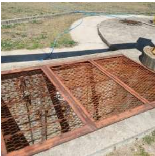
Foto 1 - Grade horizontal acima do canal do gradeamento.
