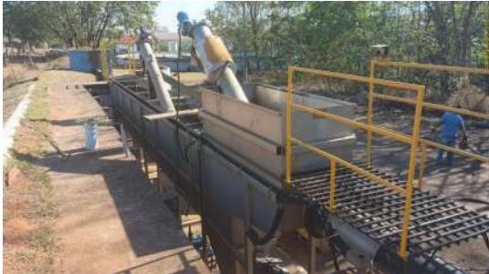
Foto 7 - Gradeamento e remoção de areia.
