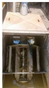
Foto 45 - Desarenador 3 (remoção do material de fundo do canal).
