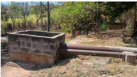
Foto 31 - Chegada do esgoto bruto na ETE.
