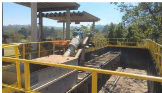
Foto 44 - Desarenador 3, em operação.
