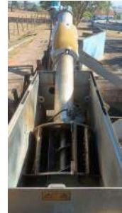
Foto 8 - Gradeamento automatizado.
