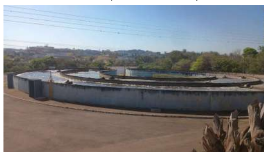
Foto 50 - Vista geral das unidades de tratamento (valo de oxidação).
