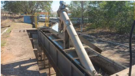
Foto 9 - Remoção de areia e sedimentos.
