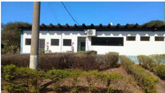
Foto 29 - Vista geral de parte do prédio administrativo/laboratório da ETE.
