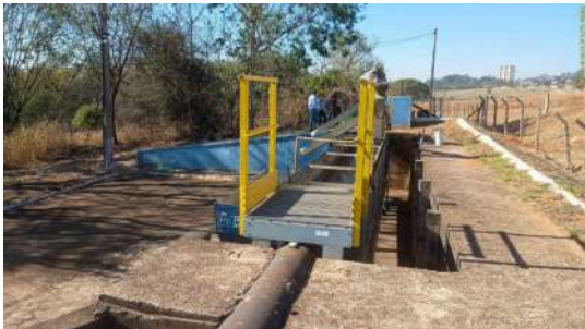
Foto 11 - Visão geral das estruturas de tratamento preliminar.
