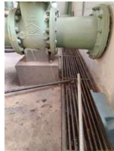
Foto 4 - Drenagem das gaxetas
