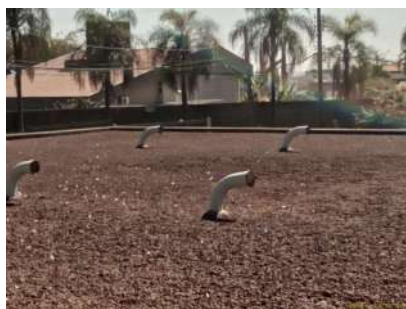
Foto 3 - Ventilação - Reserv. Semienterrado 2 - Uniliete
