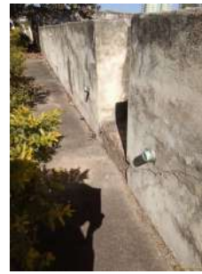
Foto 4 - Extravasores com tela de proteção
