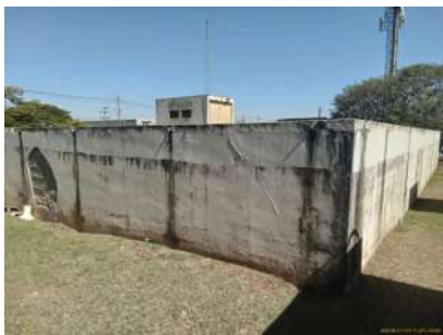
Foto 2 - Visão geral - externo - Reserv. unileste Semienterrado 1 (2)
