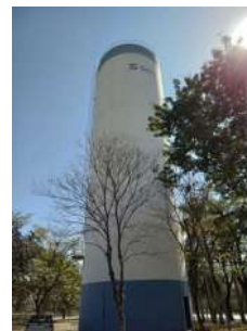
Foto 2 - Visão geral - Reservatório Agronomia
