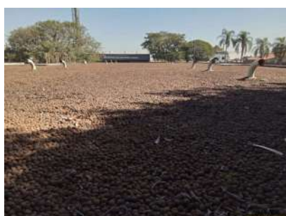
Foto 9 - Cobertura com argila expandida e ventilação - Reserv. Semienterrado 2 - Uniliete
