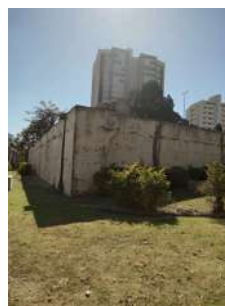
Foto 4 - Visão geral - paredes do reservatório
