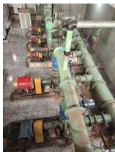
Foto 8 - Visão geral - estação elevatória
