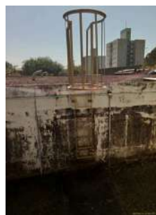
Foto 4 - Acesso à cobertura - Reserv. Semienterrado 2 - Uniliete
