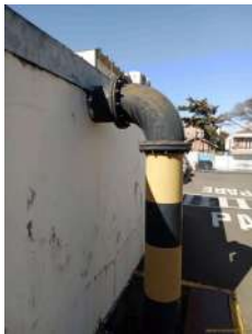
Foto 3 - Extravasor - Reservatório
