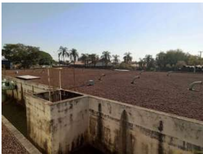
Foto 1 - Cobertura - ventilação e tampa - Reserv. Semienterrado 2 - Uniliete
