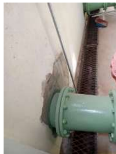
Foto 4 - Drenagem das gaxetas
