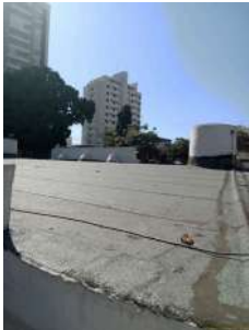
Foto 3 - Cobertura com impermeabilização com manta asfáltica - Reservatório Marechal 3
