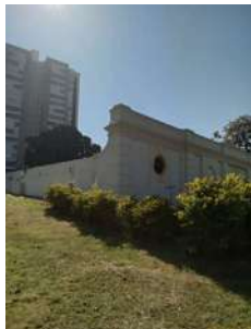
Foto 1 - Visão geral - Reservatório Marechal 3
