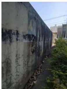
Foto 3 - Parede lateral - Reservatório
