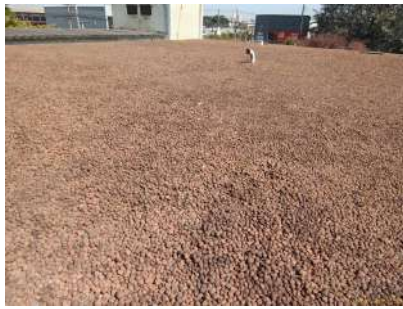
Foto 5 - Visão geral - cobertura - - Reserv. unileste Semienterrado 1
