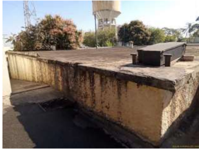
Foto 1 - Visão geral - cobertura - Reservatório Semienterrado velho XV de Novembro
