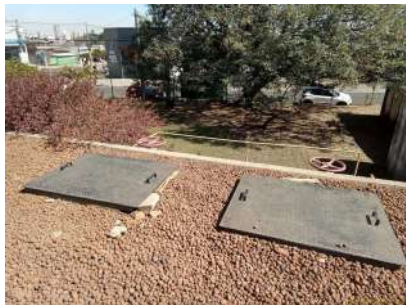
Foto 3 - Tampa de inspeção - Reserv. unileste Semienterrado 1
