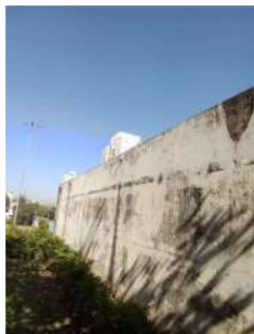
Foto 5 - Lateral - Reservatório Marechal 4
