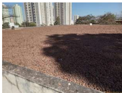
Foto 2 - Cobertura do reservatório
