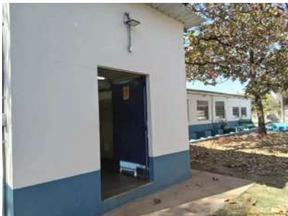
Foto 1 - Entrada da casa de bombas
