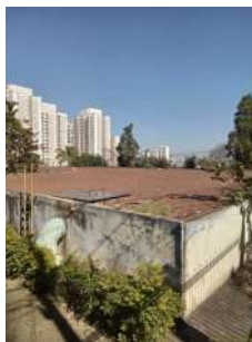
Foto 4 - Tampa de inspeção
