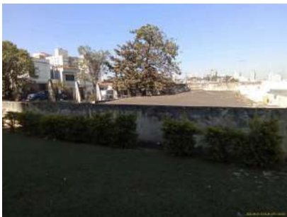
Foto 2 - Parede externa - Reservatório Marechal 2
