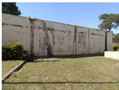
Foto 1 - Parede externa do reservatório
