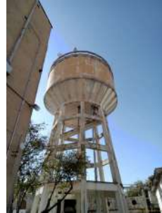
Foto 4 - Visão geral - Reservatório Elevado XV de Novembro (2)
