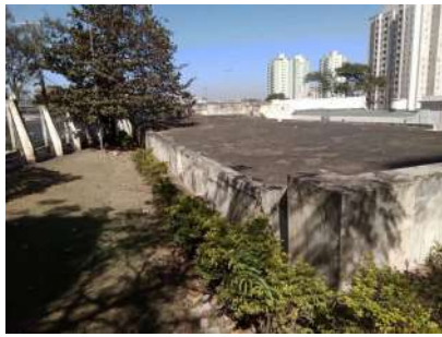
Foto 3 - Visão geral - Cobertura - Reservatório Marechal 2 (2)
