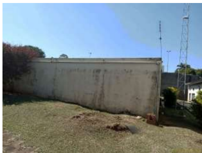
Foto 1 - Visão geral - externo - Reserv. unileste Semienterrado 1
