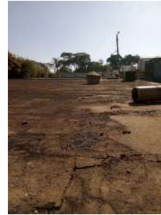
Foto 2 - Cobertura e ventilação - Reservatório Semienterrado velho XV de Novembro
