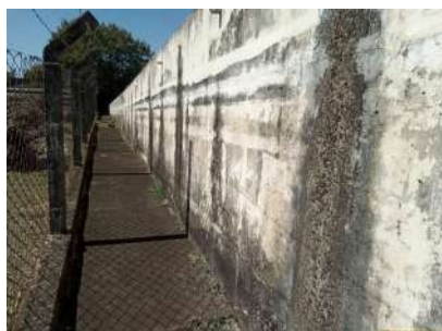
Foto 7 - Extravasores sobre parede - Reserv. Semienterrado 2 - Uniliete
