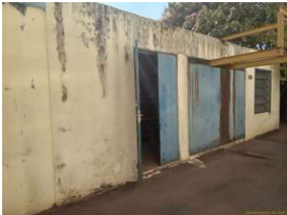
Foto 1 - Acesso para manutenção - Içamento monovia
