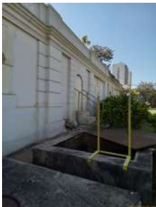
Foto 2 - Lateral - Reservatório Marechal 3
