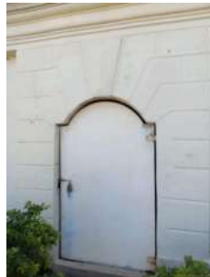
Foto 6 - Porta de acesso ao reservatório
