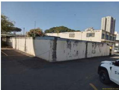
Foto 1 - Visão geral - Reservatório Semienterrado novo XV
