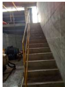
Foto 7 - Escada com guarda-corpos
