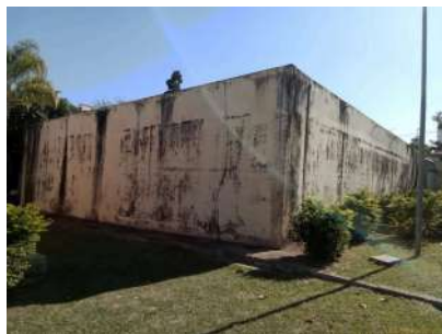
Foto 1 - Visão geral - Reservatório Marechal 4 - Bipartido
