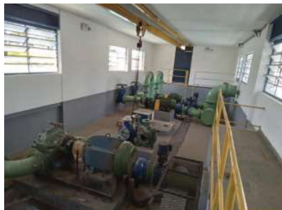
Foto 1 - Visão geral - instalação dos conjuntos motobomba
