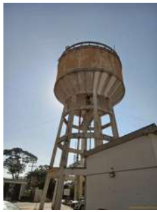
Foto 1 - Visão geral - Reservatório Elevado XV de Novembro
