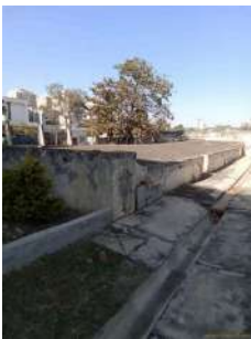
Foto 1 - Visão geral - Cobertura - Reservatório Marechal 2
