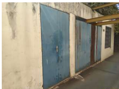
Foto 10 - Içamento monovia - acesso para manutenção
