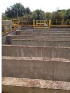
Foto 14 - Chicanas - saída do efluente tratado
