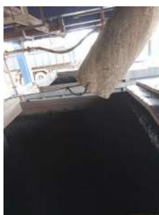
Foto 13 - Caçamba para disposição de lodo
