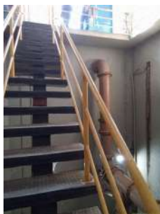
Foto 3 - Acesso à elevatória com escada e guarda-corpos
