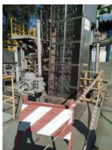
Foto 30 - Gradeamento do estação elevatória
