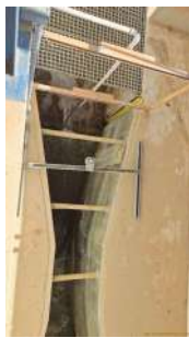
Foto 35 - Macromedidor de vazão de saída
