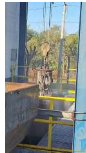
Foto 2 - Caçamba clamshell - remoção de areia
