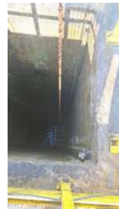
Foto 3 - Gradeamento da elevatória com cesto
