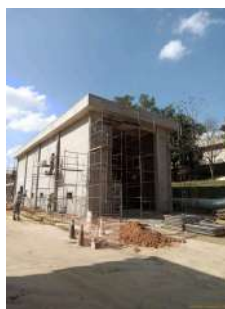
Foto 16 - Obras de retrofit da estação
