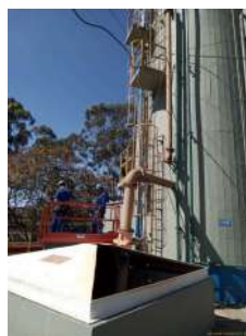
Foto 10 - Equipe em manutenção de limpeza das grades no tratamento preliminar
