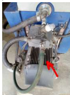
Foto 10 - Injeção de polímero para desidratação do lodo
