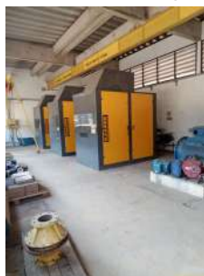
Foto 22 - Casa de sopradores
