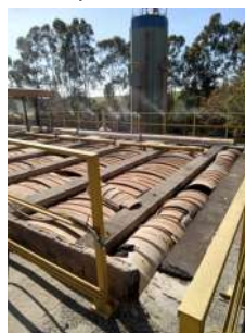
Foto 14 - Reator anaeróbio por cima e aspersão de neutralizador de odores.
