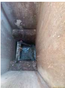
Foto 2 - Gradeamento com cesto
