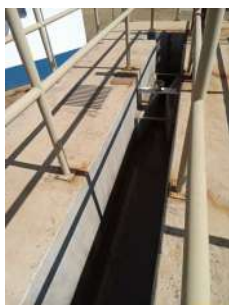
Foto 20 - Macromedicação de entrada da ETE
