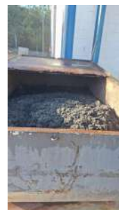
Foto 5 - Caçamba com areia removida de fundo do poço
