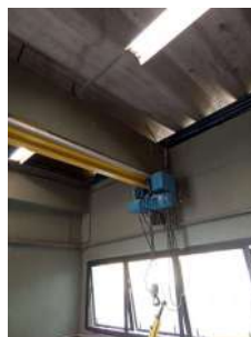
Foto 8 - Içamento monovia com talha elétrica - estação de tratamento de lodo
