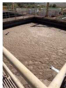
Foto 15 - Reator aeróbio em operação
