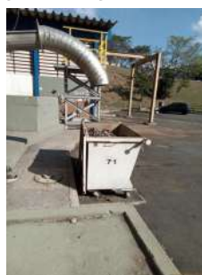
Foto 31 - Caçamba de descarte de material do gradeamento da elevatória
