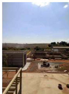
Foto 19 - Visão geral - ETE em obras de ampliação
