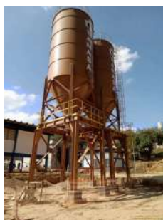
Foto 15 - Instalação de silos
