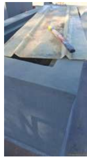
Foto 17 - Módulo 3 com impermeabilização
