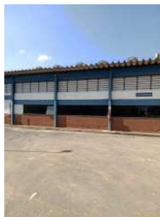
Foto 20 - Casa de sopradores
