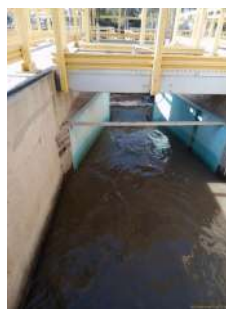
Foto 26 - Macromedidor com sensor de nível ultrassônico
