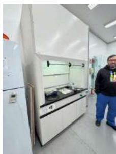
Foto 9 - Vista geral do laboratório
