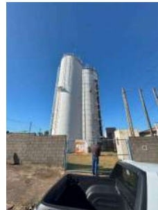
Foto 8 - Vista da área
