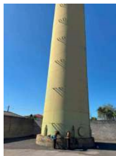
Foto 4 - Vista do reservatório
