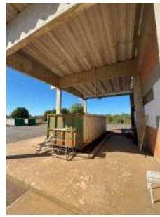
Foto 38 - Caçamba de lodo
