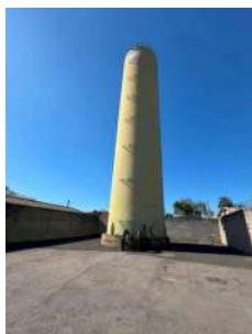
Foto 3 - Vista do reservatório
