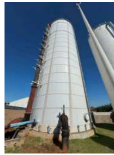
Foto 4 - Vista do reservatório
