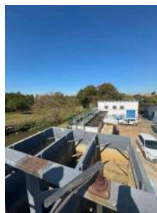
Foto 6 - Vista tanque de contato
