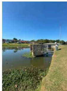
Foto 4 - Vista geral da captação
