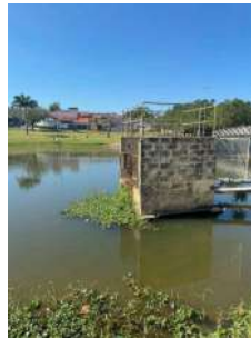
Foto 2 - Vista geral da captação
