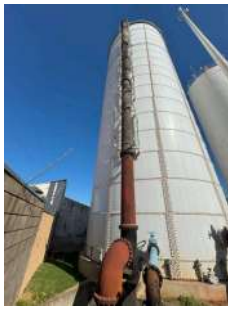
Foto 3 - Vista do reservatório
