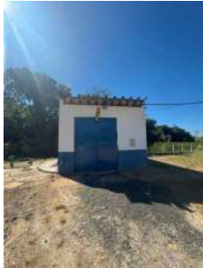
Foto 7 - Casa de bombas
