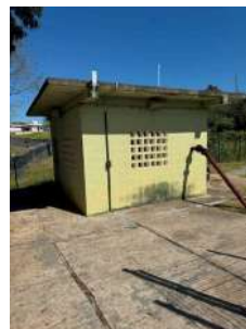
Foto 2 - Casa de bombas
