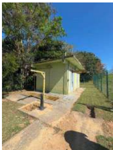
Foto 1 - Casa de bombas
