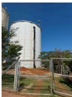
Foto 1 - Vista da área
