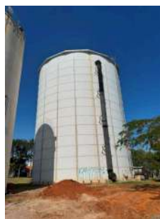
Foto 2 - Vista do reservatório
