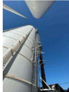
Foto 6 - Vista dos reservatórios
