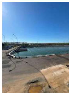
Foto 22 - Tanques de aeração
