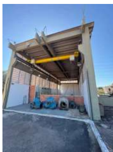
Foto 17 - Elevatória de Esgoto bruto
