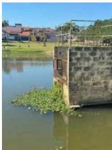
Foto 3 - Vista geral da captação
