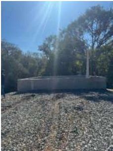
Foto 1 - Vista geral da Captação
