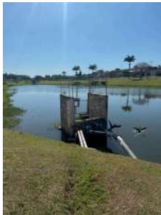
Foto 1 - Vista geral da captação
