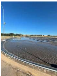
Foto 31 - Tanque de aerção
