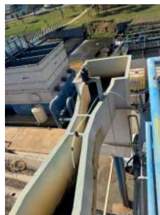
Foto 12 - Canal de entrada e medidor de vazão
