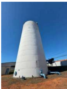
Foto 3 - Vista do reservatório
