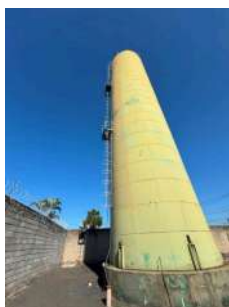
Foto 5 - Vista do reservatório
