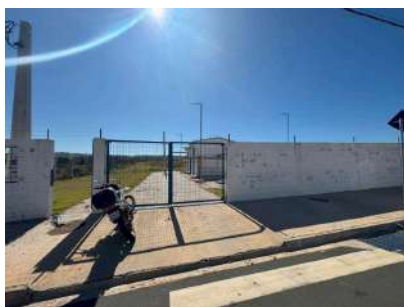
Foto 1 - Vista geral da unidade
