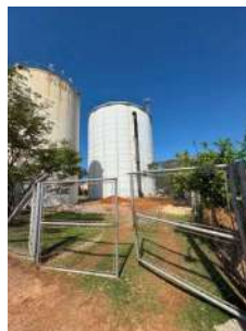
Foto 6 - Vista da área
