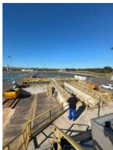
Foto 21 - Vista geral das unidades
