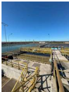
Foto 23 - Vista geral das unidades
