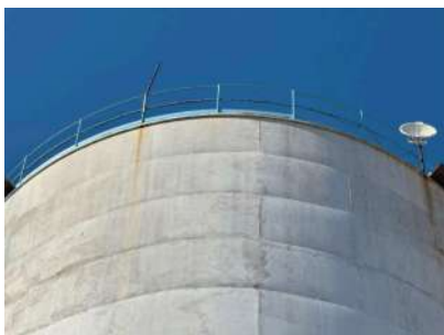
Foto 7 - Detalhe do guarda-corpo
