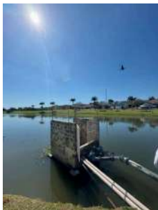
Foto 5 - Vista geral da captação
