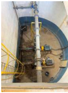
Foto 5 - Vista geral da casa de bombas
