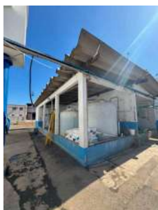
Foto 27 - Casa de armazenamento químico
