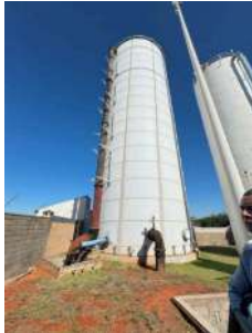
Foto 5 - Vista geral do reservatório
