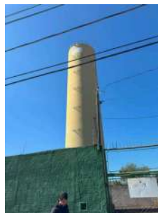
Foto 2 - Vista do reservatório
