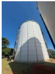
Foto 4 - Vista do reservatório
