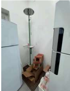
Foto 5 - Chuveiro de emergência
