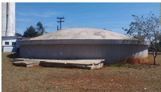
Foto 5 - Vista geral do reservatório semi enterrado.
