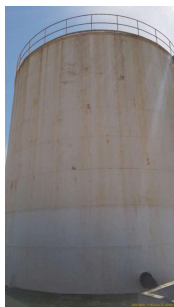
Foto 11 - Reservatório Dona Margarida em Santa Bárbara DOeste
