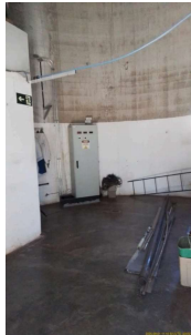
Foto 5 - Interior da base do Reservatório Elevado Vila Brasil em Santa Bárbara DOeste
