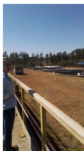
Foto 20 - Decantadores da ETE Toledos II em Santa Bárbara DOeste
