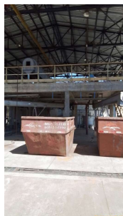
Foto 24 - Retirada de lodo da ETE Toledos II em Santa Bárbara DOeste
