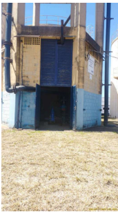
Foto 2 - Vista geral da edificação que abriga a estação elevatória.
