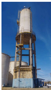
Foto 4 - Vista geral do reservatório elevado.
