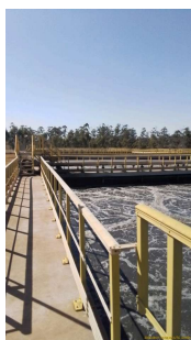
Foto 19 - Aeração da ETE Toledos II em Santa Bárbara DOeste
