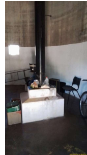
Foto 6 - Interior da base do Reservatório Elevado Vila Brasil em Santa Bárbara DOeste
