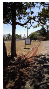
Foto 2 - Identificação do Reservatório Elevado Vila Brasil em Santa Bárbara DOeste
