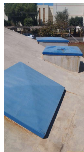
Foto 9 - Tampas de inspeção no topo do reservatório.
