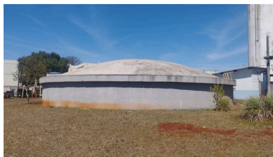
Foto 6 - Vista geral do reservatório semi enterrado.
