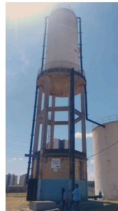
Foto 3 - Vista geral do reservatório elevado.
