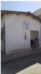
Foto 2 - Placa de identificação da Elevatória de esgoto da ETE Toledos II em Santa Bárbara DOeste
