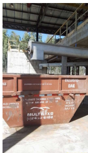
Foto 23 - Retirada de lodo da ETE Toledos II em Santa Bárbara DOeste
