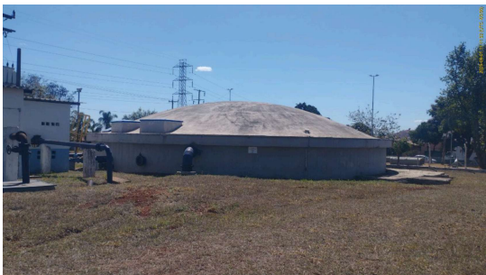
Foto 4 - Vista geral do reservatório semi enterrado.
