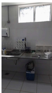
Foto 3 - Laboratório da ETE Toledos II em Santa Bárbara DOeste
