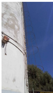
Foto 1 - Guarda-corpo do Reservatório Elevado Vila Brasil em Santa Bárbara DOeste
