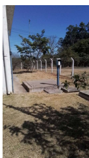
Foto 10 - Elevatória de esgoto da ETE Toledos II em Santa Bárbara DOeste
