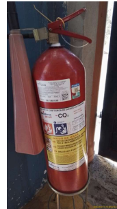
Foto 4 - Extintor de incêndio do elevatória de água do Reservatório Vila Brasil em Santa Bárbara DOeste
