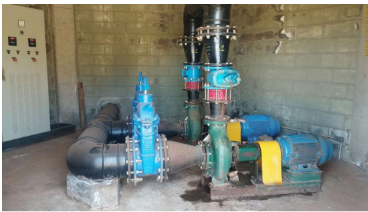
Foto 3 - Vista geral da estação elevatória.
