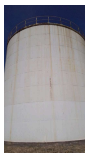
Foto 8 - Reservatório Dona Margarida em Santa Bárbara DOeste
