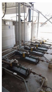
Foto 26 - Centrifugas de lodo da ETE Toledos II em Santa Bárbara DOeste
