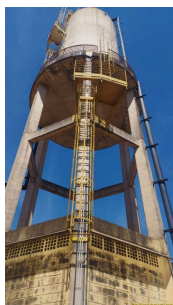
Foto 6 - Detalhe das escadas e guarda corpos.
