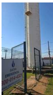
Foto 1 - Placa de identificação e reservatório ao fundo.
