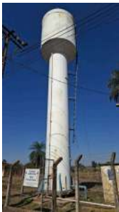
Foto 3 - Vista da entrada.
