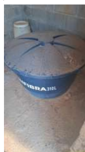
Foto 10 - Armazenamento de hipoclorito de sódio.
