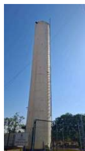
Foto 9 - Vista geral do reservatório.
