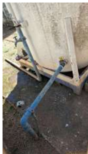
Foto 9 - Tubulação de saída.
