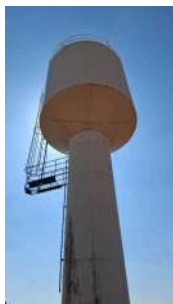
Foto 7 - Vista traseira do reservatório.
