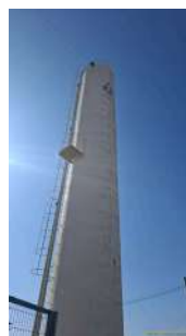
Foto 2 - Vista geral do reservatório.
