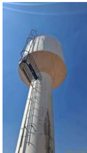
Foto 5 - Detalhe da escada marinheiro.
