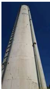
Foto 10 - Tubulação de alimentação.
