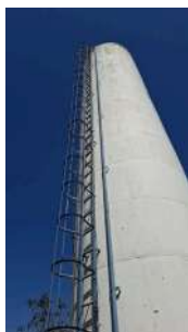
Foto 7 - Tubulação de alimentação.
