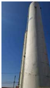
Foto 3 - Vista lateral do reservatório.
