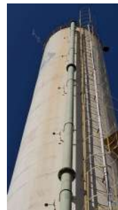
Foto 13 - Detalhe do topo do reservatório.
