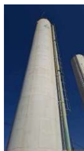
Foto 7 - Tubulação de alimentação.
