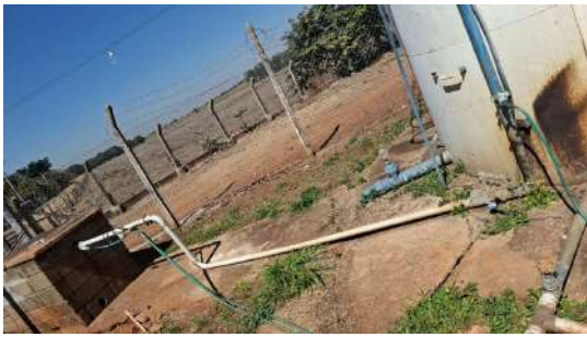
Foto 11 - Poço que abastece o reservatório.
