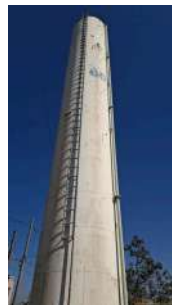
Foto 4 - Escada e tubulação.
