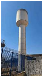
Foto 1 - Vista do reservatório.
