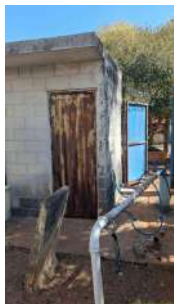
Foto 7 - Cavaite e abrigo dos produtos químicos.
