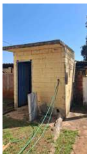
Foto 13 - Abrigo dos produtos químicos.
