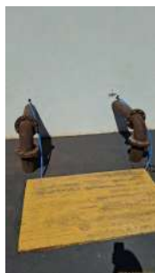
Foto 11 - Tapa do poço da elevatória de esgoto bruto.
