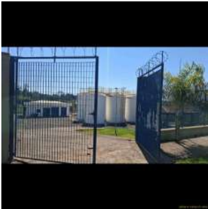
Foto 1 - Entrada da ETE.
