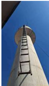
Foto 7 - Detalhe da escada.
