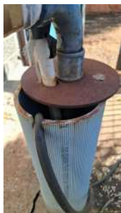
Foto 1 - Tubo do poço aberto.
