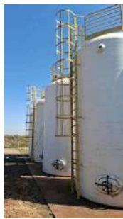
Foto 23 - Guarda-corpos e escadas.
