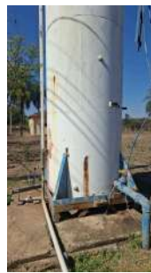
Foto 6 - Base do reservatório.
