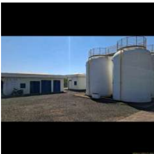
Foto 3 - Vista geral da ETE.
