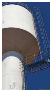
Foto 2 - Suportes isoladores sem cabeamento.
