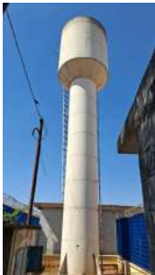
Foto 3 - Vista frontal do reservatório.
