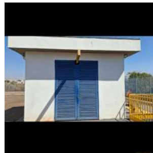
Foto 16 - Casa de bombas da elevatória.
