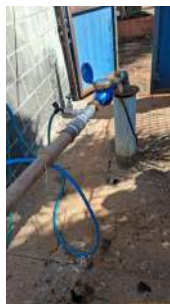
Foto 6 - Poço e cavaite.
