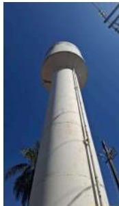
Foto 7 - Tubulação de alimentação.
