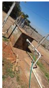
Foto 2 - Vista do abrigo do poço.
