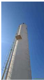
Foto 10 - Vista frontal do reservatório.
