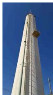
Foto 5 - Tubulação de alimentação e escada marinheiro.
