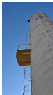
Foto 9 - Plataforma de descanso da escada marinheiro.
