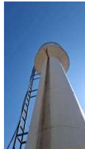
Foto 8 - Vista lateral do reservatório.
