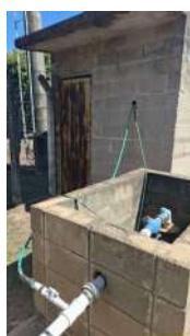
Foto 7 - Torneira onde é inserido o hipoclorito de sódio.
