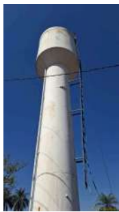
Foto 5 - Vista do reservatório.
