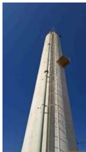
Foto 12 - Detalhe da escada marinheiro.
