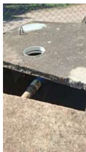
Foto 5 - Tampa de fechamento do cavalete do poço.
