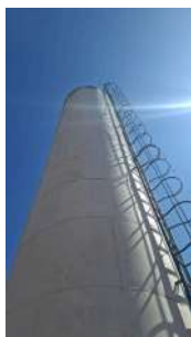
Foto 3 - Vista lateral do reservatório.
