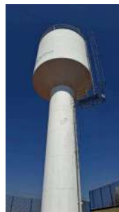
Foto 8 - Vista lateral do reservatório.
