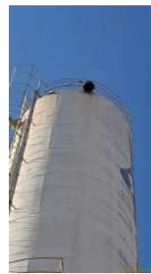
Foto 11 - Detalhe do extravasor no topo do reservatório.
