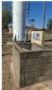
Foto 3 - Poço e reservatório ao fundo.
