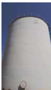
Foto 7 - Guarda-corpo na cobertura.
