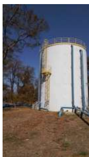
Foto 11 - Escada para acessar a cobertura.
