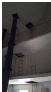
Foto 9 - Escadas no interior do reservatório.
