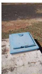
Foto 10 - Tampa de inspeção.
