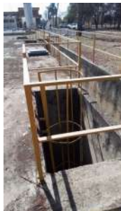
Foto 5 - Guarda-corpo e escada para manutenção.
