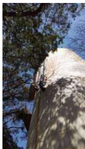
Foto 10 - Escadas para manutenção do reservatório.
