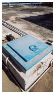
Foto 5 - Tampa de inspeção.
