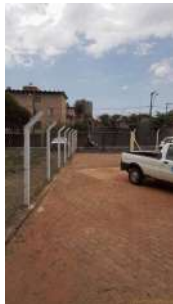
Foto 1 - Cerca e portão de acesso.
