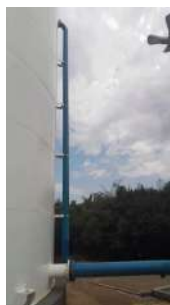
Foto 2 - Alimentação do reservatório e saída.
