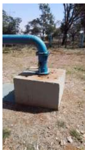
Foto 1 - Proteção do poço.
