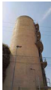
Foto 2 - Visão geral do reservatório.
