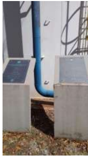
Foto 1 - Placas de identificação.
