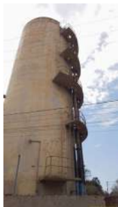
Foto 3 - Reservatório e muro na entrada.
