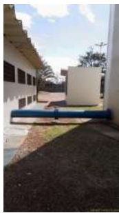
Foto 9 - Tubulação que provém do R38 e vai para elevatória Planalto, a qual recalca para o R20, Flora e ETA Paiol.
