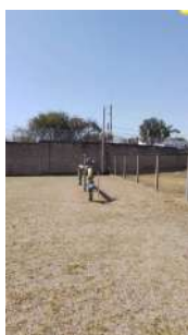
Foto 10 - Cavalete na entrada do reservatório
