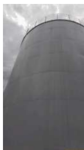
Foto 4 - Guarda-corpo na cobertura.
