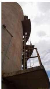
Foto 1 - Escada externa com guarda-corpo.
