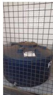
Foto 4 - Armazenamento de cloro
