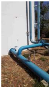
Foto 5 - Saída do reservatório e macromedidor.
