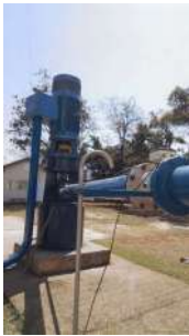
Foto 4 - Recalque do poço.
