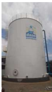
Foto 1 - Visão geral do reservatório.
