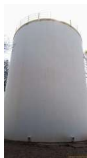
Foto 8 - Guarda-corpo na cobertura.
