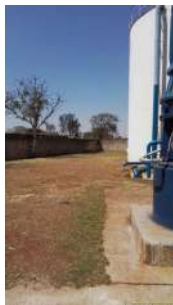
Foto 1 - Muro no perímetro na área
