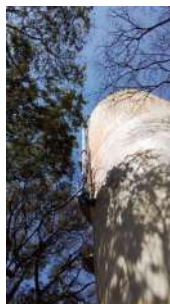
Foto 11 - Escadas para manutenção do reservatório.
