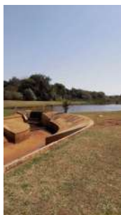
Foto 3 - Barramento da captação.
