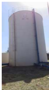
Foto 10 - Visão geral do reservatório.
