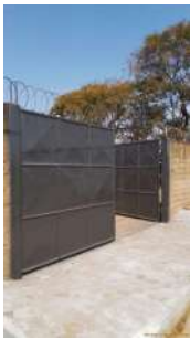
Foto 2 - Portão de acesso.
