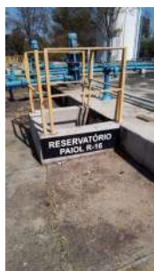
Foto 3 - Identificação do reservatório.
