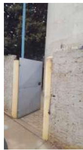
Foto 2 - Portão de acesso.
