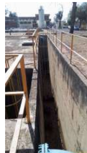
Foto 6 - Guarda-corpo e escada para manutenção. Extravasores.
