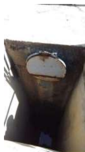
Foto 4 - Extravasor de uma das câmaras.
