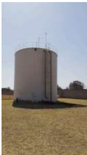
Foto 1 - Visão geral do reservatório.
