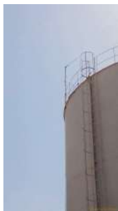
Foto 9 - Escada e guarda-corpo.
