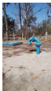
Foto 4 - Abertura na tela de proteção.
