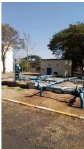
Foto 1 - Visão geral do reservatório R16, composto por 2 câmaras.
