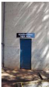
Foto 1 - Identificação do reservatório
