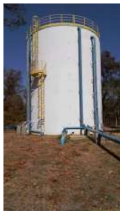
Foto 3 - Visão geral do reservatório.
