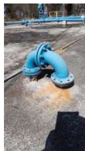
Foto 6 - Tubo para ventilação com tela de proteção.
