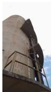
Foto 2 - Escada externa com guarda-corpo.
