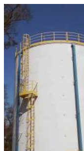
Foto 12 - Escada a guarda-corpo.
