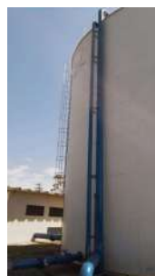
Foto 8 - Escada com proteção.
