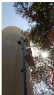
Foto 12 - Escadas para manutenção do reservatório
