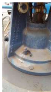
Foto 5 - Tubo para medição do nível.
