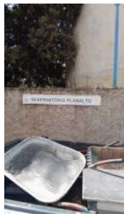
Foto 1 - Identificação do reservatório.
