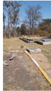
Foto 2 - Visão geral do reservatório.
