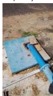
Foto 8 - Tampa de inspeção.
