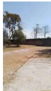
Foto 2 - Muro e portão
