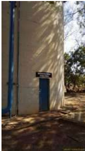
Foto 1 - Identificação do reservatório.
