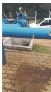
Foto 6 - Torneira para coleta de água bruta. Não há aplicação de produtos químicos nesse sistema de produção de água pois a água é encaminhada para a ETA Fonte.
