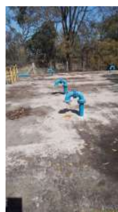
Foto 2 - Tela de proteção não estava vedando corretamente a ventilação.
