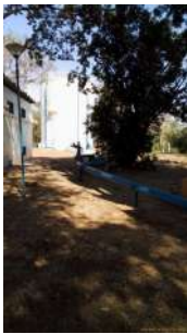
Foto 3 - Tubulação de alimentação do reservatório, proveniente do poço Paiol e reservatório metálico.
