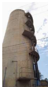
Foto 6 - Escadas para acessar a cobertura.
