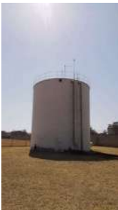
Foto 2 - Reservatório Dahma III
