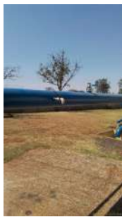
Foto 1 - Torneira para coleta de água bruta
