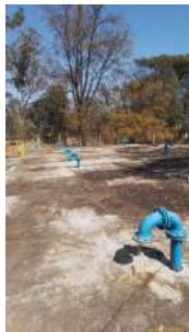
Foto 3 - Ventilação do reservatório.
