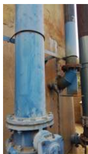
Foto 3 - Tubulação de saída do reservatório.
