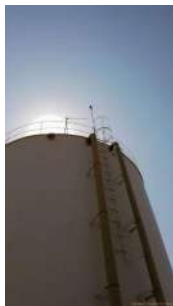
Foto 1 - Guarda-corpo na cobertura do reservatório.
