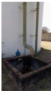
Foto 1 - Extravasor do reservatório.
