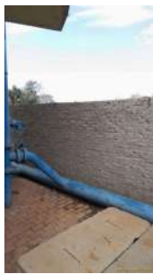
Foto 1 - Muro no perímetro da área
