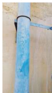
Foto 4 - Alimentação do reservatório.
