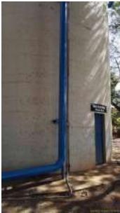
Foto 2 - Alimentação do reservatório.
