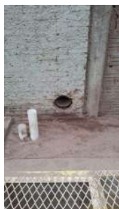
Foto 3 - Saída do extravasor.
