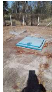
Foto 4 - Tampa de inspeção.
