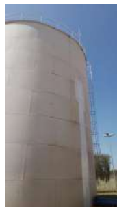
Foto 2 - Visão geral do reservatório.
