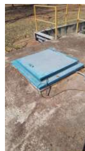
Foto 8 - Tampa de inspeção.
