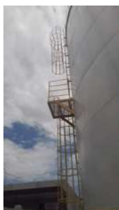
Foto 3 - Escada com proteção.
