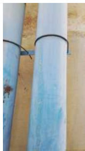
Foto 1 - Identificação do extravasor.
