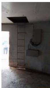
Foto 8 - Escada na antecâmara do reservatório.
