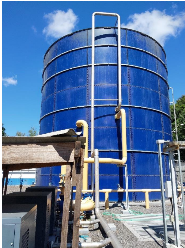
Figura 18 - Reator da Estação de Tratamento de Esgoto
