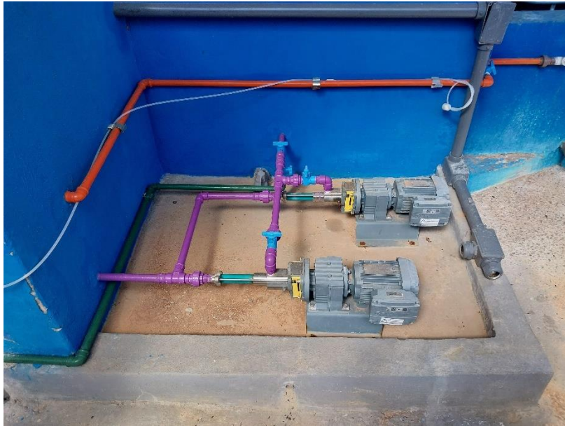
Figura 7 – Bombas de cloro
