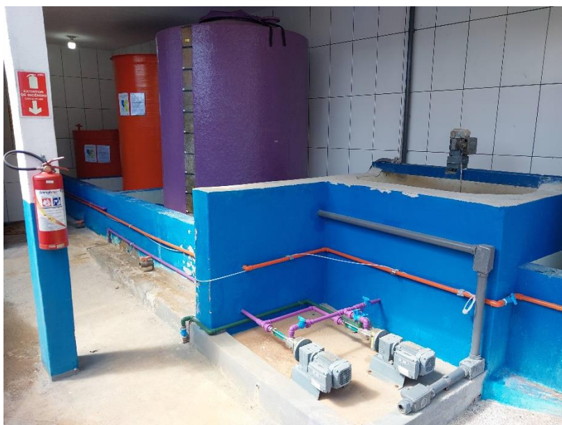
Figura 6 – Bombas de cloro e tanque de Geocálcio
