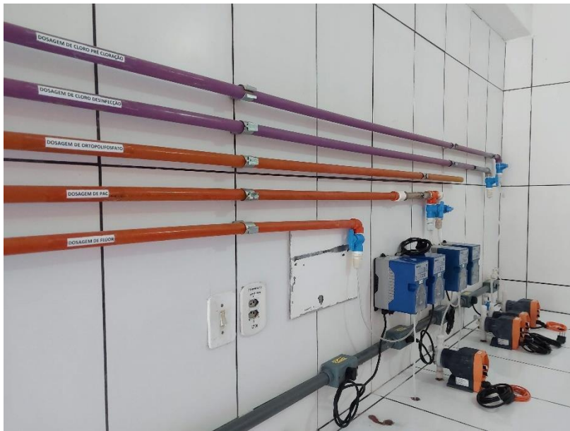
Figura 8 - Bombas dosadoras e tubulações de produtos químicos
