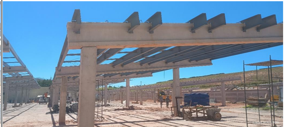
Foto 2 – Estruturas e base dos painéis fotovoltaicos.
