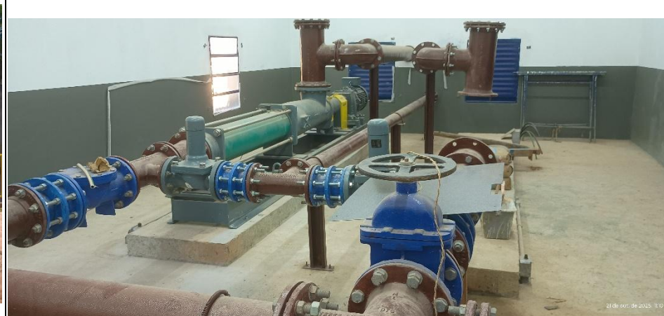
Foto 4 – Equipamentos de bombeamento da nova EEE.
