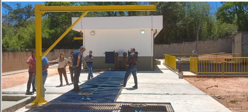
Foto 3 – Nova casa de bombas, canal de chegada do esgoto e gradeamento da EEE Centenário.
