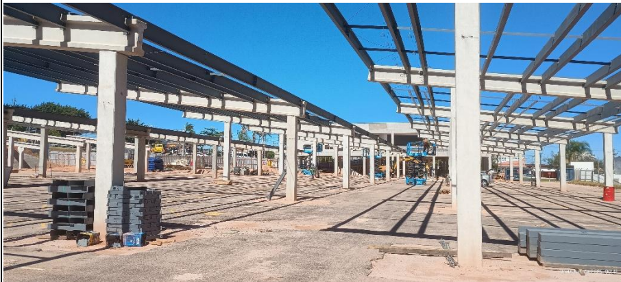
Foto 1 – Estruturas e base dos painéis fotovoltaicos.
