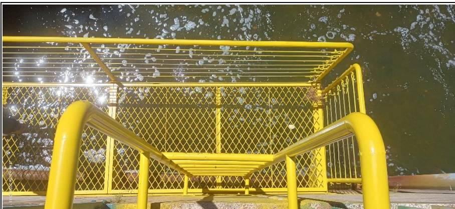
Foto 1 – Escada e passarela de acesso para inspeções abaixo da barragem.
