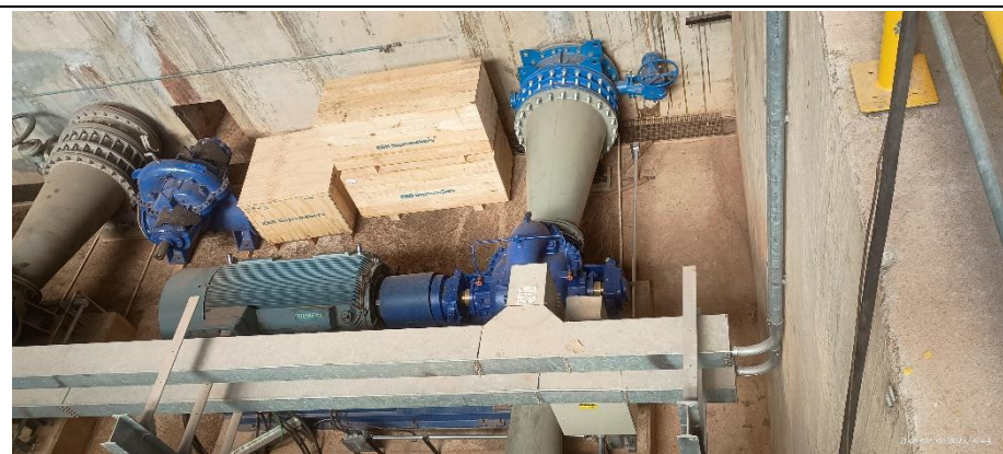
Foto 2 – Novos equipamentos da bomba 6 da CB5.
