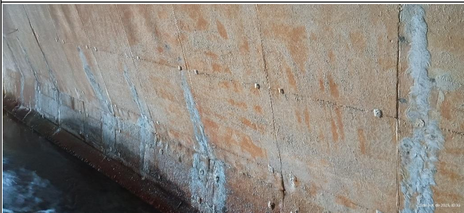
Foto 3 – Adequação de infiltrações na galeria de descarga.
